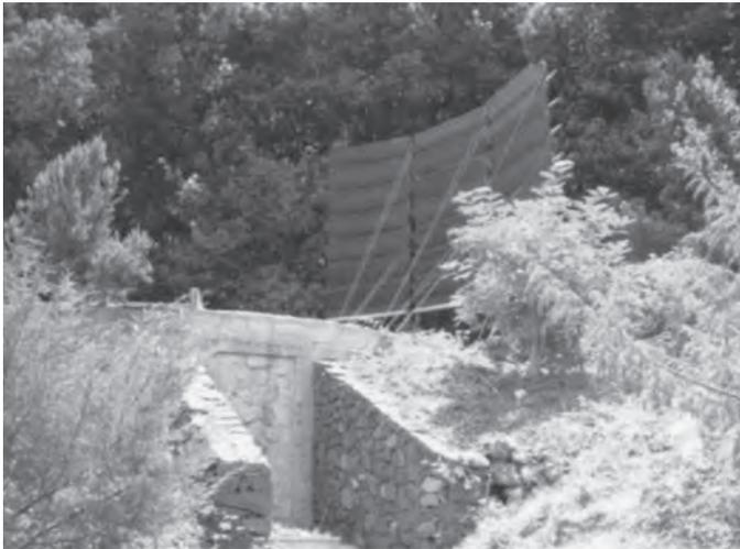
Fig.11. Instalación de captador de lluvia horizontal y depósito para área recreativa.
