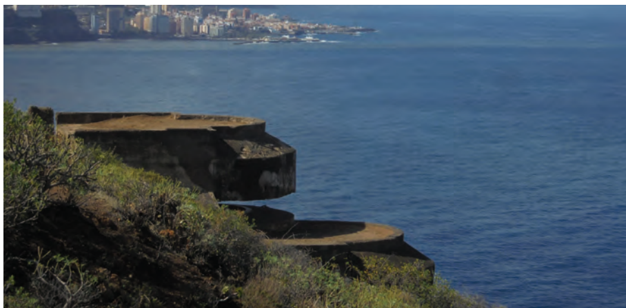
Fig. 20. Búnker de La Quinta Roja, controlando el acceso marítimo al Puerto de la Cruz.
