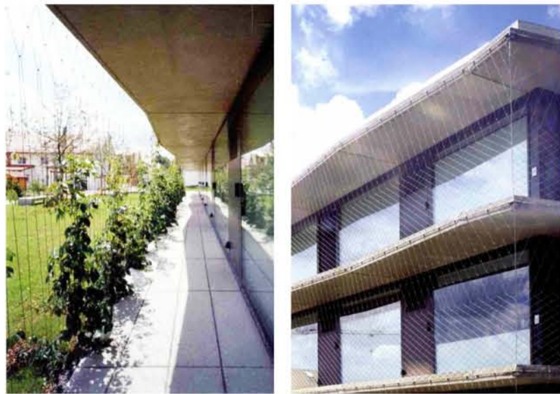
REFERENCIA FACHADA CON MALLA METALICA DE ACERO INOXIDABLE
