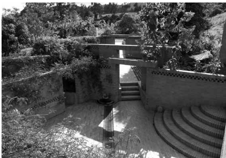
Figura 11. Casa en Río Frío, Tabio. Fotografía Rogelio Salmons. Fuente: Fundación Rogelio Salmons
