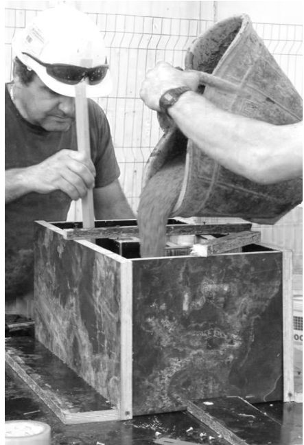
proceso de construcción de la maqueta de hormigón
