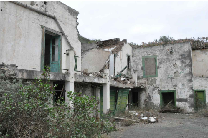
Vista exterior del estado de la fachada Exterior view of the state of the facade
