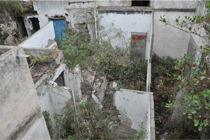
Vista exterior del estado de las estancias External view of the state of the rooms
