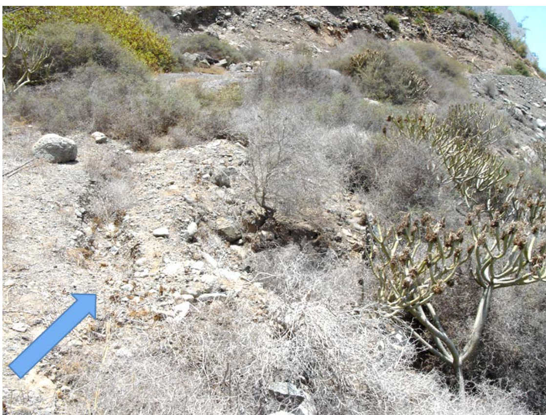
Figura 7.27 Detalle de grieta en la coronación de un relleno sin consolidar en el barranquillo de Amadores que parece indicar la existencia de una superficie de deslizamiento.
