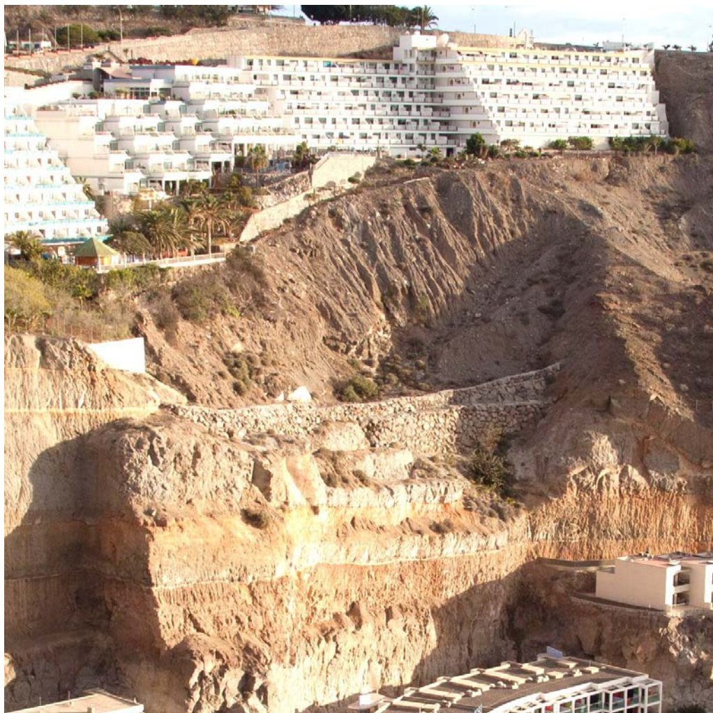
Figura 7.23 Vertidos de residuos de construcción y demolición en la base de los apartamentos. Los depósitos antrópicos presentan fuertes pendientes y tienen incisiones activas.
