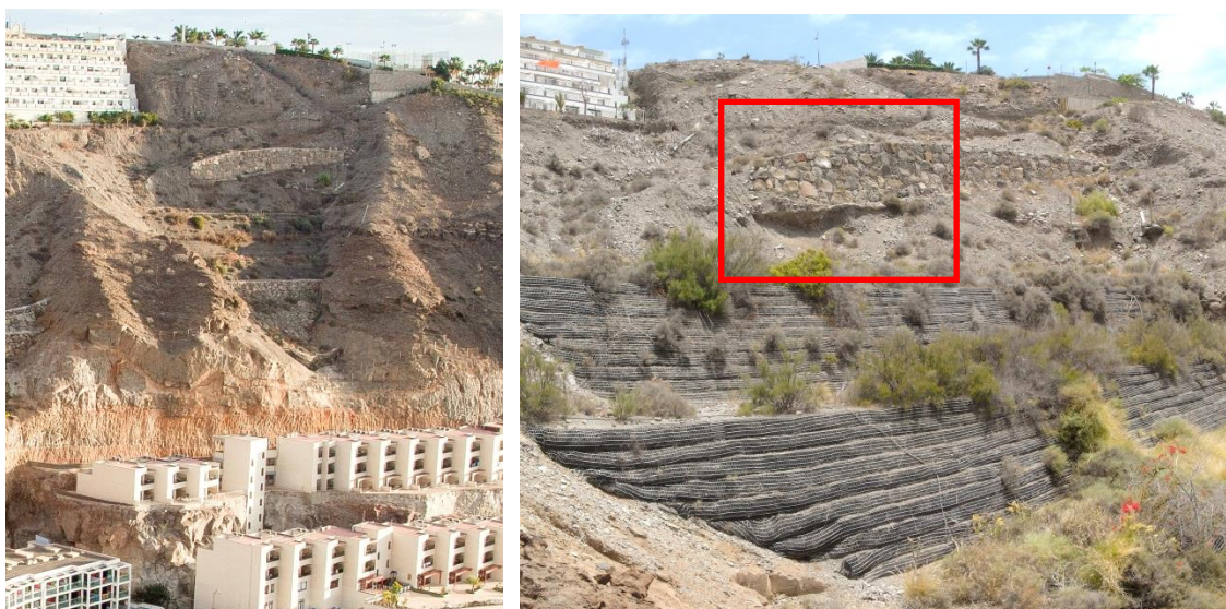
Figura 7.32 Muros construidos en ladera sobre rellenos sin consolidar. Izquierda: vista general; derecha: detalle de muro descalzado.
