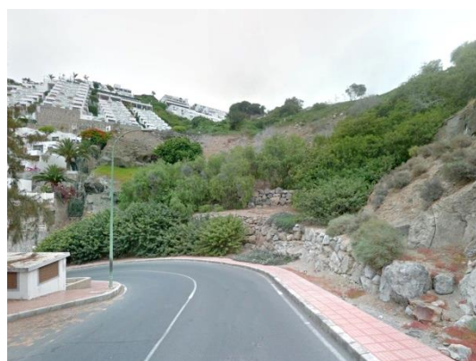
Figura 7.25 Relleno en barranquillo situado entre el Barranco de Puerto Rico y el barranco de Amadores
