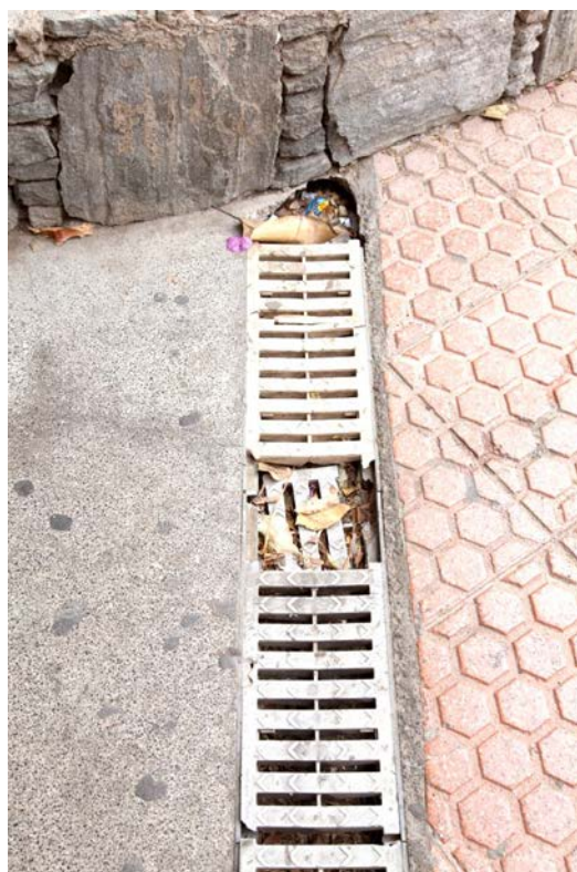
Figura 9.11. Sumidero de reducidas dimensiones completamente obstruido en el paso peatonal bajo la carretera GC-500 (Marzo de 2012).
