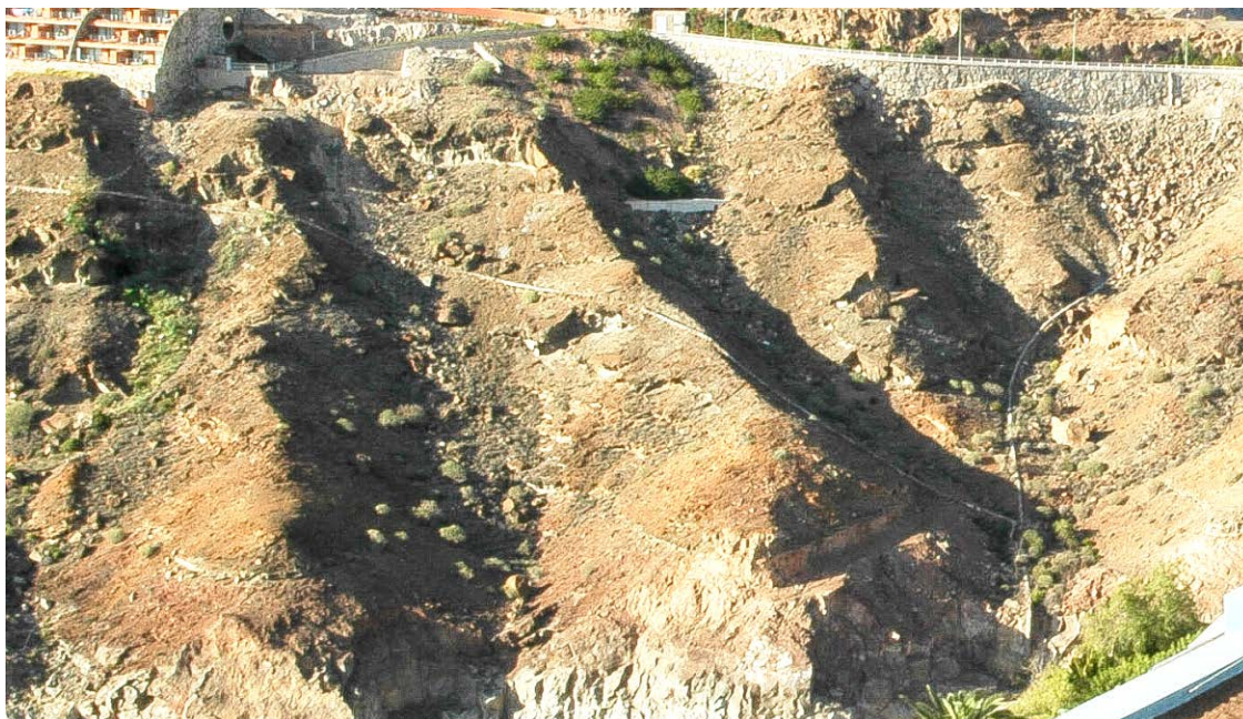
Figura 5.5 Canalizaciones colocadas sobre la ladera del barranquillo de Amadores.
