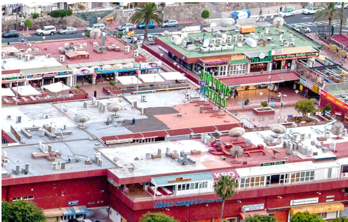
Figura 5.10. Cubierta del centro comercial situado en el fondo del barranco de Puerto Rico
