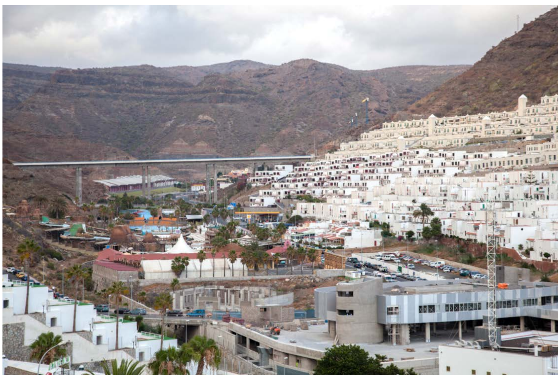
Figura 5.11. Viaducto de la autopista GC-1 “sobrevolando” el espacio urbano
