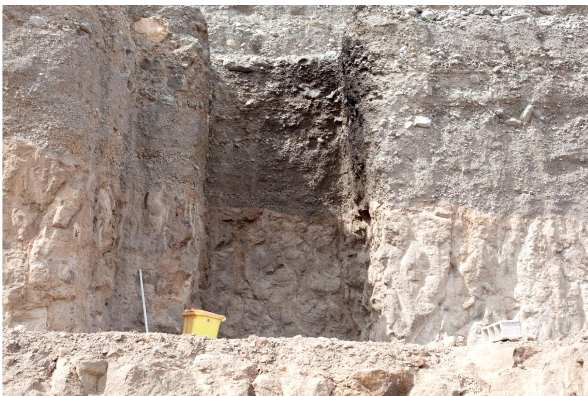
Figura 7.15 Desmonte en Montaña de Amadores, excavado en Formación Detrítica Las Palmas, a techo e ignimibritas traquíτικο-riolíticas en la base.
