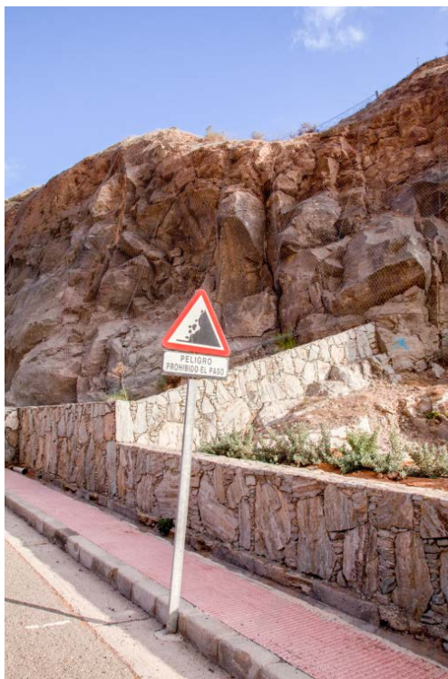
Figura 7.29. Aviso de caída de rocas en calle de Amadores
