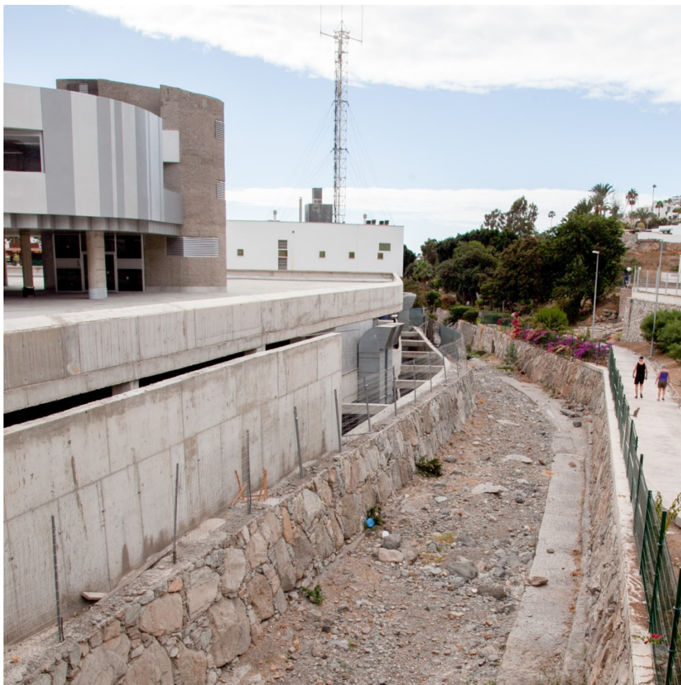
figura 9.6 Edificaciones adyacentes al canal de Puerto Rico, con sótanos situados a menor cota.
