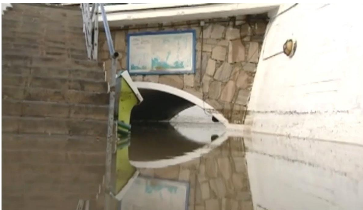
figura 9.5. Inundaciones en el paso peatonal bajo la carretera GC-500 (noviembre de 2011). Fuente: Antena 3
