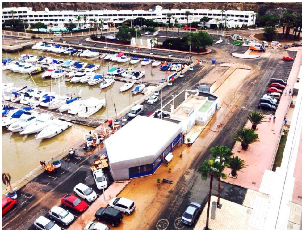
figura 9.4. Sedimentos e inundación en la explanada existente en la desembocadura del barranquillo de Agua de la Perra.
