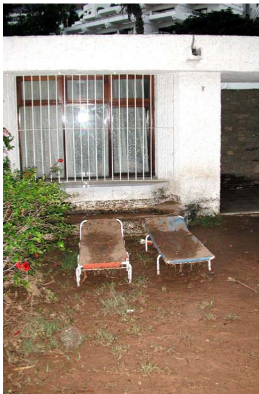
figura 9.7. Inundaciones en apartamentos situados entre la calle Doreste y Molina y la zona verde del cauce del barranco de Puerto Rico, cerca de su desembocadura (Noviembre de 2001).
