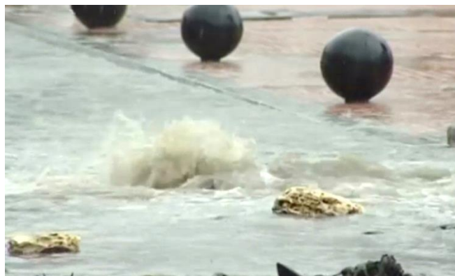
Figura 9.10. Rebose de la red de aguas residuales a través de la boca de un pozo de registro situado en la calle Doreste y Molina
