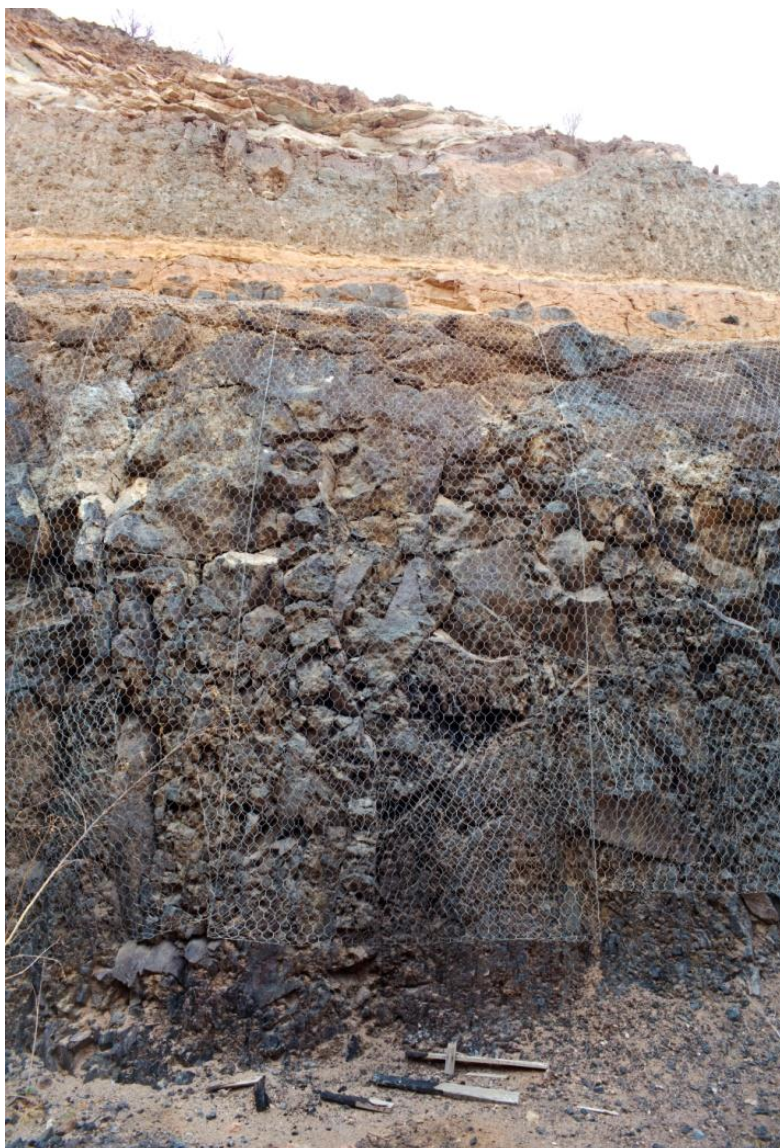
Figura 7.22 Toba vitrofídica traquítico-riolítica con malla galvanizada para evitar desprendimientos
