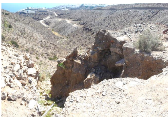
Figura 7.24 Erosiones en los rellenos realizados en el cauce del Barranco de Agua de la Perra
