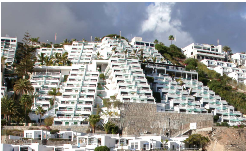
Figura 5.8. Ejemplo de edificio con elevado número de plantas aparentes, construido sobre una ladera. Según la forma de medición de las Normas Subsidiarias (Ayuntamiento de Mogán, 1.987), este edificio no excede el número de plantas permisibles (2).
