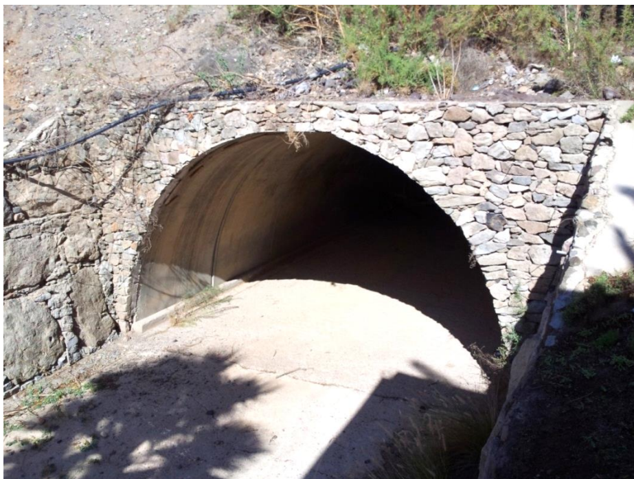
figura 9.2 Reducción de la sección útil del canal bajo el ramal de conexión con el barranco de El Lechugal.
