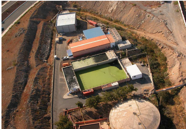
Figura 1.7: Vista aérea de la zona de tratamiento terciario. Hoya del Pozo (Telde).
