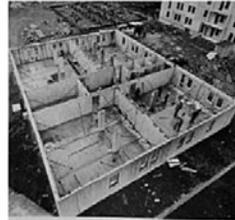
Componentes de los encofrados y módulo tipo.
