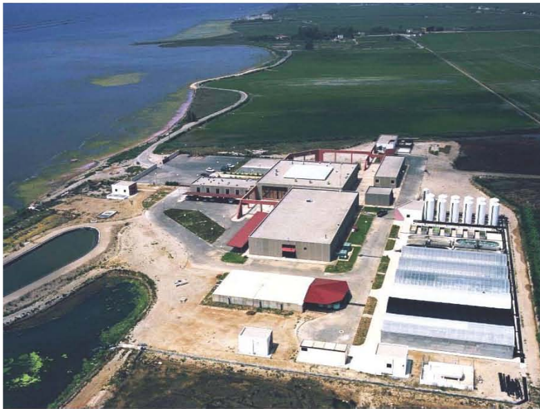
Fig.4.1 Vista aérea de las instalaciones de Sant Carles de la Ràpita– Institut Recerca i Tecnologia Agroalimentàries, IRTA-SCR, donde se ha llevado a cabo este estudio.
