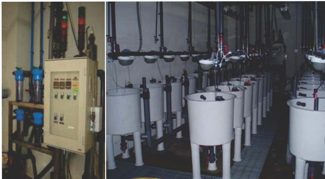
Fig.4.3.1 Sala de cultivo larvario de las instalaciones de la hatchery de el IRTA-SCR
