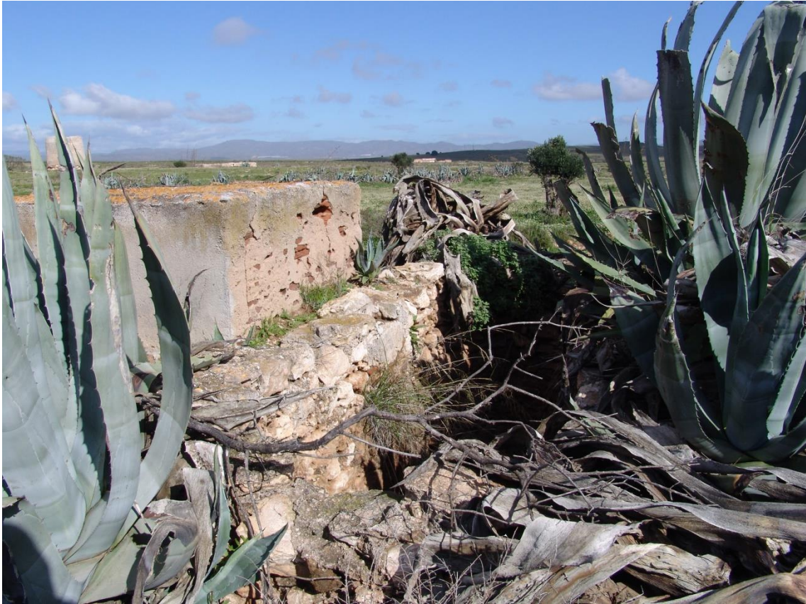
Fotografía 8.47: en el centro, vista del pozo que alimentaba al depósito de distribución de agua (a la izquierda). El depósito transfería parte del agua extraída a la marea. Captura del 4 de marzo del 2010
