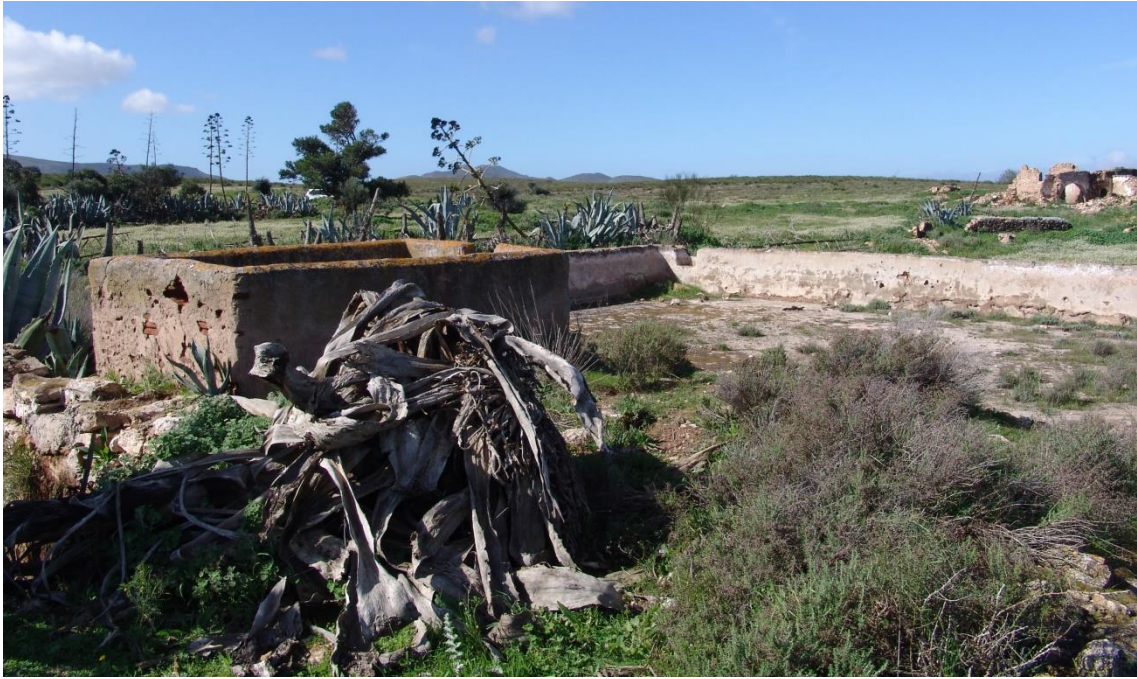
Fotografía 8.49: a la izquierda, depósito de distribución del agua que recibía desde el pozo. Una parte del agua del depósito alimentación a la mareta y, otra parte, a una acequia de servicios, adosada al exterior del pretil de la balsa. Captura del 4 de marzo del 2010
