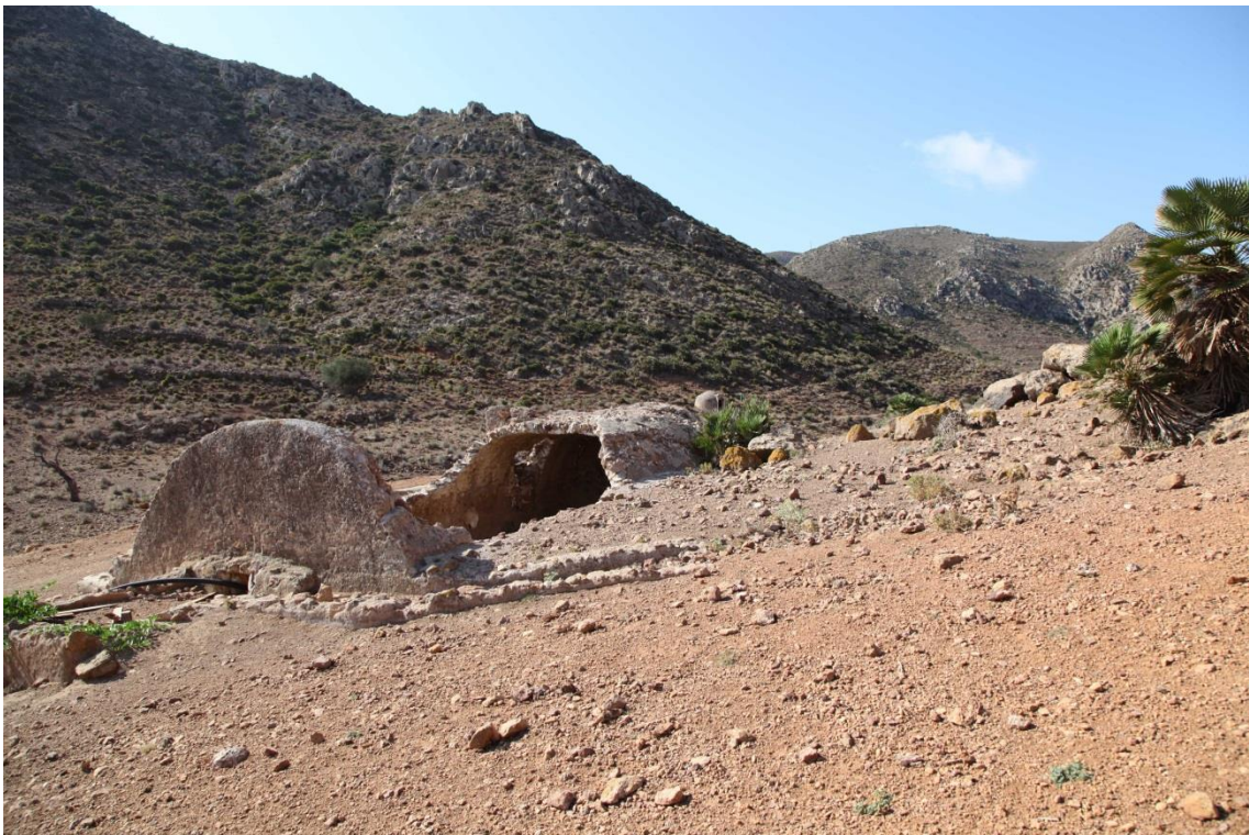
Fotografía 8.18: trasera del aljibe de bóveda de cañón en el Cortijo de Requena, donde se aprecia el canal de captación y el decantador previo al depósito del aljibe. Captura del 31 de julio de 2014
