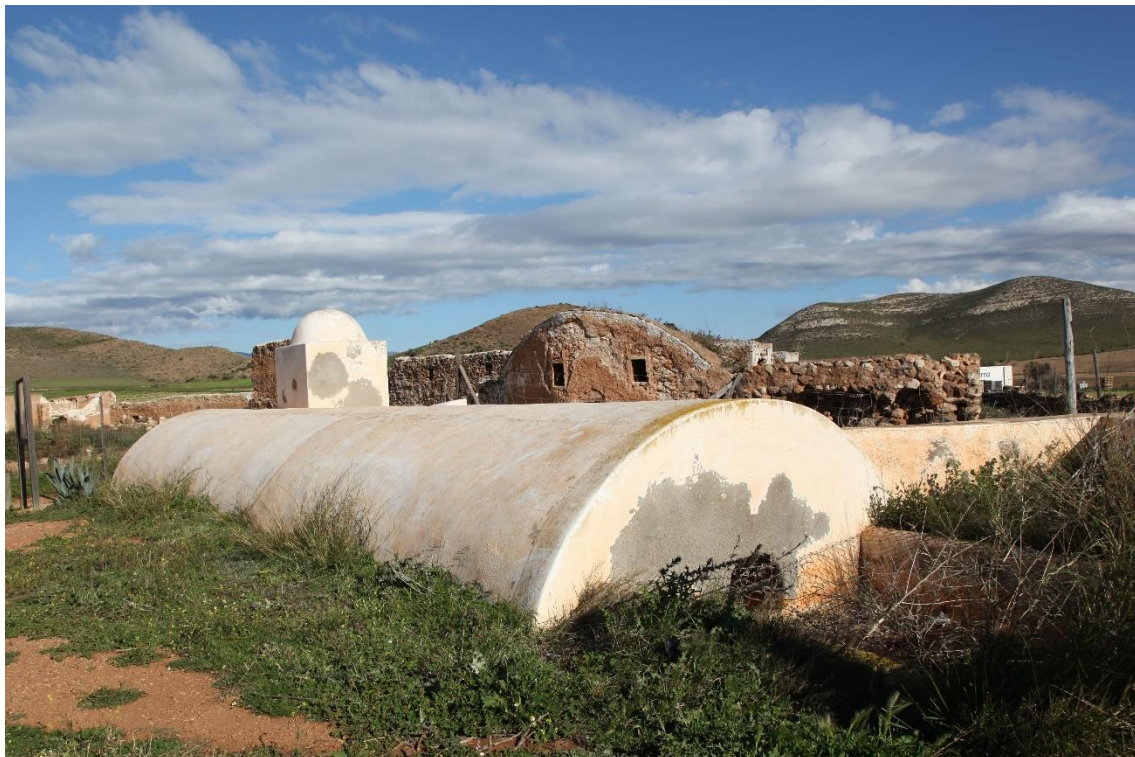
Fotografía 8.63: fachada occidental, y transversal a la bóveda, de la cochineria en hilera del Cortijo del Fraile, tras el aljibe restaurado (pero sin mantenimiento actual) más próximo de la casa-vivienda. Captura del 21 de marzo de 2018
