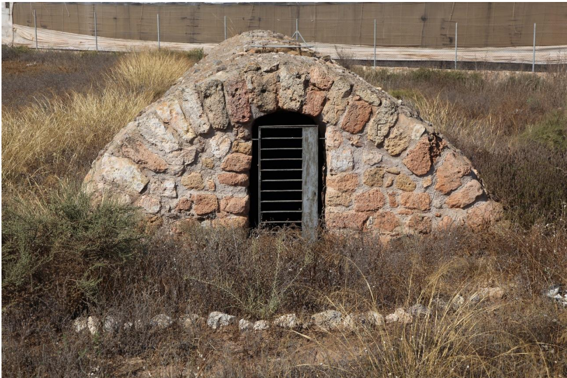
Fotografía 8.28: detalles de la cara frontal del Aljibe Bermejo desde una escalera de mano colocada en el exterior de la valla de protección. El aljibe se encuentra en las proximidades del núcleo urbano de Campohermoso (Níjar). Captura del 9 de agosto de 2017, cuando reinaba un viento del sur con polvo en suspensión
