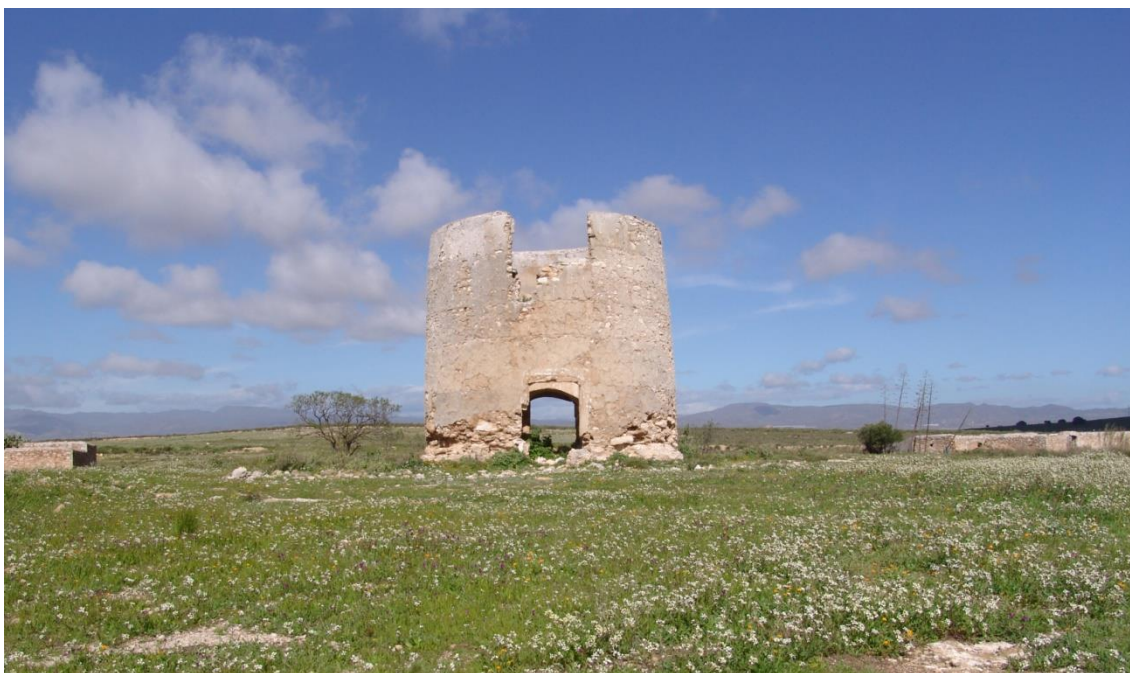
Fotografía 8.97: fachada oriental del molino de viento en estado ruinoso, con cuerpo casi cilíndrico sin escalonar, donde se observa las dos puertas y el hueco para la maquinaria, y la piedra de construcción, en Balsa Blanca (Parque Natural de Cabo de Gata-Níjar, Almería). Captura del 4 de marzo de 2010
