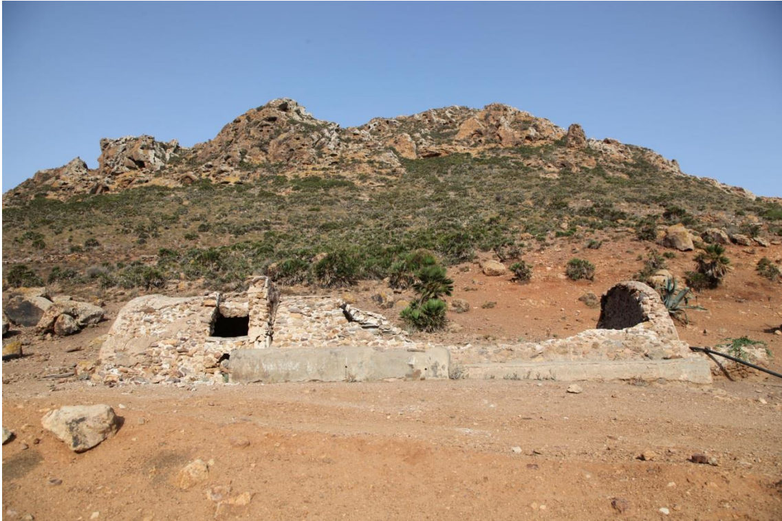
Fotografía 8.19: vista frontal del aljibe de bóveda de cañón en el Cortijo de Requena, con el decantador a la derecha, la puerta de extracción a la izquierda, y los abrevaderos y piletas para el lavado en la zona central. Captura del 31 de julio de 2014
