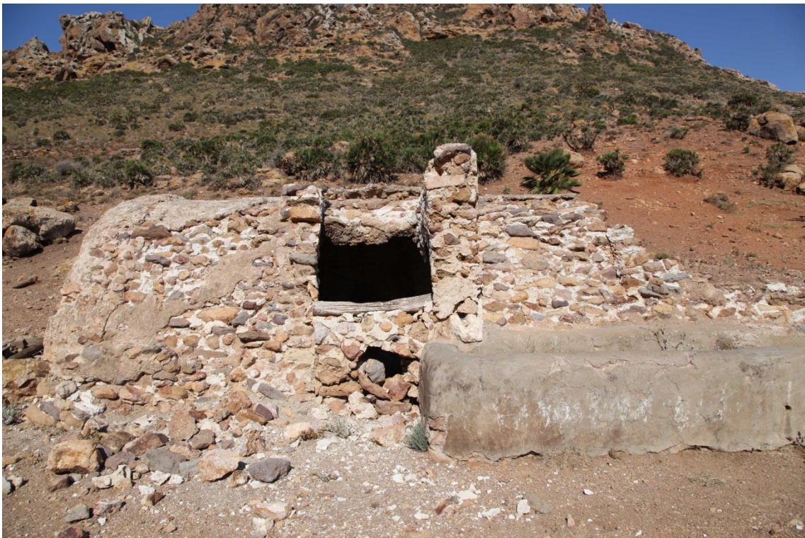
Fotografía 8.20: hueco de la puerta de extracción del agua captada y almacenada en el aljibe de bóveda de cañón en el Cortijo de Requena. Se aprecia la canaleta que conducía el agua al primer abrevadero. Captura del 31 de julio de 2014
