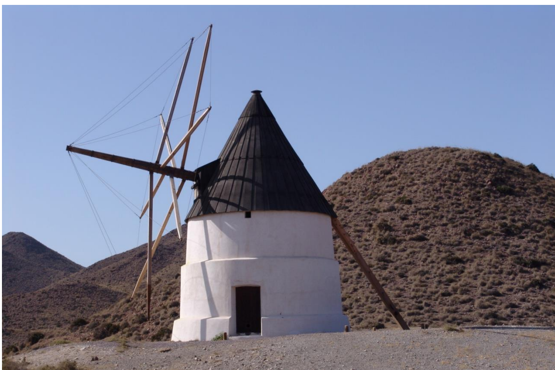
Fotografía 8.91: puerta meridional del molino de viento de chapitel móvil, con cuerpo troncocónico escalonado, en el Cerro del Avemaría, límite con el Campillo de Los Genoveses (Parque Natural de Cabo de Gata-Níjar, Almería). Captura del 12 de agosto de 2008
