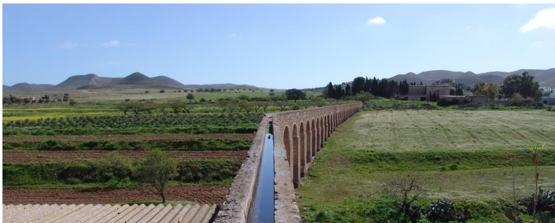
Fotografía 8.53: Acueducto de Fernán Pérez (1906). Vista de superior de la obra hidráulica desde su tramo inicial según el sentido de la circulación del agua. Captura del 4 de marzo de 2010
