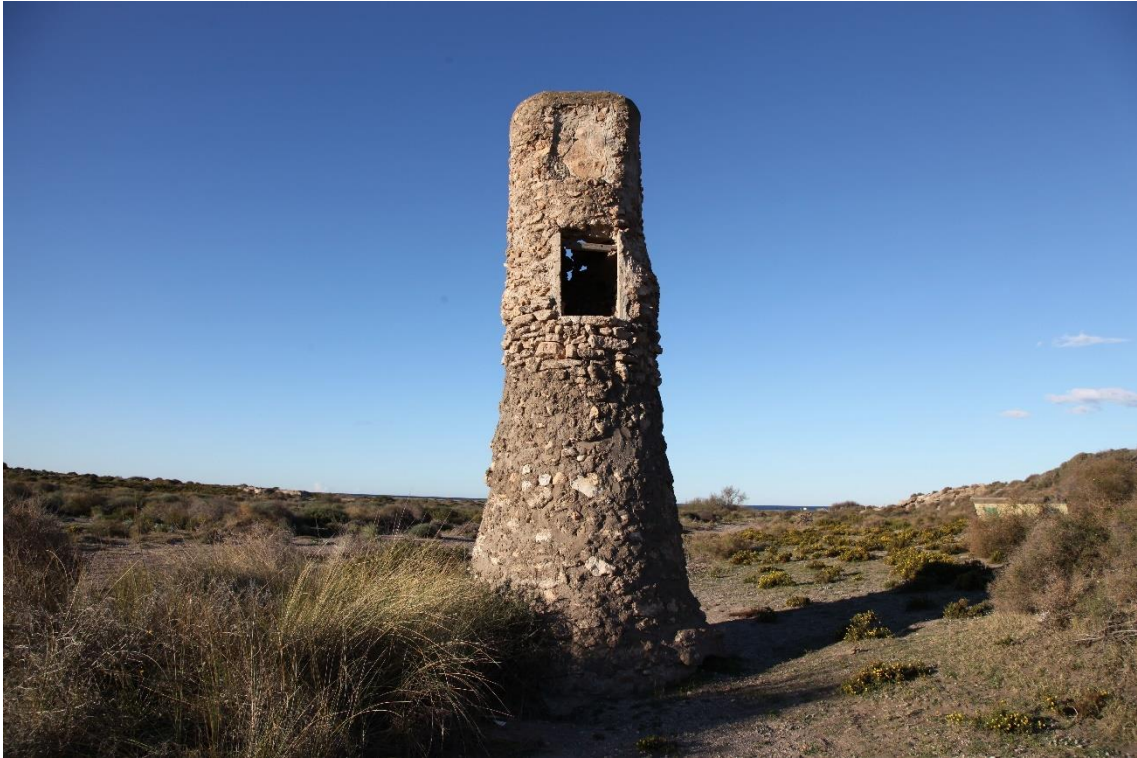
Fotografía 8.39: El Pocico con sus dos puertas más antiguas de explotación del agua en la parte superior de la construcción, cuando el nivel de base del perfil de equilibrio de la rambla estaba más alto respecto al techo del cuerpo de obra externo del pozo. Captura del 26 de marzo de 2018
