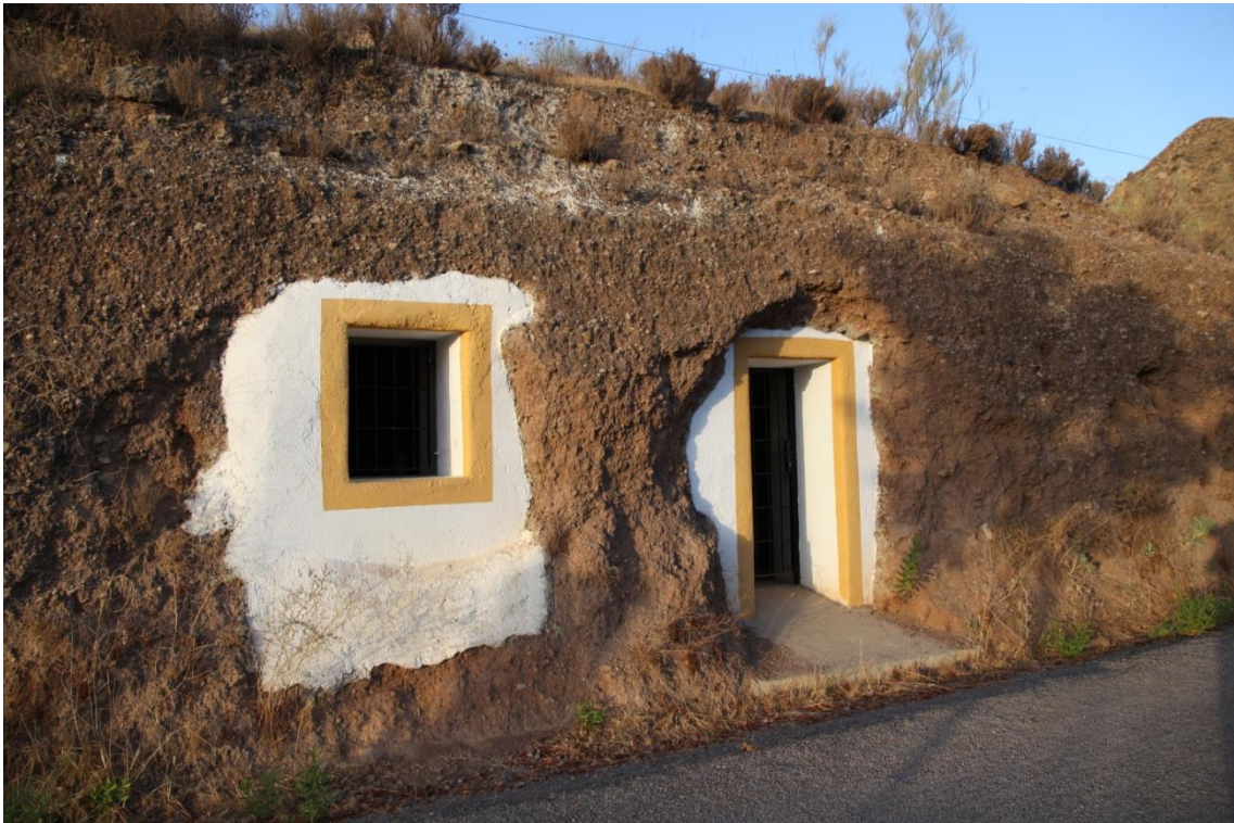
Fotografía 8.127: ejemplo de choza-cueva restaurada, para el mantenimiento del ferrocarril minero entre Lucainena de las Torres (en Sierra Alhamilla) y Agua Amarga (en el Campo de Níjar, a la altura del paraje conocido como Peralejo, en el tramo rehabilitado como Vía Verde. Captura del 5 de octubre de 2012
