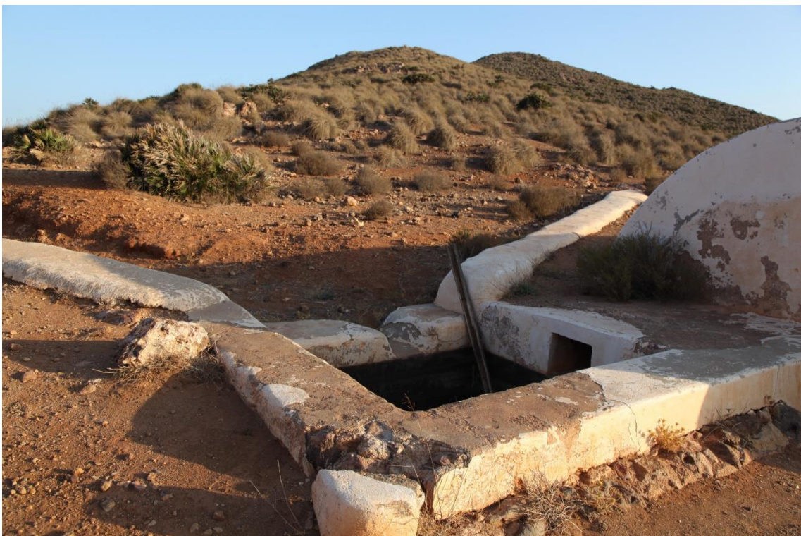
Fotografía 8.16: vista de la balsa de decantación, que recibe la escorrentía desde el área de captación delimitada por muros (para evitar la pérdida del agua), y del tragante. Aljibe de bóveda de cañón de Coyatos (Campo de Níjar, Almería). Captura del 6 de agosto de 2016
