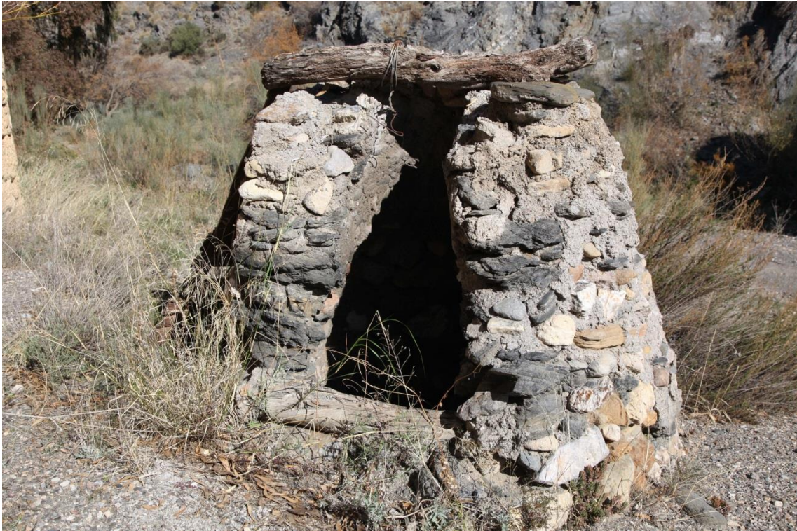
Fotografía 8.37: pozo del Puente La Rafaela en un primer plano. Captura del 21 de enero de 2014
