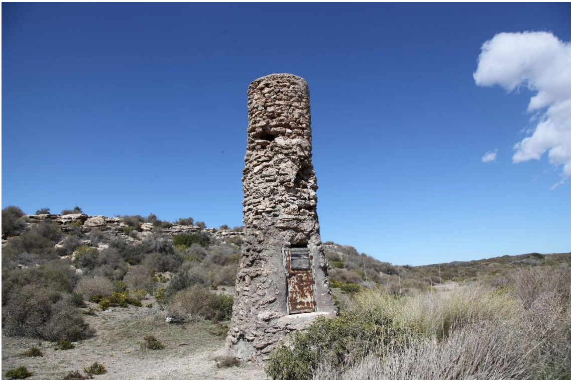
Fotografía 8.40: El Pocico con su puerta de explotación del agua más reciente en la parte inferior de la construcción, al descender el nivel de base de la rambla, en relación con el techo del cuerpo de obra externo del pozo. De este pozo y hasta 1990, se obtuvo potable, aunque algo salobre, según la comunicación personal de don Francisco Vargas (comunicación personal del 26 de marzo de 2018). Captura del 24 de marzo de 2018
