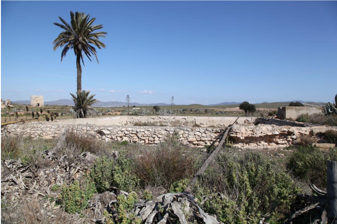
Fotografía 8.45: panorámica de la mareta de Balsa Blanca. A la derecha, y en un plano medio-profundo, se observa el depósito que recibía agua desde el pozo que está a sus pies. Este depósito alimentaba a la mareta y a una acequia de servicios (con un abrevadero y con un lavadero). Captura del 3 de marzo de 2012
