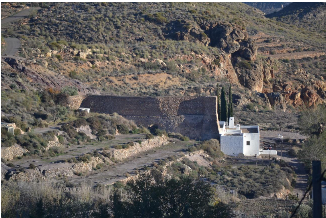
Fotografía 8.114: molino de agua en el tramo medio del Valle de Huebro. En el centro izquierda de la imagen se encuentra la acequia sobre un soporte de obra, a piedra vista, que llega hasta el cubo del molino (centro de la imagen, desplazado hacia la derecha). A la derecha de la imagen destaca, por su cromatismo blanco y mantenimiento, la casa-vivienda de un cortijo. Captura del 7 de diciembre de 2016
