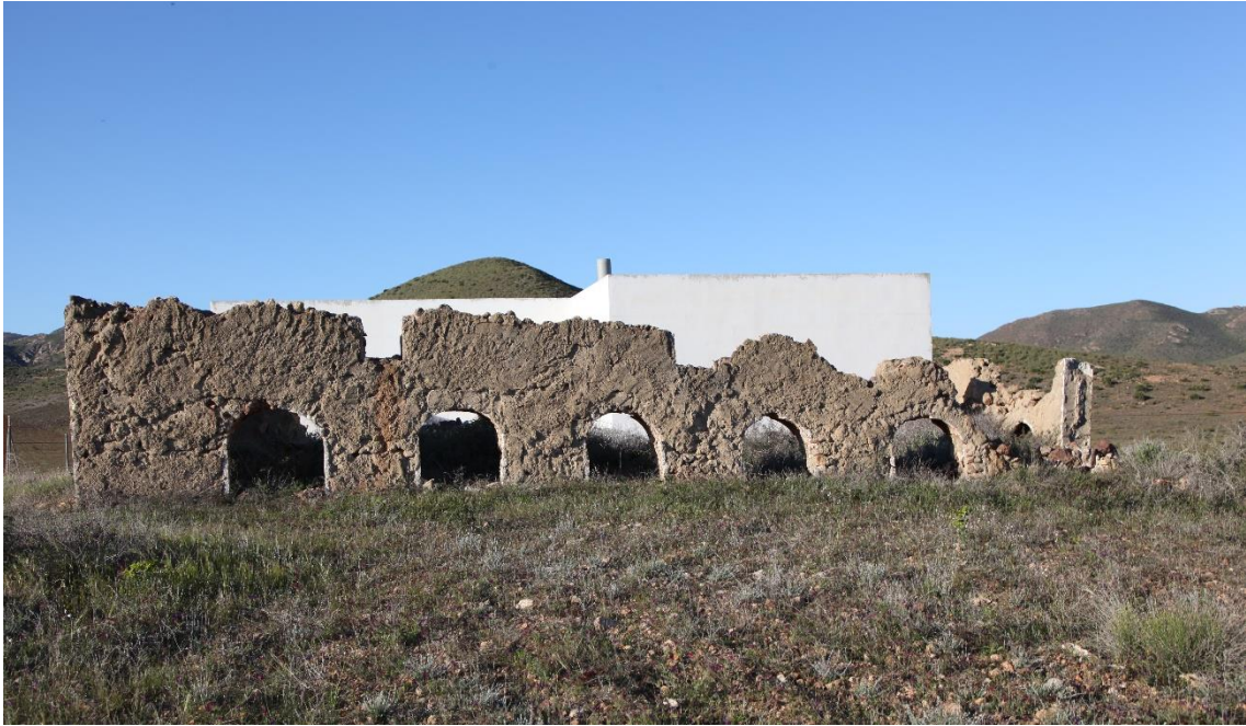
Fotografía 8.73: observación de la fachada norte del sestero ganadero de doña Paca Góngora, parcialmente derrumbado para la construcción de una casa, en Boca de Los Frailes. La toma fotográfica se obtuvo a pesar de la poca colaboración y simpatía de la propietaria de este patrimonio cultural. Se utilizó, fuera de la propiedad, unas escaleras de mano para superar el impacto negativo visual, de una valla de tela metálica, en la imagen del patrimonio pecuario del pasado reciente. Captura del 22 de marzo de 2018
