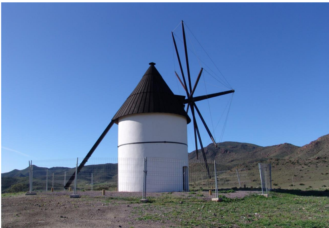
Fotografía 8.88: molino de viento de chapitel móvil, con cuerpo cilíndrico, y con la puerta occidental bajo las aspas (fijas tras la restauración), y la oriental junto al timón, entre el Pozo de Los Frailes y San José (Parque Natural de Cabo de Gata-Níjar, Almería). Captura del 2 de enero de 2010
