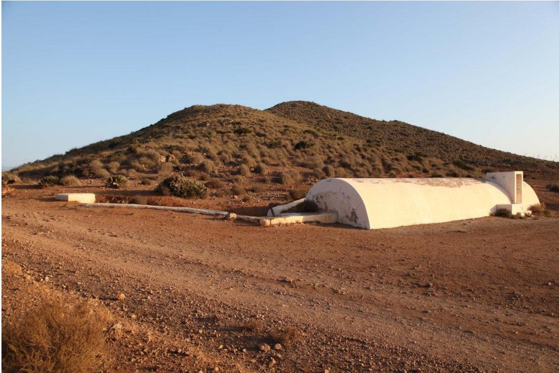
Fotografía 8.15: panorámica del aljibe de bóveda de cañón de Coyatos (entre el Cortijo del Fraile y el Cortijo de Requena, en el Campo de Níjar, Almería). Se observa los muros que delimitan el área de captación de la escorrentía (para evitar la pérdida del agua que alimenta a la balsa de decantación), la torreta adosada a la bóveda de cañón donde se encuentra la puerta que permitía la extracción del agua captada y almacenada mediante un cubo atado a la cuerda de una polea, y un abrevadero junto a la torreta con la puerta de extracción del agua. Captura del 6 de agosto de 2016
