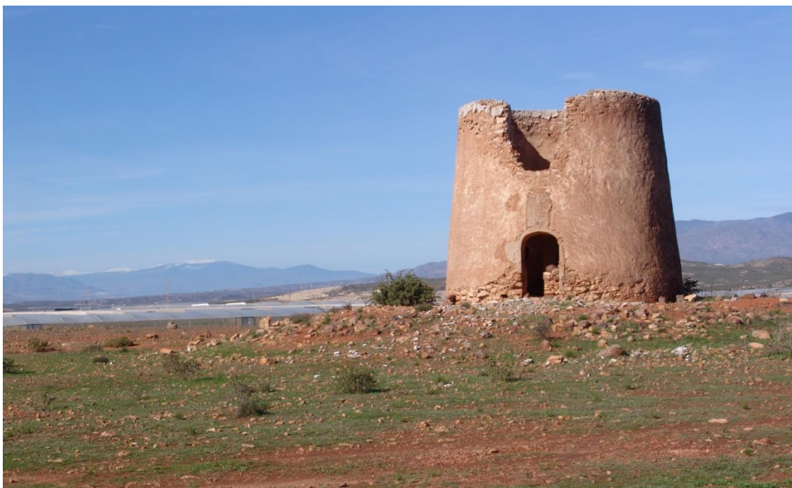
Fotografía 8.98: fachada sureste del molino de viento en estado ruinoso, con cuerpo troncocónico sin escalonar y enlucido, en la zona de El Nazareno (Parque Natural de Cabo de Gata-Níjar, Almería). Captura del 2 de enero de 2010
