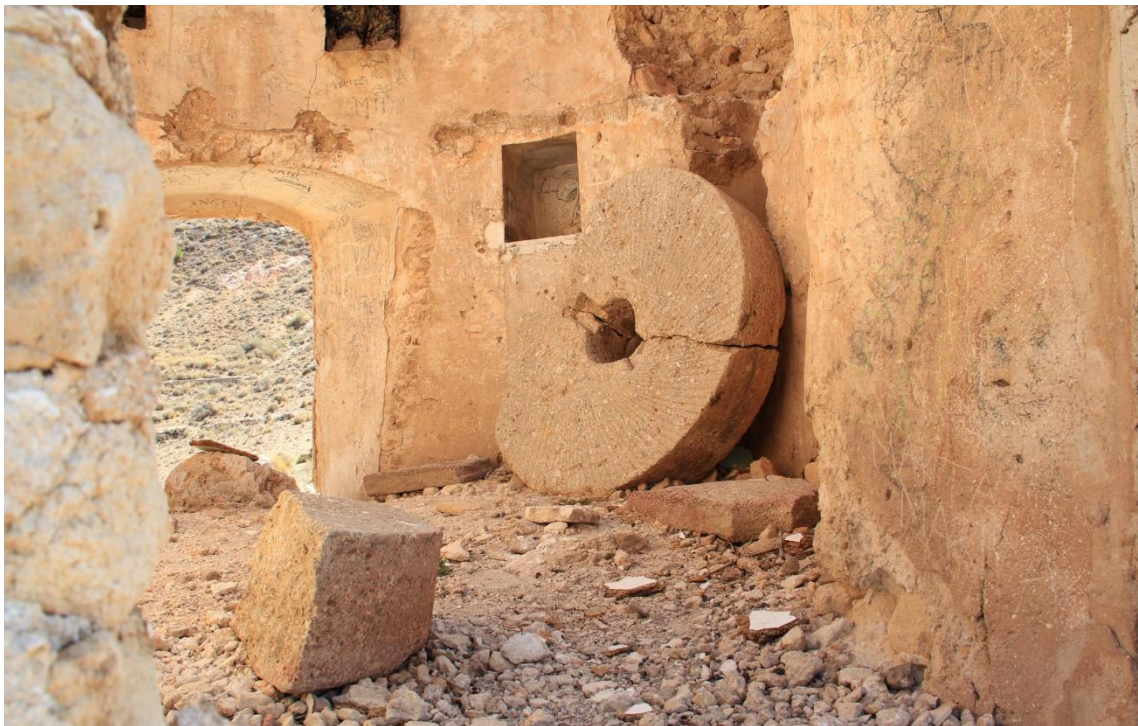
Fotografía 8.100: interior del anterior molino de viento, donde se observa al fondo a la derecha, una de las piedras para la molienda de los granos de cereales (Las Negras, Parque Natural de Cabo de Gata-Níjar, Almería). Captura del 4 de agosto de 2011
