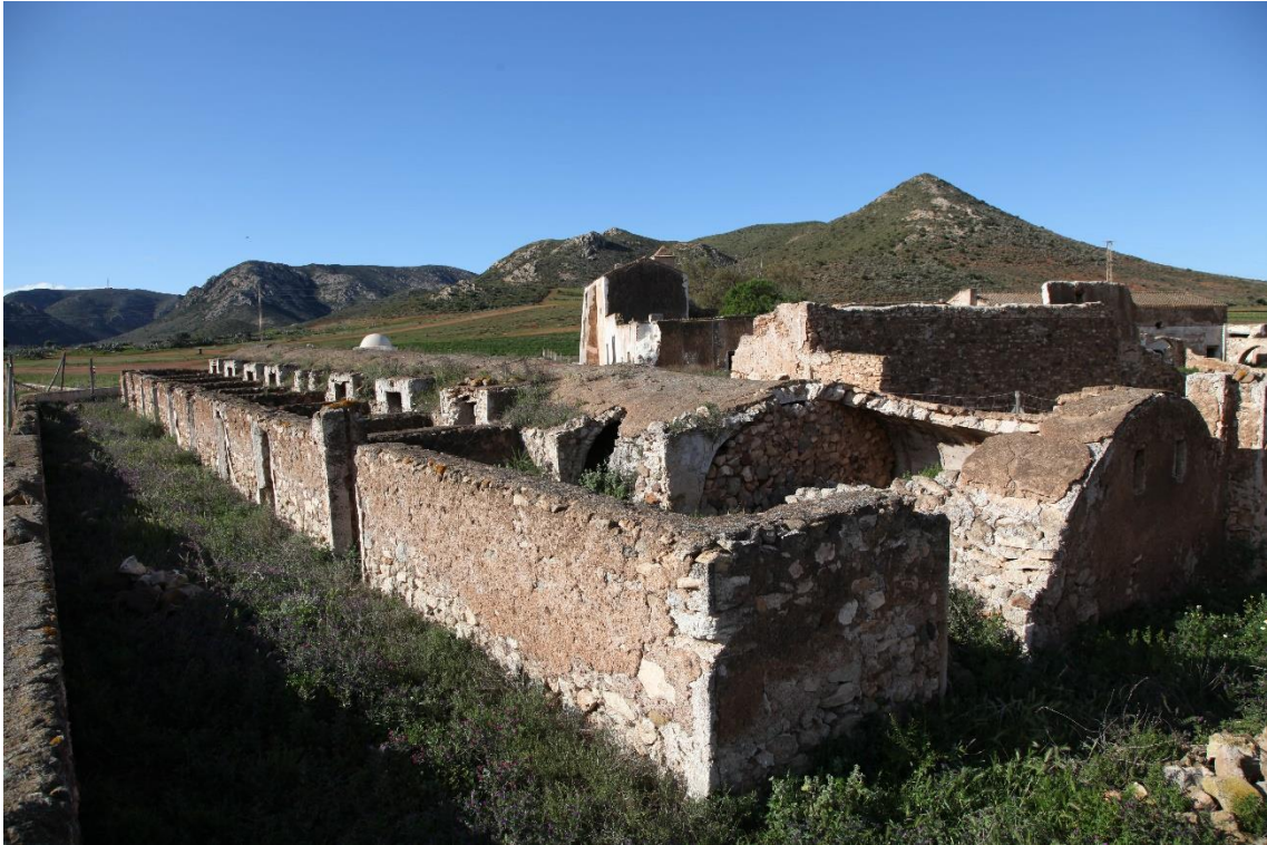
Fotografía 8.66: fachada oriental y transversal a la bóveda (a la derecha de la imagen) de la cochinería en hilera del Cortijo del Fraile. Captura del 21 de marzo de 2018
