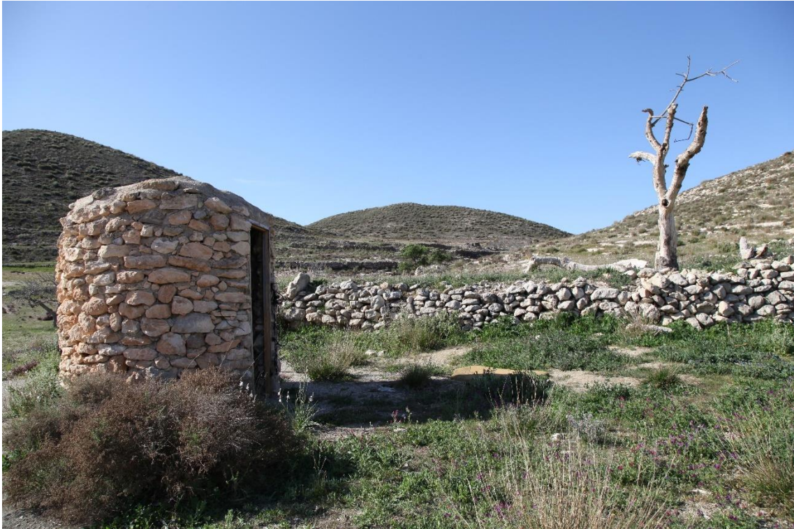
Fotografía 8.123: balates de piedra seca en la Cortijada Cañada Segura (abandonada y en estado ruinoso), entre las pedanías Las Hortichuelas y Fernán Pérez. Captura del 23 de marzo de 2012
