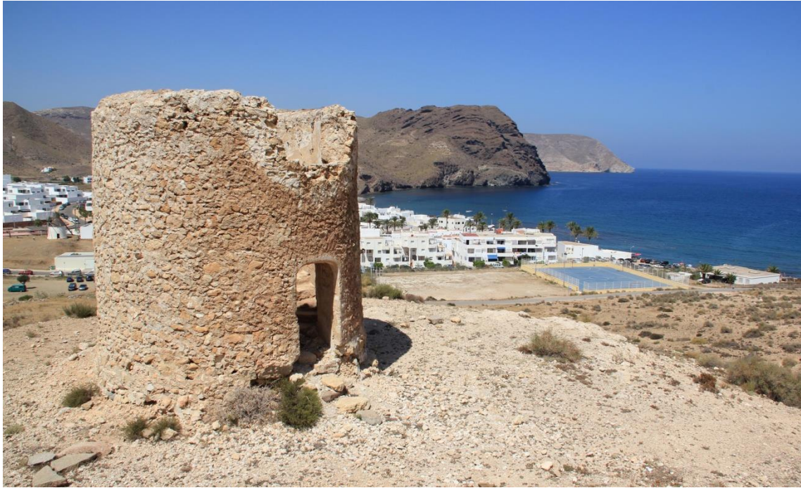
Fotografía 8.99: fachada meridional del molino de viento en estado ruinoso, con cuerpo cilíndrico sin escalonar y sin enlucir, donde se observa una de las dos puertas y el hueco para la maquinaria, en Las Negras (Parque Natural de Cabo de Gata-Níjar, Almería). Captura del 4 de agosto de 2011
