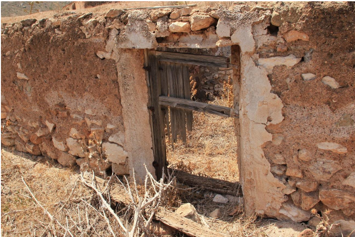
Fotografía 8.67: detalle de una de las entradas externas a un compartimento de la cochinería en hilera del Cortijo del Fraile, desde el corredor de servicios. Las entradas externas tenían puertas construidas con tablas de madera. Captura del 6 de agosto de 2016
