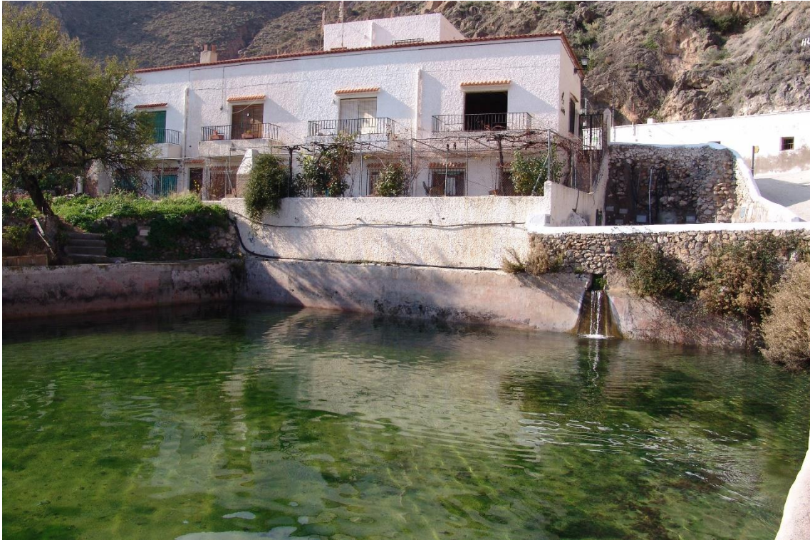
Fotografía 8.105: vista de la alberca a pie de la Fuente de Huebro, para regular el uso del agua por los molinos. Cuando se almacenaba una adecuada cantidad de agua en la alberca, corría la acequia del sistema hidráulico molinero con un caudal capaz de hacer funcionar a la maquinaria del molino. Captura del 29 de diciembre de 2007
