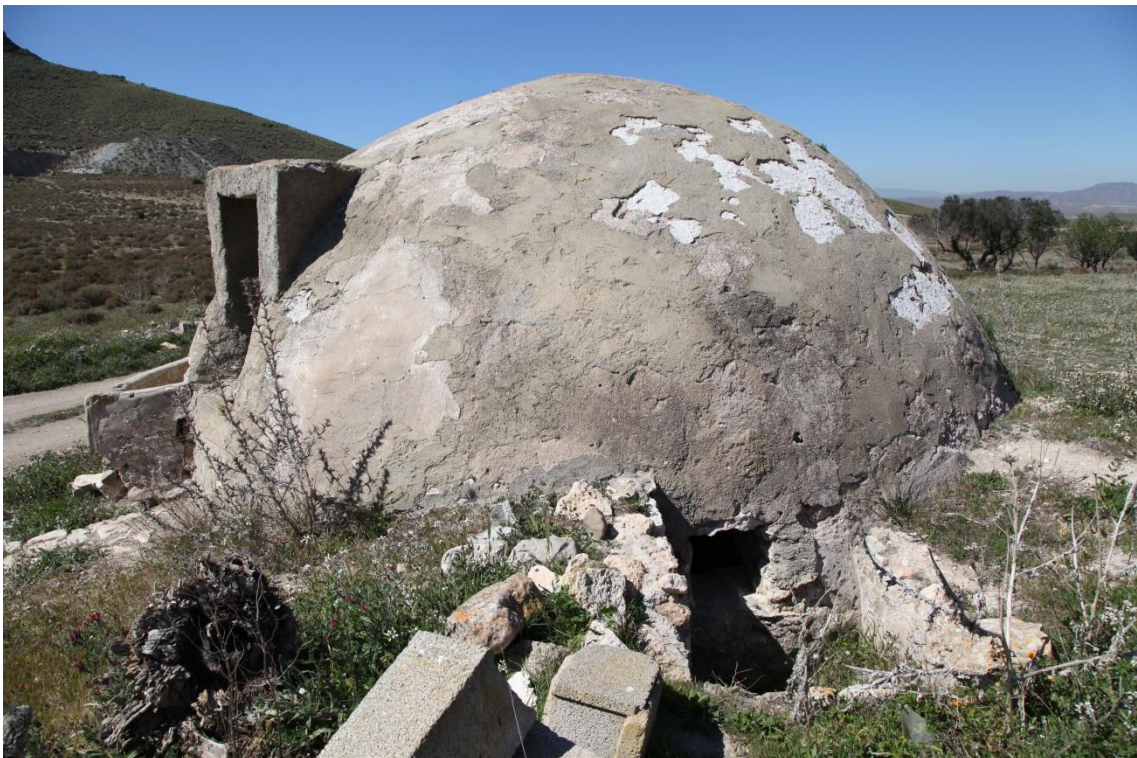
Fotografía 8.8: vista de la balsa de decantación del agua de escorrentía procedente del canal de conducción, y del tragante. Aljibe de cúpula del Cortijo del Collado de Las Huertas, entre Fernán Pérez y Agua Amarga (Campo de Níjar, Almería). Captura del 14 de marzo de 2012
