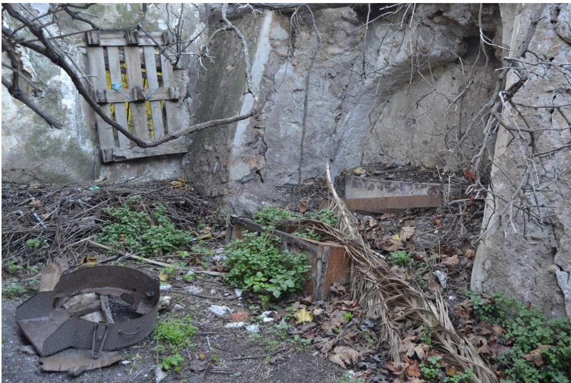
Fotografía 8.110: vista interna de la estancia principal en primer molino de agua, desde la cabecera del Valle de Huebro. A la altura media de la imagen, a la derecha, se encuentra la piedra de molienda (muela) de la base. Esta muela es fija y recibe el nombre de solera. Captura del 7 de diciembre de 2016
