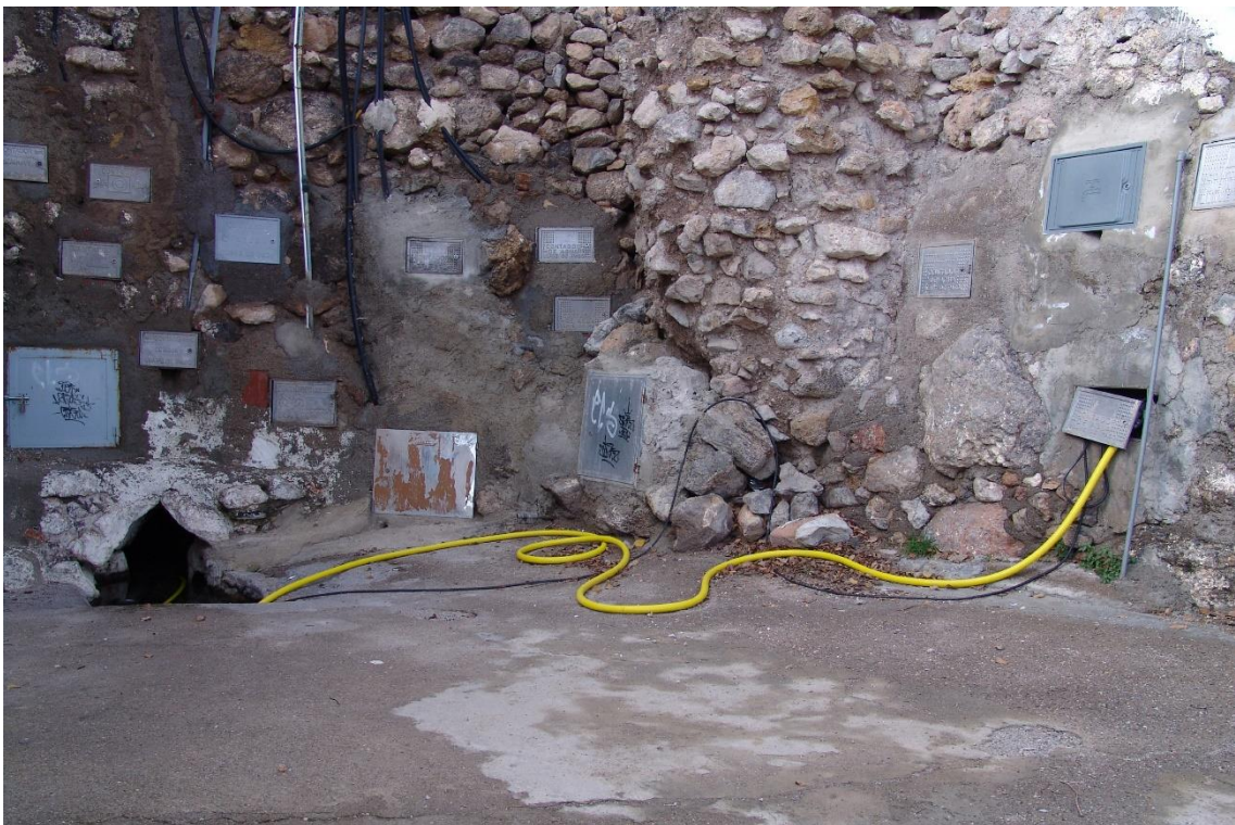
Fotografía 8.104: vista de la Fuente de Huebro (parte inferior izquierda de la imagen, por donde sale la tubería amarilla) y del conjunto de contadores de los socios de la Heredad de Aguas, dentro de la propia Barriada. Captura del 29 de diciembre de 2007
