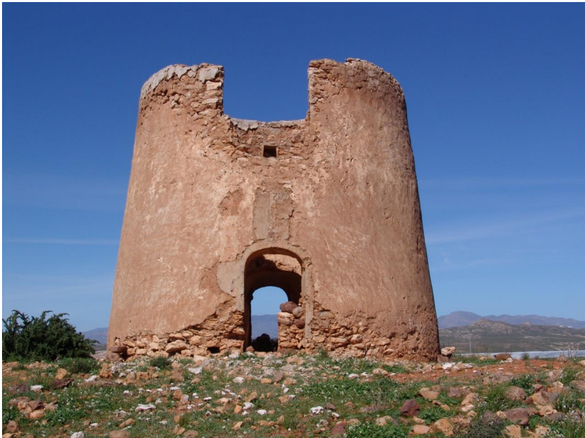
Fotografía 8.96: fachada sureste del molino de viento en estado ruinoso, con cuerpo troncocónico sin escalonar, donde se observa las dos puertas y el hueco para la maquinaria, en la zona de El Nazareno (Parque Natural de Cabo de Gata-Níjar, Almería). Captura del 2 de enero de 2010
