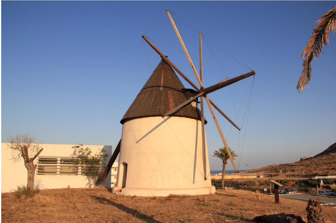
Fotografía 8.94: fachada occidental del molino de viento de chapitel móvil, con cuerpo troncocónico sin escalonar, en Las Negras (Parque Natural de Cabo de Gata-Níjar, Almería). Captura del 4 de agosto de 2011
