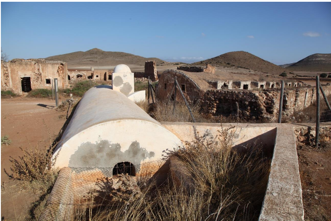
Fotografía 8.14: primer plano de la balsa de decantación del aljibe del Cortijo del Fraile, en las proximidades del extremo noreste de la casa-vivienda. En un segundo plano, a la derecha, se encuentra la cochinería. Captura del 6 de agosto de 2016
