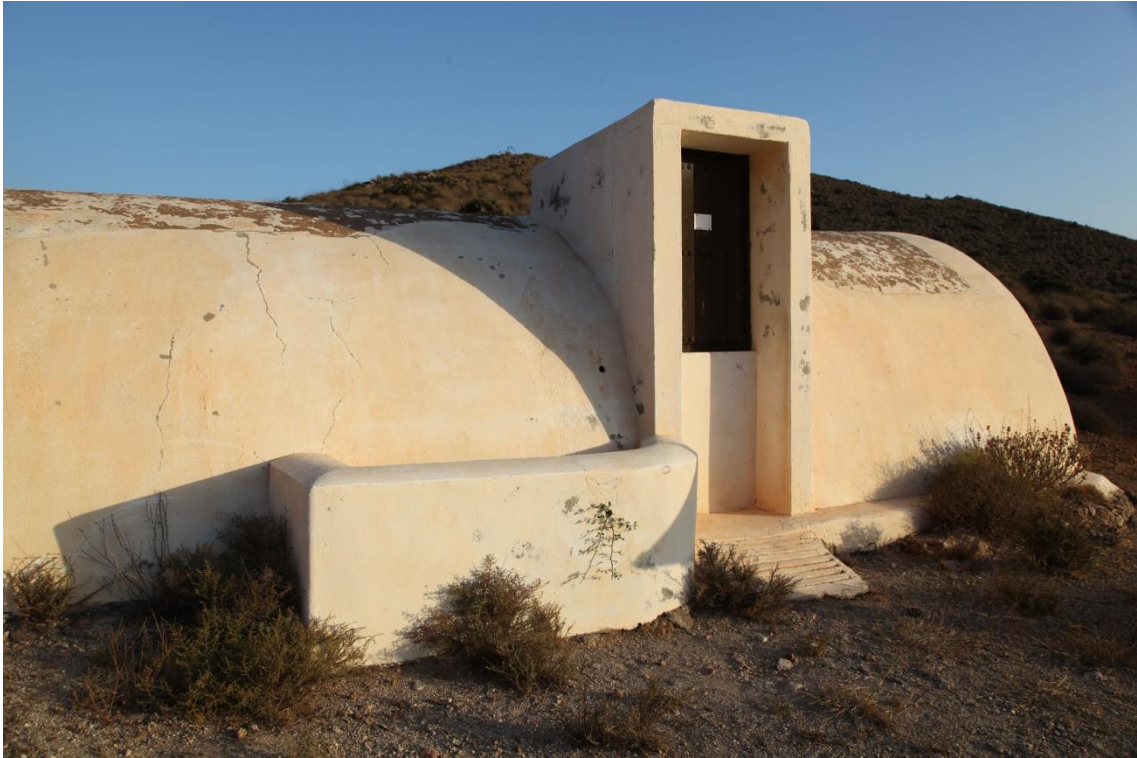
Fotografía 8.17: vista de la torreta, con la puerta de acceso a la extracción del agua captada y almacenada, y abrevadero. Aljibe de bóveda de cañón de Coyatos (Campo de Níjar, Almería). Captura del 6 de agosto de 2016
