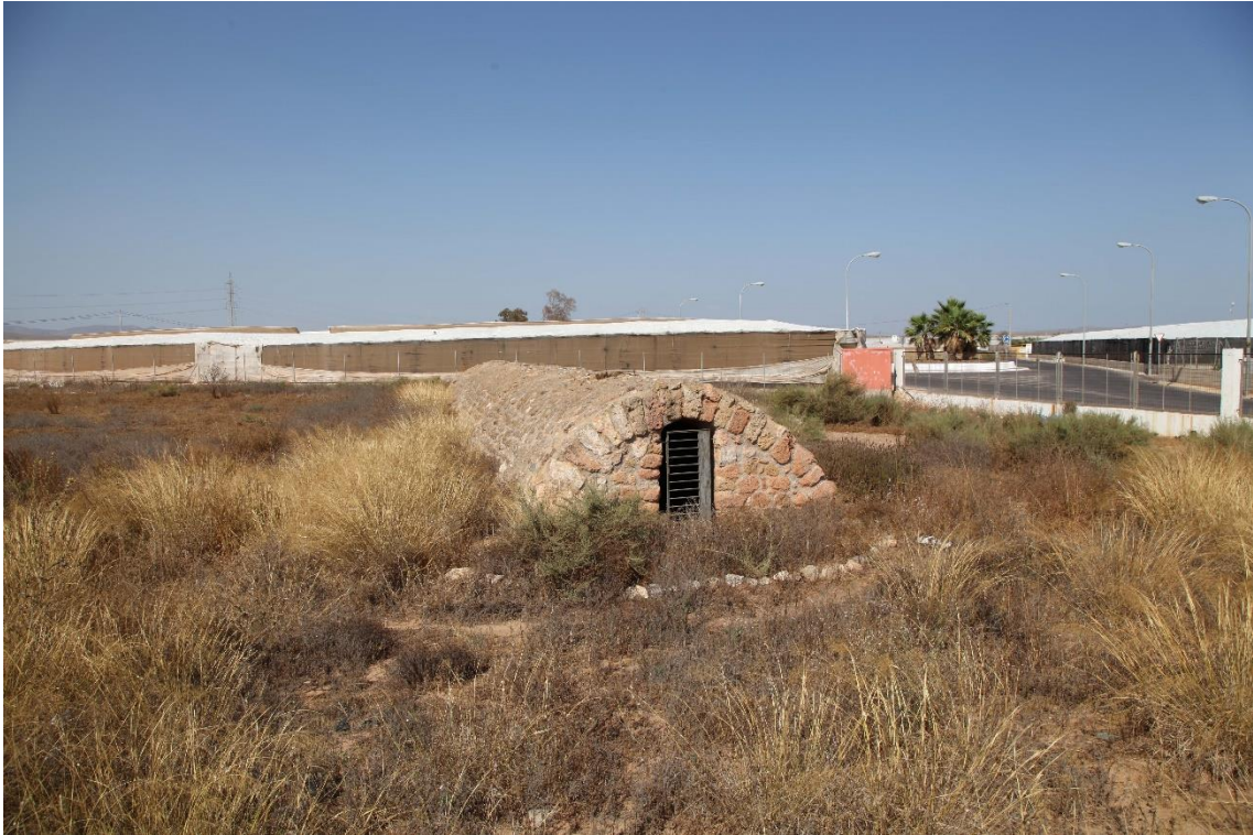
Fotografía 8.27: vista de la cara frontal y del lateral norte del Aljibe Bermejo desde una escalera de mano colocada en el exterior de la valla de protección. El aljibe se encuentra en las proximidades del núcleo urbano de Campohermoso (Níjar). Captura del 9 de agosto de 2017, cuando reinaba un viento del sur con polvo en suspensión
