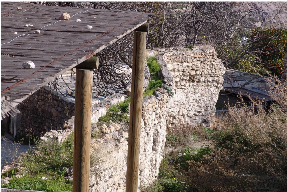
Fotografía 8.108: detalle de la llegada de la acequia a parte superior del cubo del primer molino de agua, en la cabecera del Valle de Huebro. Captura del 29 de diciembre de 2007
