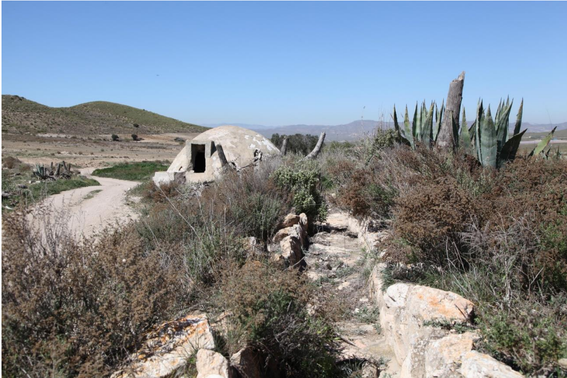
Fotografía 8.7: vista del canal de conducción del agua de escorrentía, causada por lluvia, hacia la balsa de decantación. Aljibe de cúpula del Cortijo del Collado de Las Huertas, entre Fernán Pérez y Agua Amarga (Campo de Níjar, Almería). Captura del 14 de marzo de 2012
