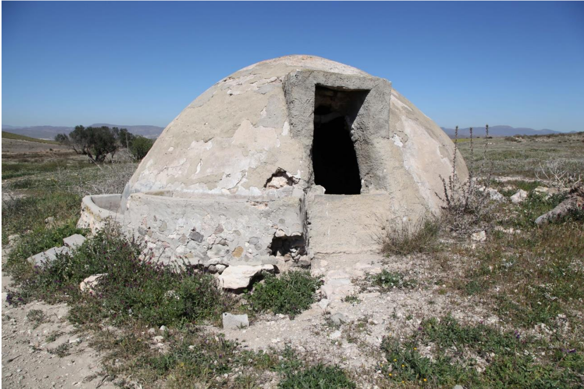
Fotografía 8.9: aljibe de cúpula en el Cortijo del Collado de Las Huertas, entre Fernán Pérez y Agua Amarga (Campo de Níjar, Almería). Desde la parte superior a la base, se observa la cúpula adosada al aljibe con el hueco externo por donde se extraía el agua captada y almacenada, la pileta para lavar ropa y utensilios diversos de cocina, el abrevadero en un plano más bajo y el rebosadero. Captura del 14 de marzo de 2012
