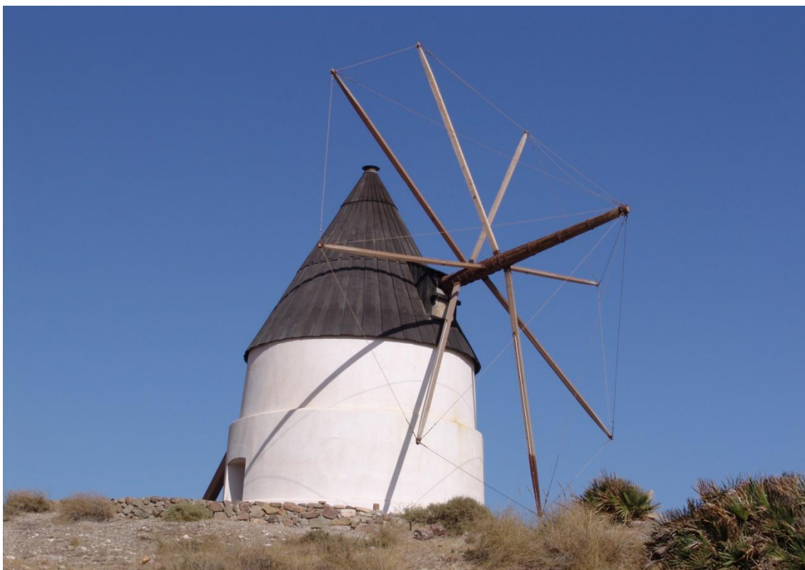
Fotografía 8.90: fachada oeste del molino de viento de chapitel móvil, con cuerpo troncocónico escalonado, en el Cerro del Avemaría, límite con el Campillo de Los Genoveses (Parque Natural de Cabo de Gata-Níjar, Almería). Captura del 12 de agosto de 2008
