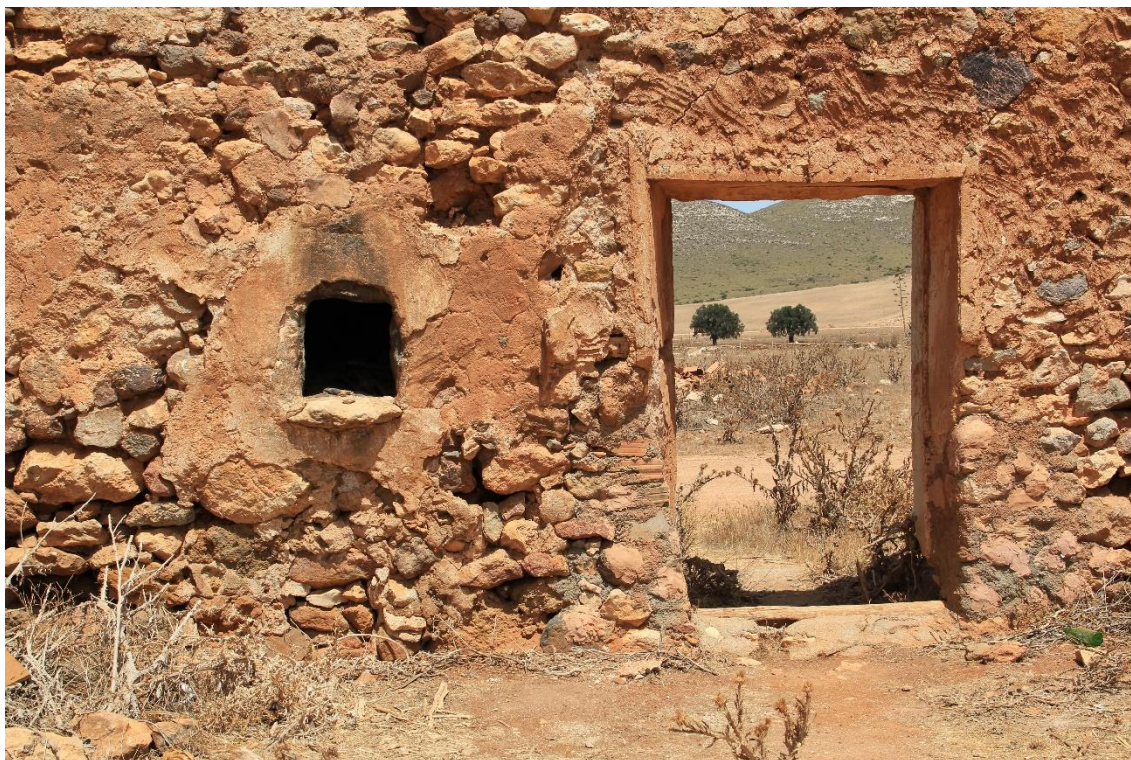
Fotografía 8.61: boca del horno en el patio trasero del Cortijo del Fraile. La tahona se construyó en el exterior del muro. Captura del 17 de agosto de 2011
