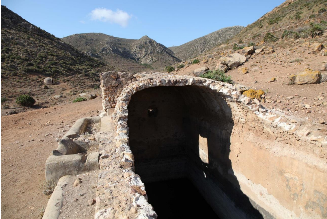
Fotografía 8.21: detalle de las piletas y del abrevadero del aljibe de bóveda de cañón, en el Cortijo de Requena. Captura del 31 de julio de 2014
