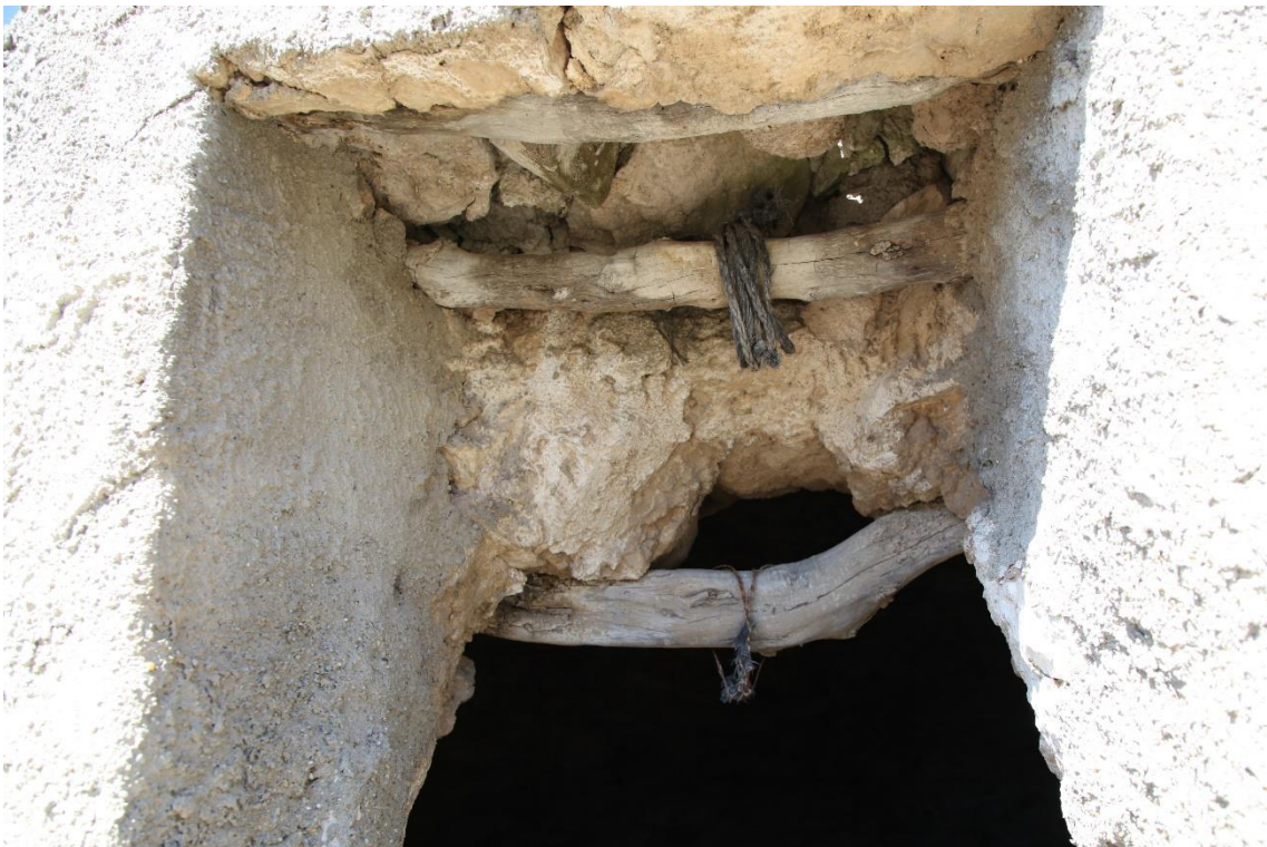
Fotografía 8.10: travesaños en el vano de la cúpula del aljibe, por donde se extraía el agua. En los travesaños se colocaban las poleas para subir el agua (normalmente con cubos amarrados a sogas (cuerdas)). Aljibe de cúpula en el Cortijo del Collado de Las Huertas, entre Fernán Pérez y Agua Amarga (Campo de Níjar, Almería). Captura del 14 de marzo de 2012
