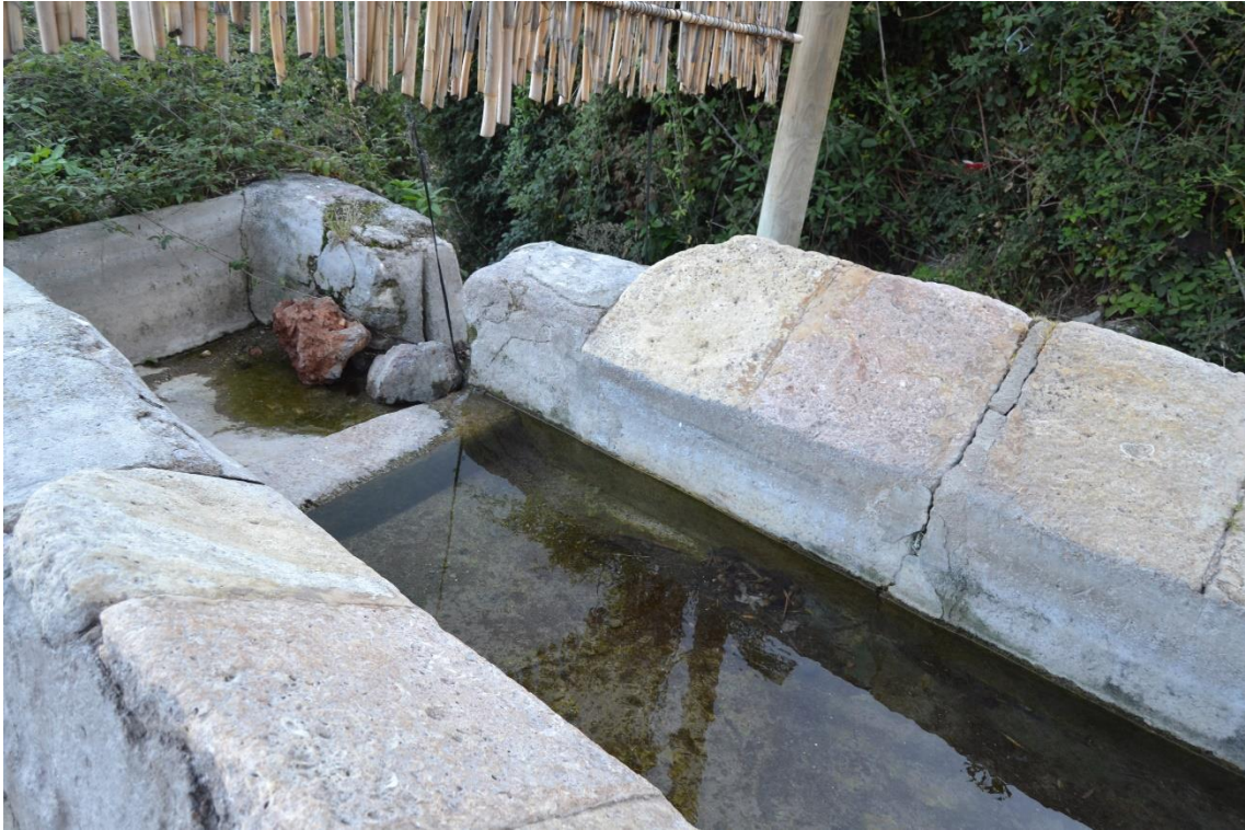
Fotografía 8.107: detalle del lavadero actual, en las proximidades de la alberca, que utiliza la acequia que servía a los molinos de agua del Valle de Huebro. Captura del 7 de diciembre de 2016
