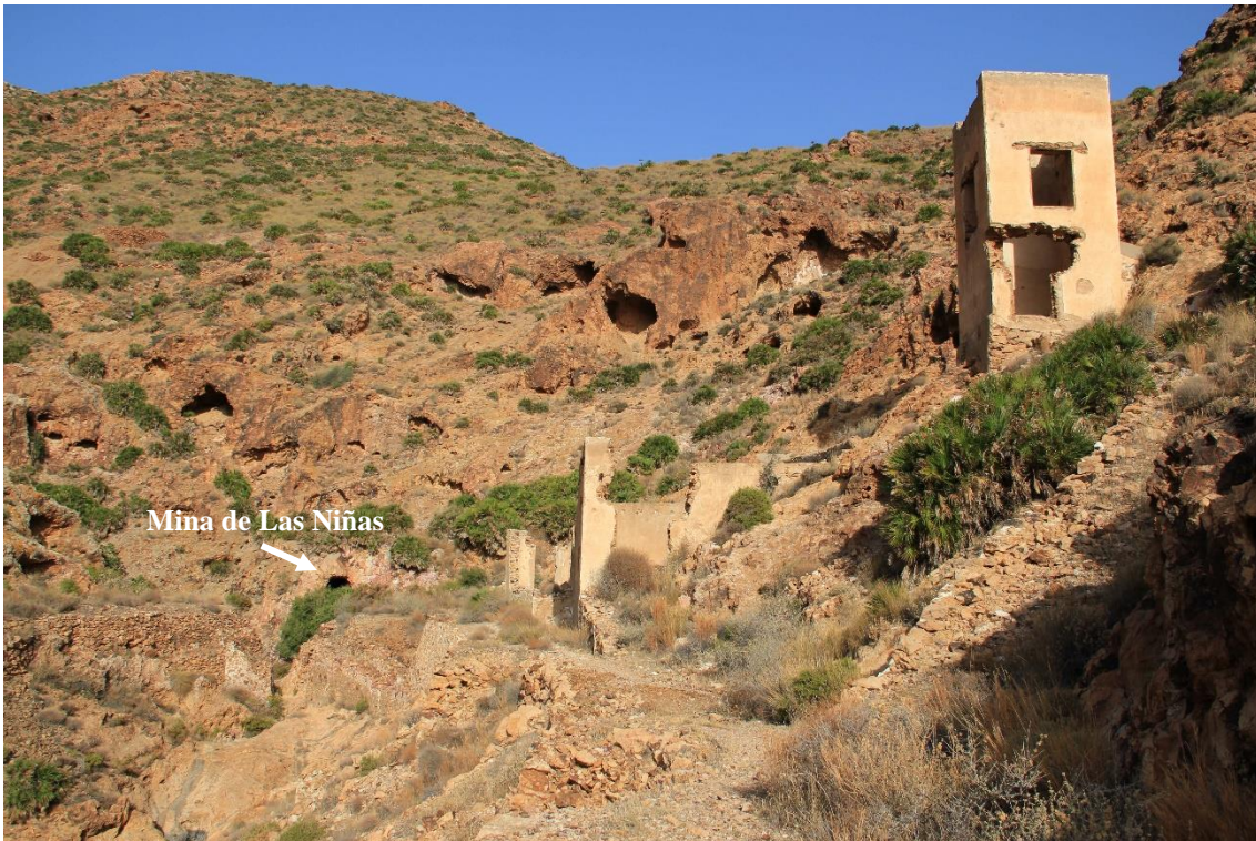
Fotografía 7.32: restos de las instalaciones empleadas en la explotación de plomo y plata en la Mina de Las Niñas. Dentro de esta mina, en 1883, se descubrió cuarzo aurífero. Al fondo, y a pie de camino, en plena curva, se encuentra la bocamina. Captura del 17 de agosto de 2011
