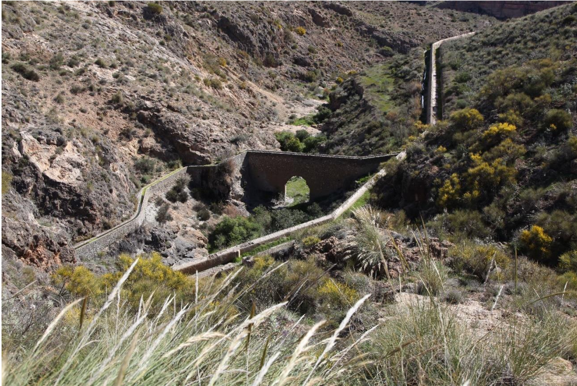
Fotografía 7.10: vista, aguas abajo (hacia el Campo de Níjar), del canal de riego (en el centro derecha de la imagen) y de la acequia (a la izquierda, que pasa sobre un muro con un ojo). El canal de riego (Canal de Campo) tiene unos 170 cm de ancho, y una altura promediada de 160 cm. Este canal recorre unos 1600 m, tanto por la Rambla de Carrizalejo como por fuera de ella, hasta acabar en un depósito doble, ya en los Tristanes. La acequia, con un caudal muy modesto, siempre va por la Rambla y también acaba en los Tristanes. Captura del 19 de marzo de 2018
