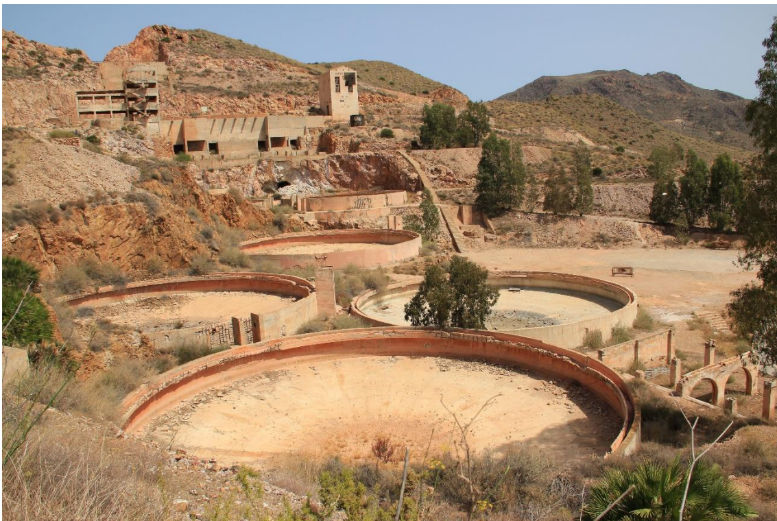
Fotografía 7.41: parte de las instalaciones de la Empresa ADARO. Entre un primer plano y un segundo plano intermedio, están los tanques lavadores en relación con el procesado de la roca aurífera. Casi en el fondo escénico, destaca el complejo de molienda entre la torre de admisión-trituradora de la roca (a la izquierda) y el transformador eléctrico (a la derecha). Captura del 3 de agosto de 2011
