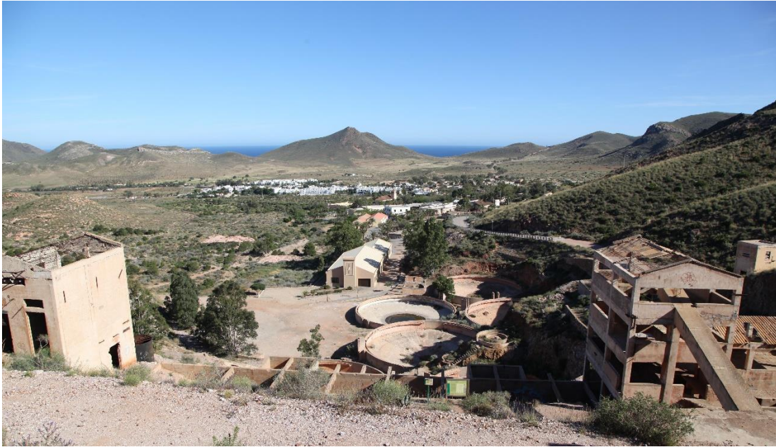
Fotografía 7.40: panorámica actual (2017) de una parte de las instalaciones de la Empresa ADARO, en relación con el procesado a la roca aurífera, mediante cianuro, para obtener el oro. En un primer plano y de derecha a izquierda, una de las torres trituradoras de la roca y tanques lavadores. En un plano intermedio próximo, se encuentra la nave de precipitado, afino, fundición y almacenaje de los lingotes de oro en una caja fuerte. En un plano intermedio lejano está la Población de Rodaquilar, que en estos momentos vive de la industria turística, básicamente de sol y playa. En el fondo escénico, se levantan los relieves que delimitan a una caldera volcánica por colapso. Captura del 2 de mayo de 2017
