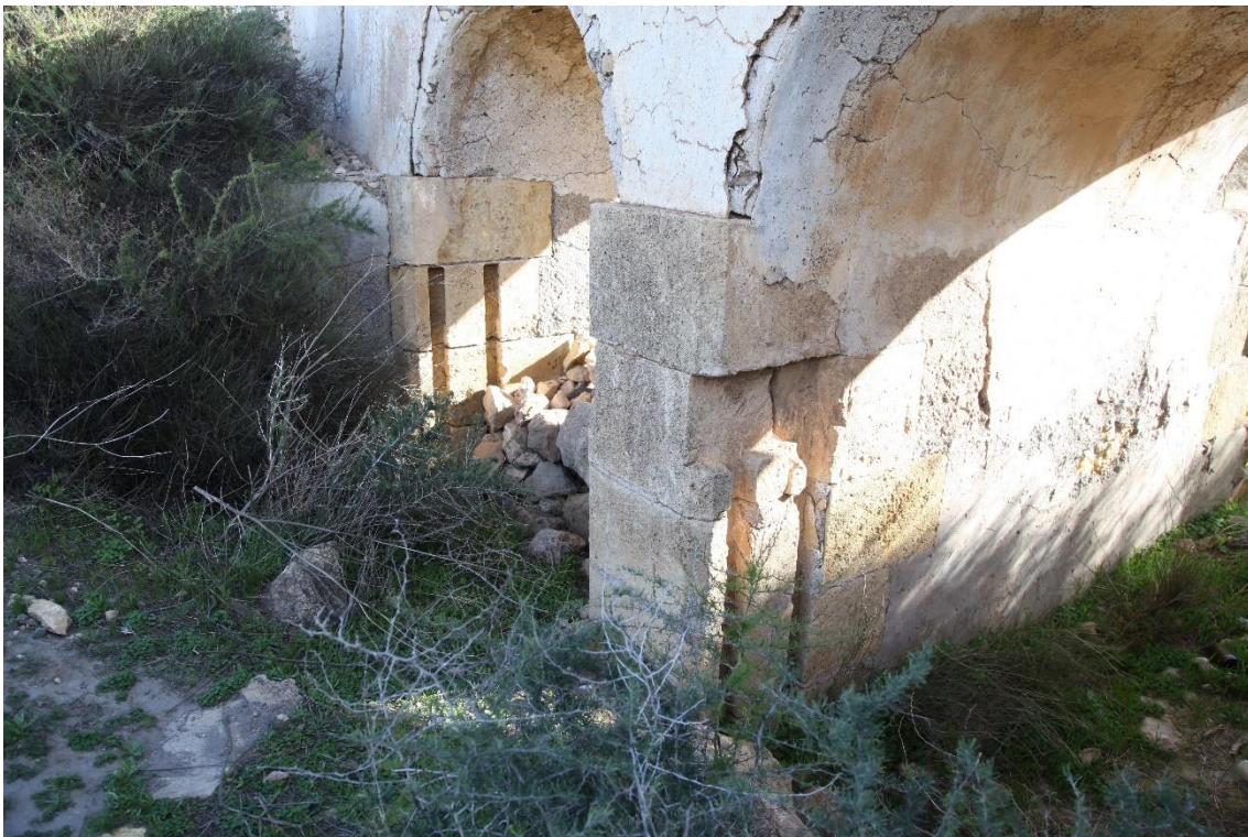
Fotografía 7.13: canal doble del aliviadero del Pantano Isabel II, próximo al muro de la presa. En esta sección del canal del aliviadero, hay dos ojos. Se observan muescas pertenecientes a posibles estaciones de aforo, donde se medían los caudales del agua liberada cuando se superaba los límites de seguridad en las acumulaciones retenidas por el muro de la presa. Captura del 19 de marzo de 2018
