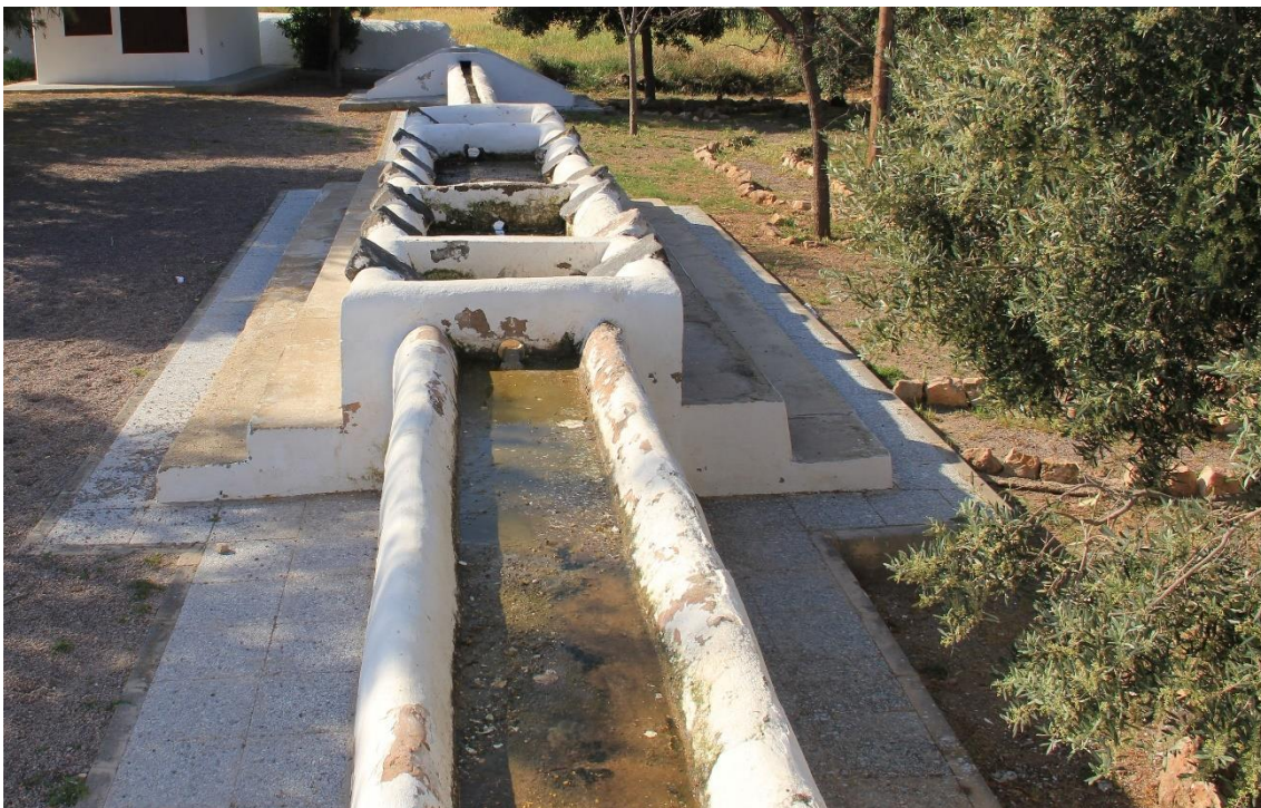
Fotografía 6.36: lavadero comunal en la Pedanía del Pozo de los Frailes, en el Campo de Níjar (Almería). El lavadero se encuentra en una acequia que se alimenta del agua que extrae la noria próxima. En el pasado reciente, la Pedanía vivía exclusivamente de la agricultura y de la ganadería. Captura del 12 de abril de 2011
