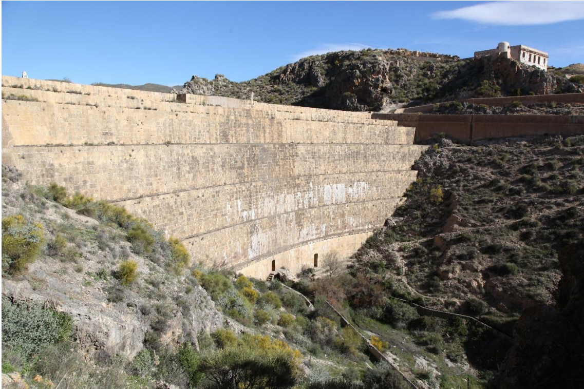
Fotografía 7.8: vista del inicio del Canal de Campo, para distribuir agua de riego a una parte del Campo de Níjar, al pie del muro externo de la presa del Pantano Isabel II. A una cota inferior, a la derecha, se observa una acequia que nace debajo del muro, y que aprovecha el agua de un nacimiento localizado en la ladera izquierda (aguas abajo) de la Rambla del Carrizalejo. Captura del 19 de marzo de 2018
