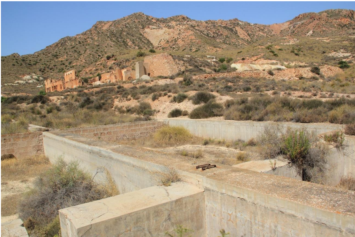
Fotografía 7.35: panorámica de las Minas de Abellán desde el camino terrero entre Rodalquilar y el Cortijo del Fraile. En un primer plano, se aprecian detalles de los estanques que se utilizaron en los procesos de extracción del oro desde las explotaciones de las Minas de Abellán. En un segundo plano, se observan restos de las instalaciones diversas de la empresa minera. Al fondo, en las laderas, destacan escombreras, relacionadas con bocaminas. Captura del 17 de agosto de 2011
