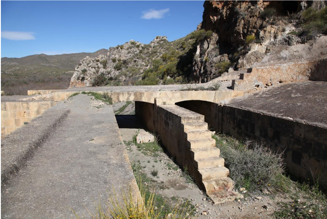
Fotografía 7.12: detalle del inicio del canal doble del aliviadero, del Pantano Isabel II. Captura del 19 de marzo de 2018
