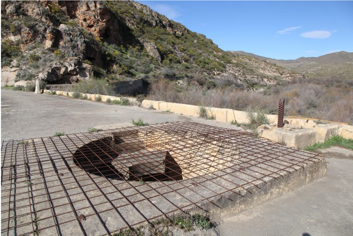
Fotografía 7.6: vista del pozo vertical, de 2.5 m de diámetro, con escalera de caracol, que desciende por el interior del muro de la presa, hasta la galería de toma de agua para el Canal de Campo. Captura del 19 de marzo de 2018
