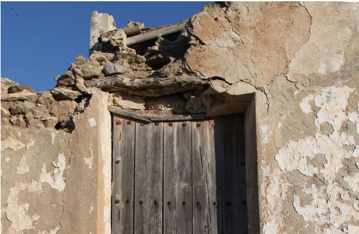
Fotografía 5.10: Cortijo del Collado de Las Huertas, entre Fernán Pérez y Agua Amarga. Detalle de la parte superior del vano de una puerta. Se observa claramente que el lumbral está formado por un tronco de árbol, que hace que el dintel de obra se encuentre descargado. Toman relevancia las hileras de cabezales de clavos rústicos ornamentales en la puerta. Captura del 11 de marzo de 2012
