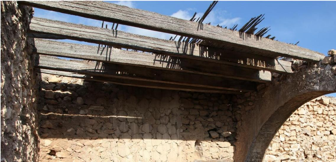
Fotografía 5.4: detalle del techo en una de las estancias del Cortijo de Arriba de Balsa Blanca, en el Campo de Níjar. Se observa cómo restos de la capa de cañas se apoya sobre las vigas de madera. Captura del 7 de marzo de 2012
