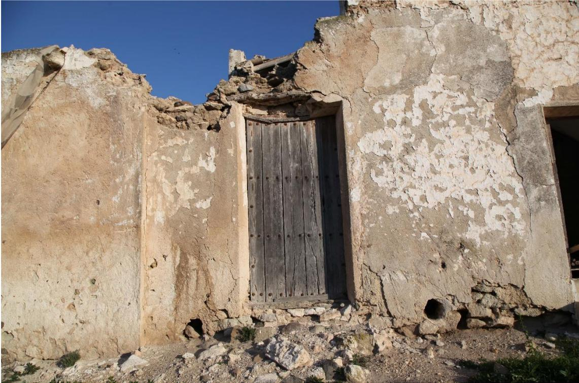
Fotografía 5.9: Cortijo del Collado de Las Huertas, entre Fernán Pérez y Agua Amarga. Sobre el vano de la puerta hay un lumbral (formado por un tronco de árbol) y un dintel de obra. En la base del vano, se encuentra un escalón, también llamado lumbral. Además, se observa un conducto cilíndrico, casi a ras del suelo, que podría tener diversas funcionalidades. Captura del 11 de marzo de 2012
