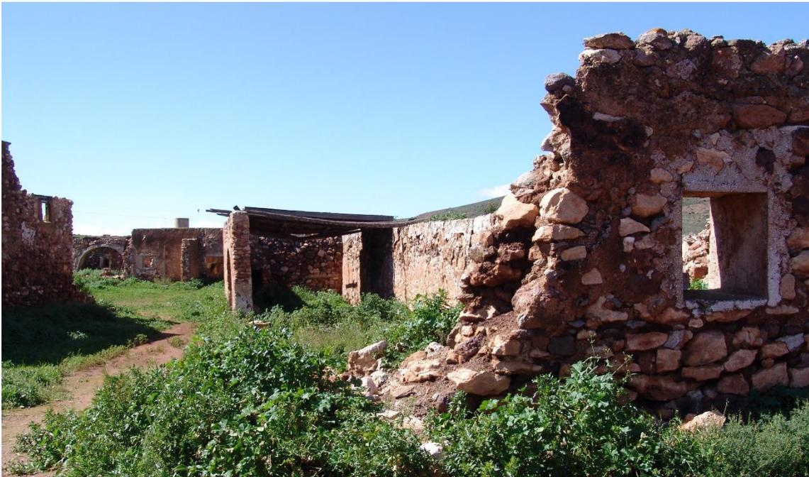
Fotografía 5.3: muro del patio trasero del Cortijo del Fraile. Se observa su construcción a partir de bloques de piedra entre barro. La cara interna del muro está revestida por una argamasa de cal y arena. La externa carece de enlucido. Captura del 9 de marzo del 2010
