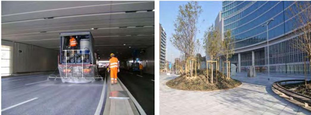
Figura 1.9: (a) *Proceso de pulverización de spray fotocatalítico sobre pavimento existente*, (b) *Detalle de acabado de extendido de spray fotocatalítico en aceras en Milán (Faraldos, 2012)*.
