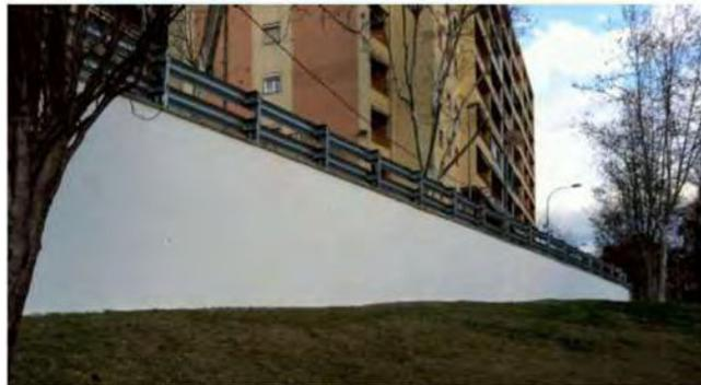
*Figura 1.12: Ejemplo de aplicación de mortero fotocatalítico sobre muros de contención (Faraldos, 2012).*
