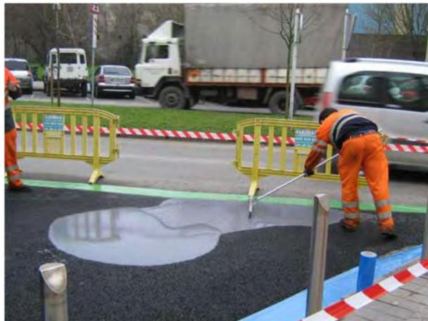
*Figura 1.8: Proceso de extendido y percolación de lechada fotocatalítica sobre un pavimento drenante (Faraldos, 2012).*
