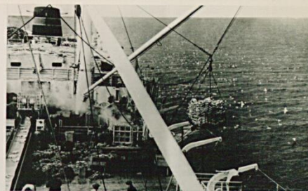
Подача стропы с крабами на палубу плавзавода «Андрей Захаров»
