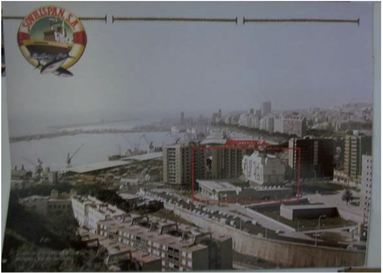
Foto 1. Edificio de “Sovhispan” a la altura del vuelo en Santa Cruz de Tenerife. Aprox. 1983. Fuente: Catálogo de “Sovhispan”. p. 2.
