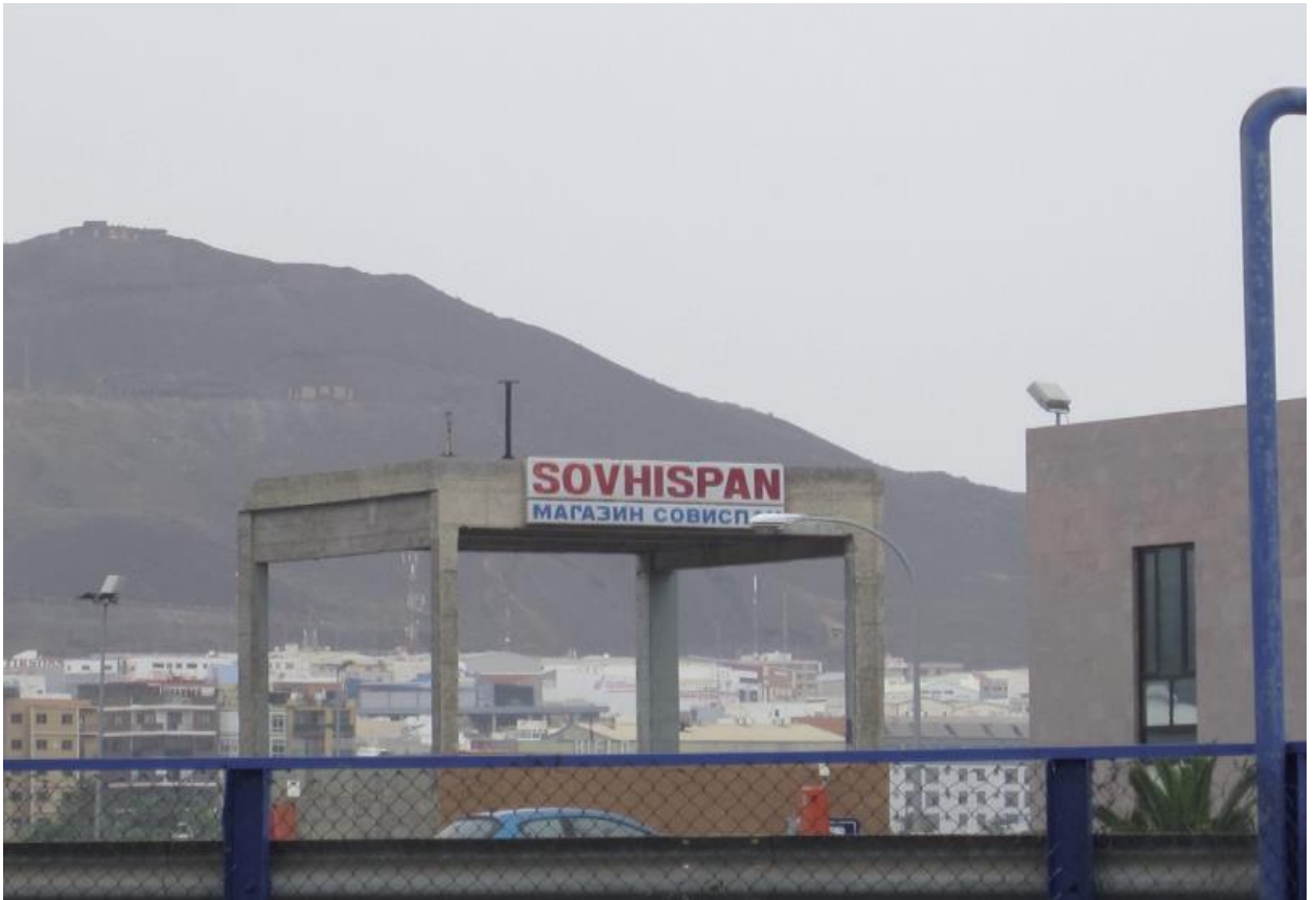
Foto 5. Columnas del edificio de “Sovhispán”, Muelle de Ribera, las Palmas de Gran Canaria, 2014. Fuente: Foto propia.
