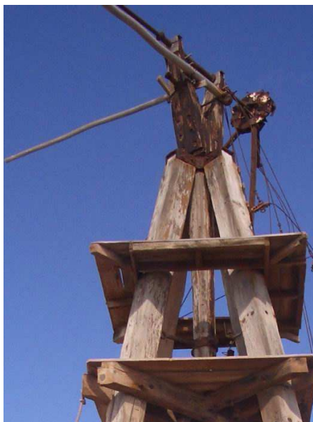
Detalle del sistema de orientación manual mediante el sistema de palos del molino de viento "Salinero Canario". Costa Teguise. Lanzarote.
