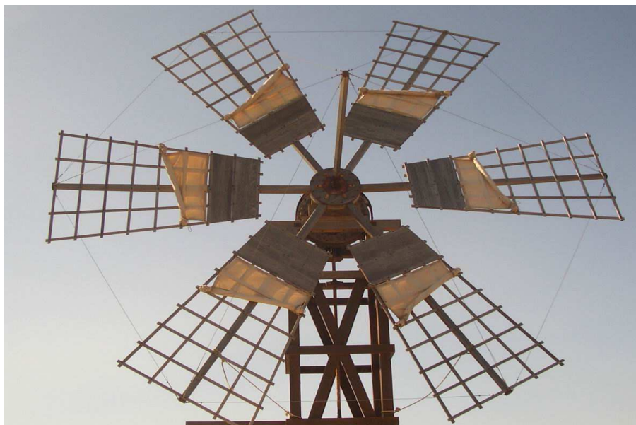
Detalle de lonas plegadas en aspas de la molina en Tefía. Fuerteventura.
