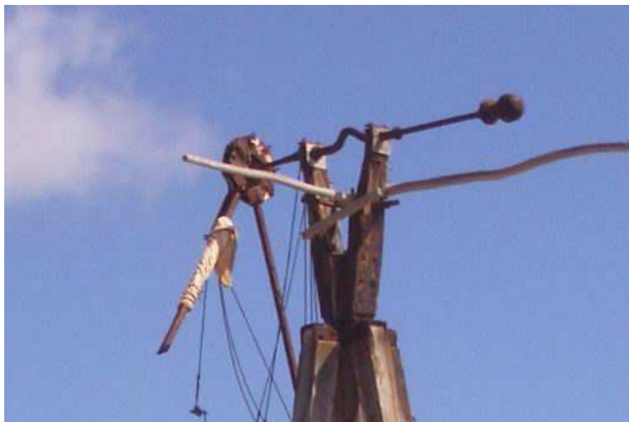
Detalle del sistema de orientación de palos. Molino "Salinero Canario"
