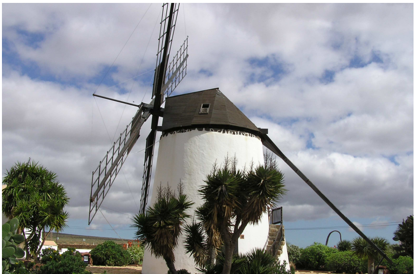
Molino de viento "Tipo torre" en TM La Antigua. Fuerteventura.
