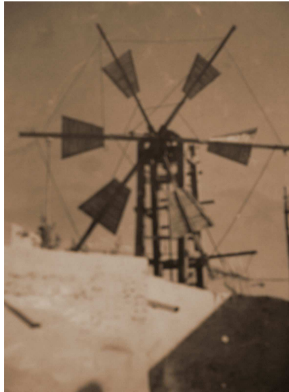
Detalle del rotor compuesto por seis aspas. Molino de viento "Sistema Romero" en Carrizal, TM de Ingenio, Gran Canaria.
