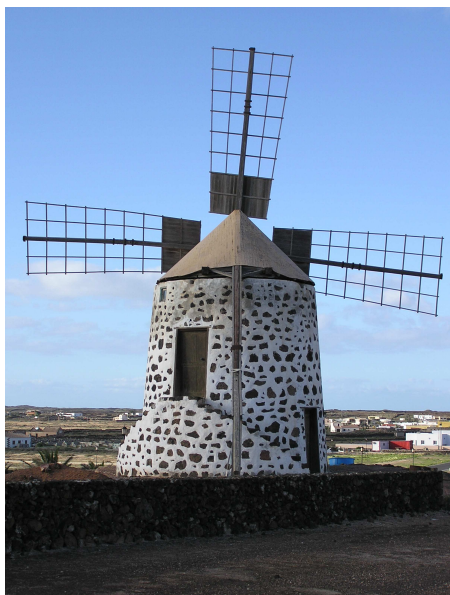
Detalle de los accesos desde el exterior a la planta baja y a la planta primera del molino de viento en Lajares en La Oliva. Fuerteventura.
