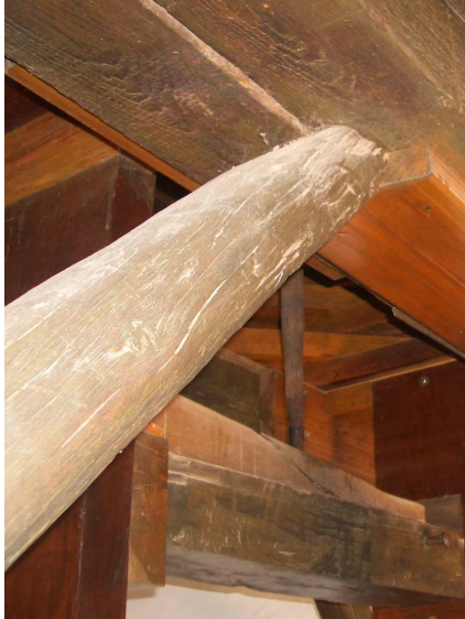
Detalle de enlace entre el aliviadero y el sopuente del molino de viento en TM de La Antigua. Fuerteventura.
