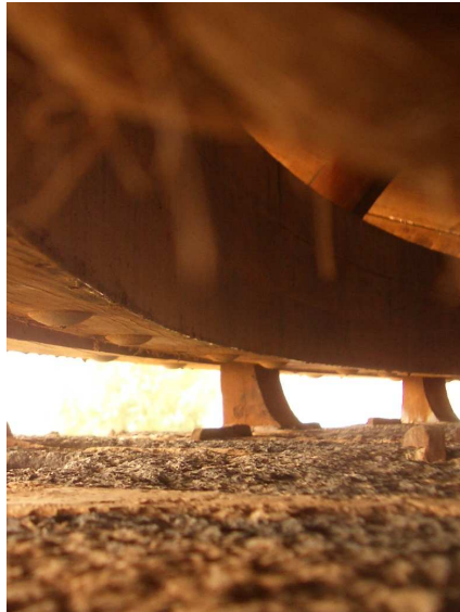
Detalle enlace de anillo inferior fijo compuesto por los canes y anillo superior móvil de la cubierta del molino de viento en TM La Antigua. Fuerteventura.
