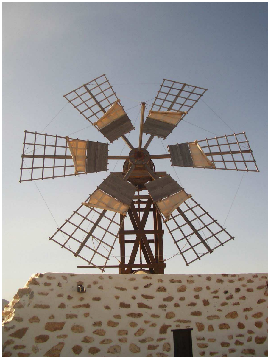
Detalle del rotor compuesto por doce aspas. Molina de viento en el Valle de Los Ortega. Fuerteventura.
