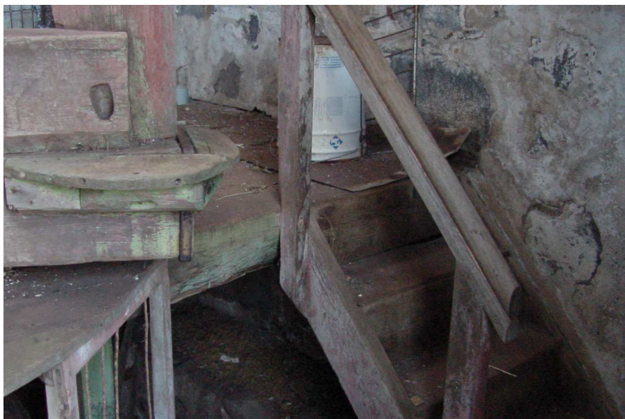
Escalera interior del molino de viento en TM de Garafía. La Palma.
