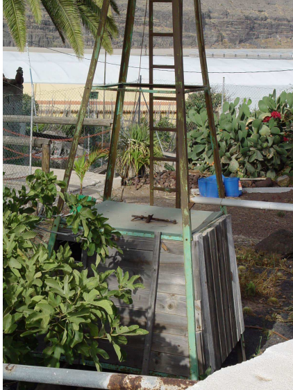
Detalle del edificio construido en madera del molino de viento Aeromotor "Tipo Americano" en TM La Aldea de San Nicolás. Gran Canaria.
