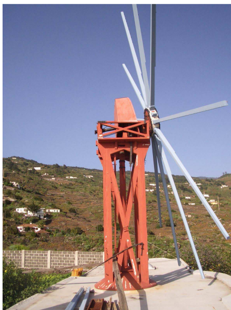
Detalle de la cubierta plana del edificio del molino de viento en El Loder. TM de La Villa de Mazo. La Palma.
