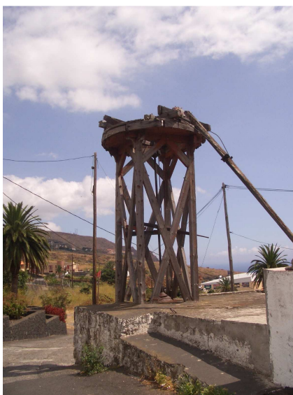
Detalle de la torre y el palo de orientación del molino de viento "Sistema Ortega" en TM de Breña Alta. La Palma.
