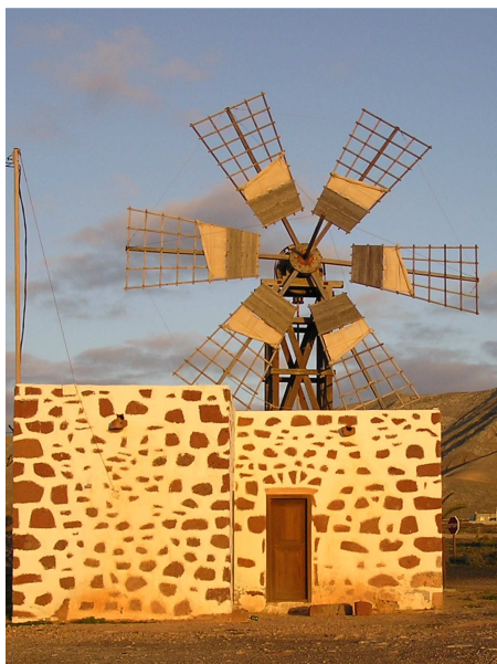
Detalle del edificio, la torre y el rotor de seis aspas de la molina de viento en Tefía, TM de Puerto del Rosario, Fuerteventura.
