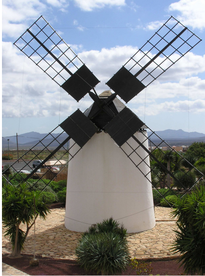
Detalle del rotor formado por cuatro telares. Molino de viento en TM La Antigua. Fuerteventura.
