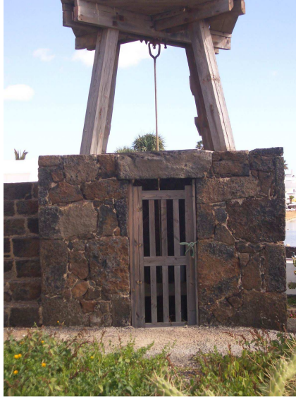
Detalle del edificio en Cubo y torre de madera del molino de viento aeromotor "Salinero Canario" en TM de Tegui. Lanzarote.
