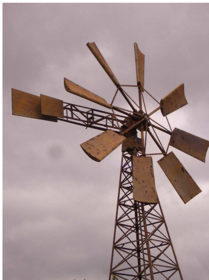
Detalle de la torre piramidal metálica y el rotor de ocho aspas de madera del molino de viento aeromotor de la marca comercial Alder, en TM Telde. Gran Canaria.
