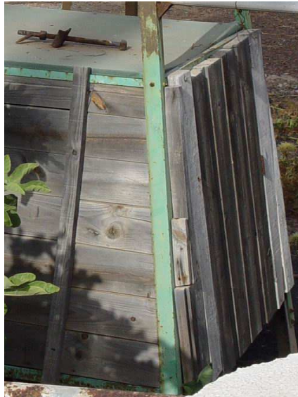
Detalle de puerta de acceso al edificio construido en madera del molino de viento Aeromotor "Tipo Americano" en TM La Aldea de San Nicolás. Gran Canaria.
