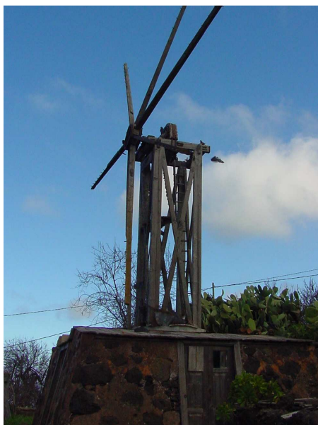
Detalle de acabado exterior de los muros de cerramiento del edificio del molino de viento en El Pueblo. TM de Puntagorda. La Palma.
