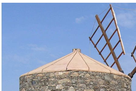
Detalle de la estructura de vigas de madera y acabado exterior e interior de chapa metálica de la cubierta cónica del molino de viento "Tipo Torre" de Los Majanos, TM La Aldea de San Nicolás, Gran Canaria.
