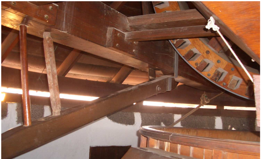
Detalle de la palanca del freno del molino de Tiscamanita. Fuerteventura.
