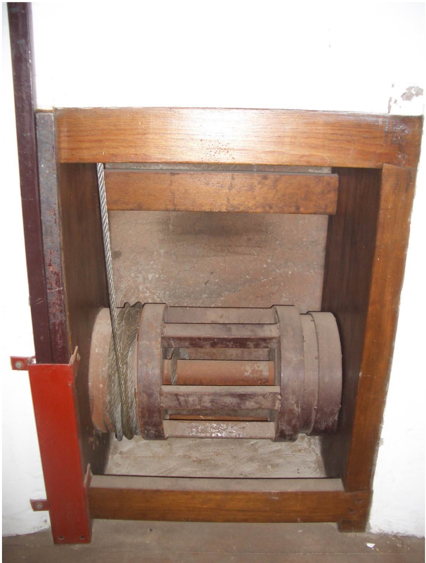
Detalle del engranaje que permite la rotación de la cubierta del molino de viento en TM Mogán. Gran Canaria.
