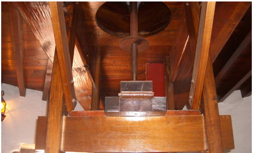
Enlace entre el aliviadero y el sopuente. Molino en Mogán. Gran Canaria.
