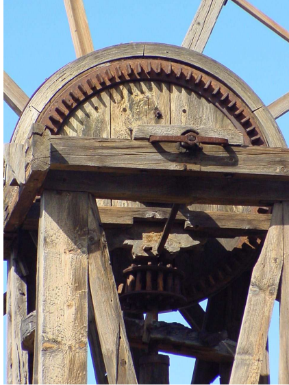
Detalle de la rueda catalina o capacete cuyos dientes están configurados por cuñas de hierro atornillados sobre un anillo del mismo material al círculo de madera del molino de viento en Las Tricias. TM de Garafía, La Palma.
