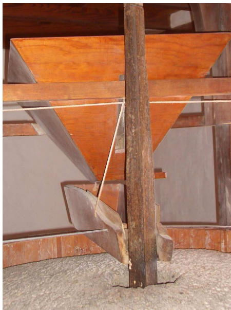
Detalle de enlace entre la canaleja y el eje metálico o aguja. Molina de viento en Tefía, TM de Puerto del Rosario, Fuerteventura.
