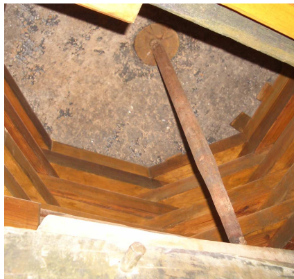
Detalle de aliviador y trampilla de forma octogonal bajo la piedra fija e inferior del molino de viento en TM de La Antigua. Fuerteventura.
