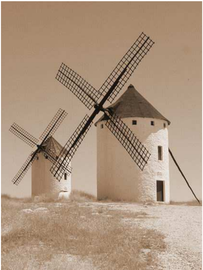
Molinos de viento harineros "Tipo Torre" de rotor de cuatro aspas en Campo de Criptana. España.
