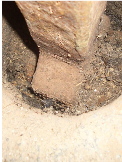
Detalle enlace entre el eje vertical denominado aguja y la piedra superior del molino de viento en TM de La Antigua. Fuerteventura.
