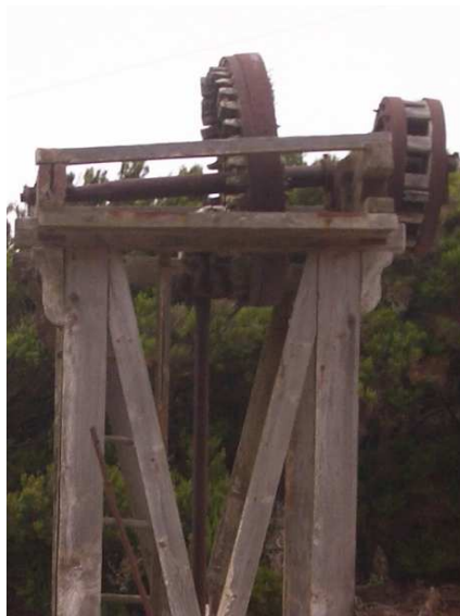
Detalle del marco resistente situado en la coronación de la torre cuadrada de madera sobre el cual se fija el eje semihorizontal de hierro. Molino de viento en Tirimaga, TM de la Villa de Mazo. La Palma.
