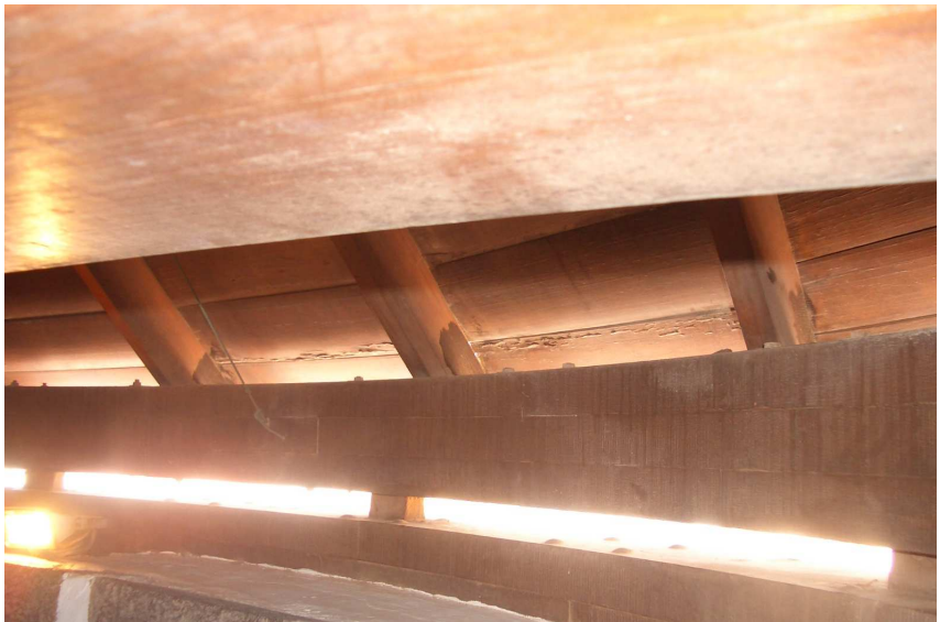
Detalle enlace de anillo inferior fijo compuesto por los canes y anillo superior móvil de la cubierta del molino de viento en TM La Antigua. Fuerteventura.
