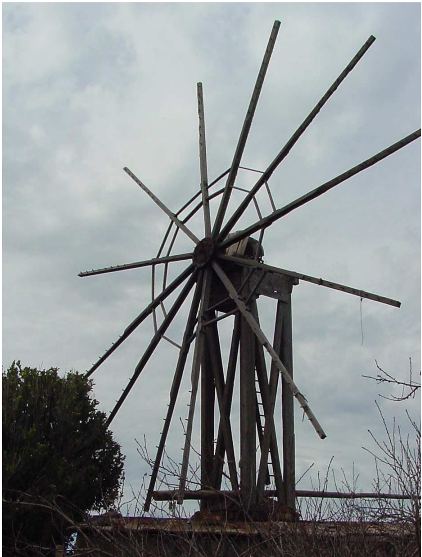
Detalle de la adaptación del palo de orientación, timón o rabo del molino de viento "Tipo Torre" en el molino de viento "Sistema Ortega". Dicho palo de orientación tiene una dirección oblicua y nace en la coronación de la torre cuadrada de madera y termina a un metro del suelo. Molino de viento situado en TM de Breña Alta. La Palma.
