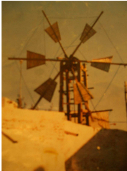
Molino de viento tipo "Sistema Romero" de rotor de seis aspas en Carrizal. TM Ingenio. Gran Canaria.
