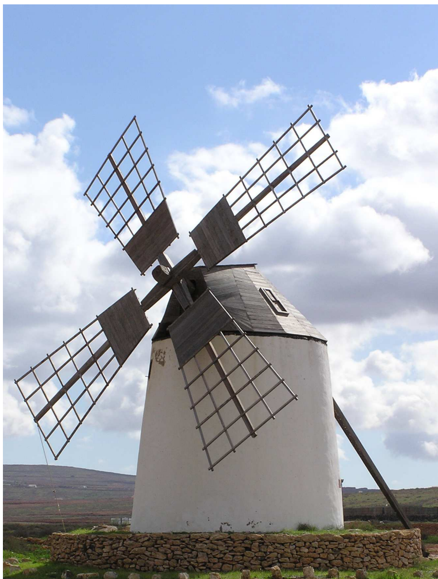
Molino de viento "Tipo Torre" en Los Llanos de La Concepción. TM Puerto del Rosario, Fuerteventura.
