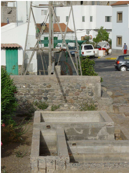
Detalle del tubo de descarga y la tanqueta de derivación del agua hacia las acequias que la trasladan hacia el tanque o depósito de almacenamiento de molino de viento aeromotor "Tipo Americano" en TM La Aldea de San Nicolás. Gran Canaria.
