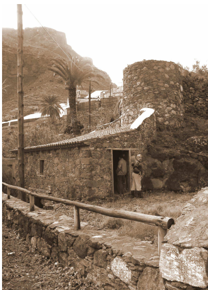
Detalle del cubo y del edificio del molino de agua de El Parra. TM de la Aldea. Gran Canaria.
