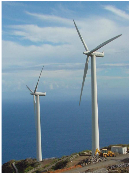
Detalle de aerogeneradores de rotor tripala y torre tubular de acero en el TM de Garafía. La Palma.
