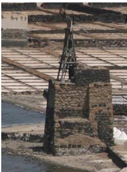
Detalle del edificio en Mastaba y torre de madera del molino de viento aeromotor "Salinero Canario" en las salinas del Janubio en TM de Yaiza. Lanzarote.
