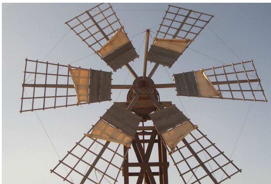
Detalle del rotor compuesto por seis aspas de madera. Molina de viento en Tefía. Fuerteventura.
