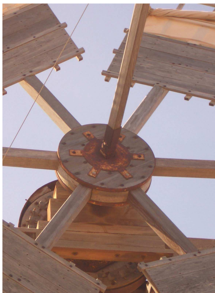
Detalle del buje o la caja de aspas de la molina de viento en Tefía, TM de Puerto del Rosario. Fuerteventura.
