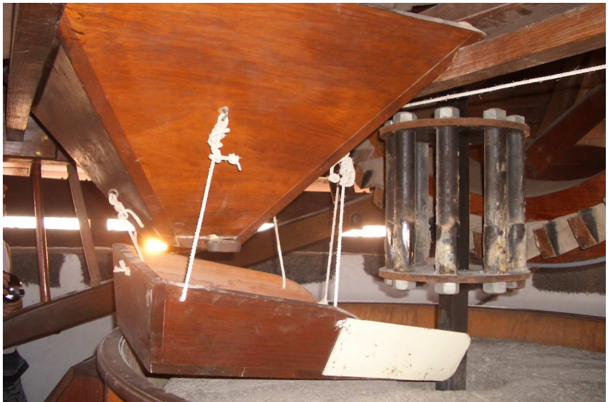
Detalle de enlace entre la canaleja y el eje metálico o aguja. Molino de viento en TM de La Antigua. Fuerteventura.
