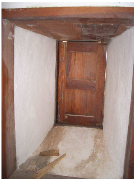
Detalle de la ventana interior del edificio de la molina compuesta de una hoja abatible en Tefía, TM de Puerto del Rosario. Fuerteventura.
