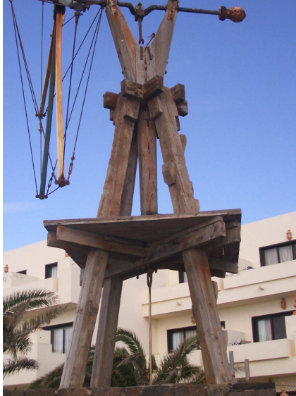
Detalle de la torre descuadrada de crucetas horizontales de madera con plataforma horizontal donde se posibilita el mantenimiento del rotor y del sistema de transmisión del molino de viento "Salinero Canario". Costa Teguise. Lanzarote.
