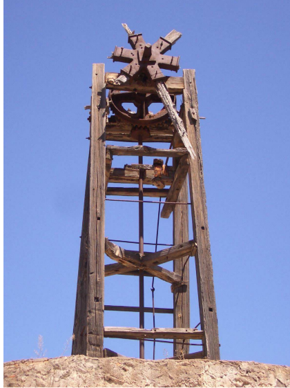
Detalle de la torre cuadrada de madera del molino de viento del "Sistema Romero" en el Lomo de Artejevez. TM de La Aldea de San Nicolás. Gran Canaria.
