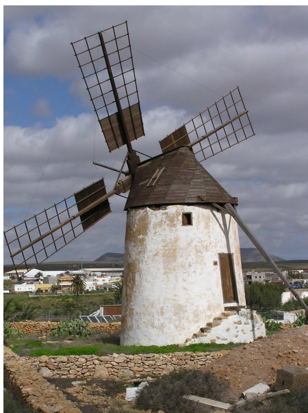
Detalle del acceso desde el exterior a la primera planta del molino de viento en Los Llanos de la Concepción. TM de Puerto del Rosario. Fuerteventura.
