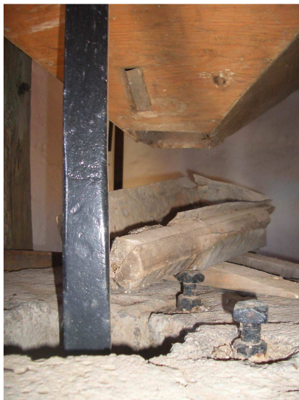
Detalle de enlace entre la canaleja y el eje metálico o aguja. Molino de viento en Carrizal. TM de Ingenio. Gran Canaria.
