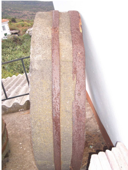
Detalle de la abrazadera de hierro que une los diferentes fragmentos de la piedra moledera o muela del molino de viento. TM de Villa de Mazo. La Palma.
