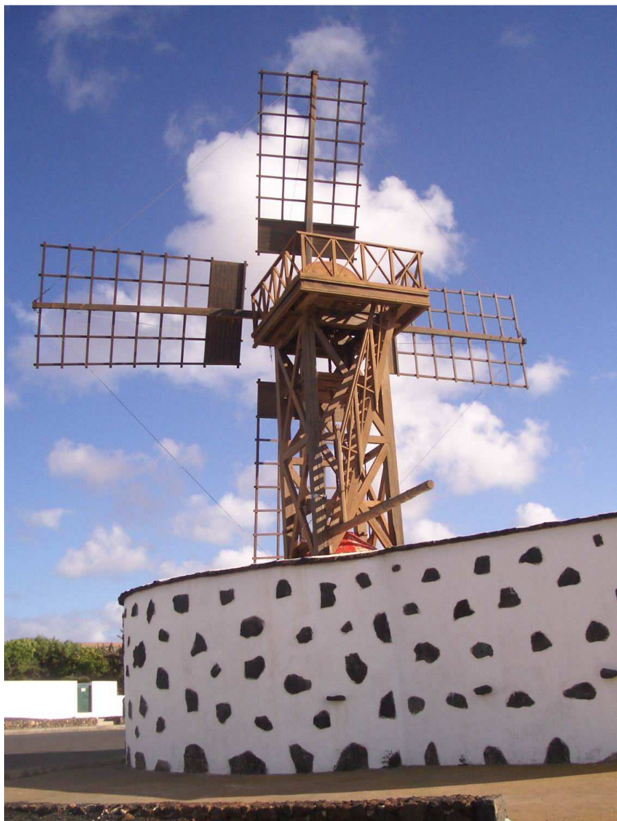
Detalle de la torre cuadrada de madera, rotor de cuatro aspas y palo de orientación, timón o rabo de la molina de viento en TM de Tegüise. Lanzarote.
