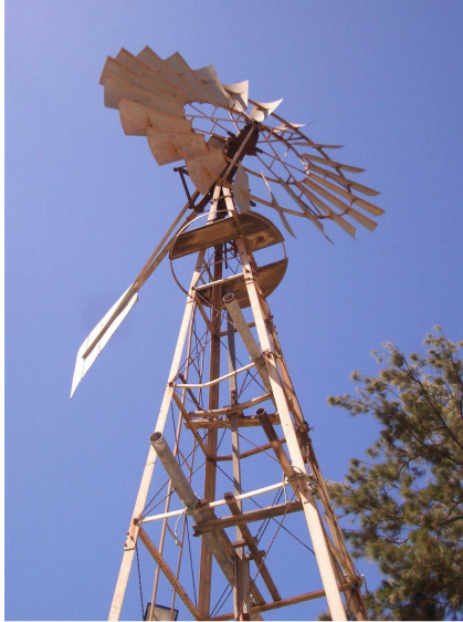
Detalle de la torre y el rotor del molino de viento aeromotor "Tipo Americano" en TM de La Aldea de San Nicolás. Gran Canaria.
