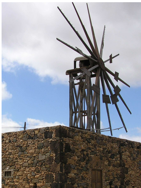
Detalle del edificio, la torre y el rotor de doce aspas de la molina de viento en el Valle de los Ortega. Fuerteventura.
