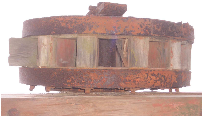
Detalle de caja de aspas del molino de viento. Villa de Mazo. La Palma.
