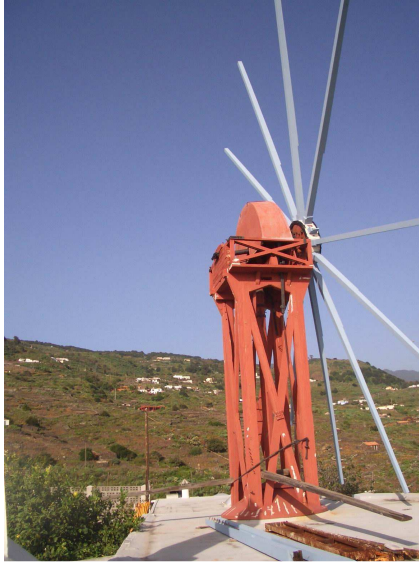
Detalle de los palos de orientación del rotor de aspas hacia los vientos dominantes situado en la base de la torre cuadrada de madera del molino de viento "Sistema Ortega" en TM Villa de Mazo. La Palma.
