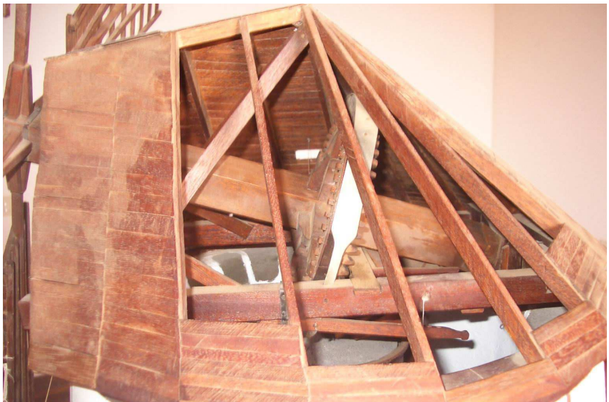
Detalle del eje inclinado del rotor. Maqueta de molino de viento en Tiscamanita. Fuerteventura.
