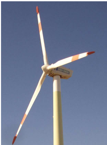
Detalle de los frenos aerodinámicos en la punta de las palas de un rotor de tres palas de un aerogenerador de la marca comercial made en el polígono industrial de Arinaga, TM de Agüimes, Gran Canaria.
