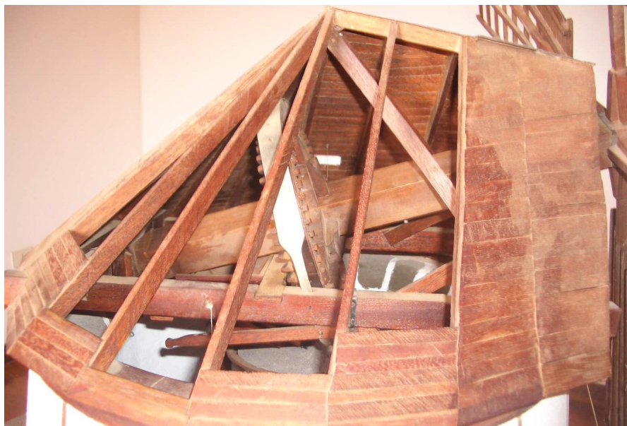
Detalle de cubierta cónica de molino de viento "Tipo Torre".
