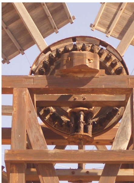
Detalle de la rueda catalina de la molina de viento en Tefía, TM de Puerto del Rosario. Fuerteventura.
