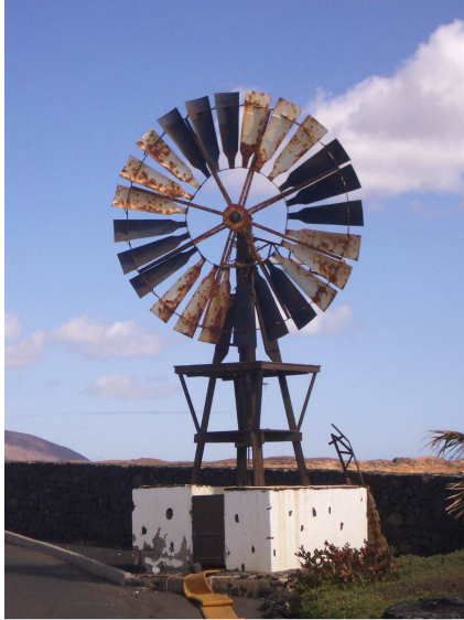
Detalle del molino "Salinero Canario" de rotor multipala metálica y torre piramidal de madera. Costa Teguse. Lanzarote.
