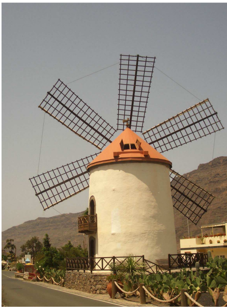
Detalle del rotor de seis aspas rectangulares y la no presencia del timón o rabo. La orientación del rotor hacia los vientos dominantes se consigue por un sistema de engranajes. Molino de viento "Tipo Torre" situado en TM de Mogán. Gran Canaria.
