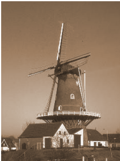
Molino de viento “Tipo Torre” de rotor de cuatro aspas de madera y velas de lonas en Holanda.
