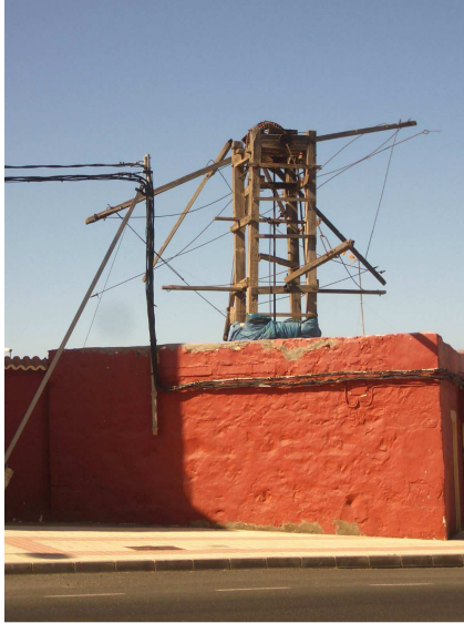
Detalle del edificio, la torre y el rotor de seis aspas del molino de viento "Sistema Romero" en Carrizal. TM de Ingenio. Gran Canaria.
