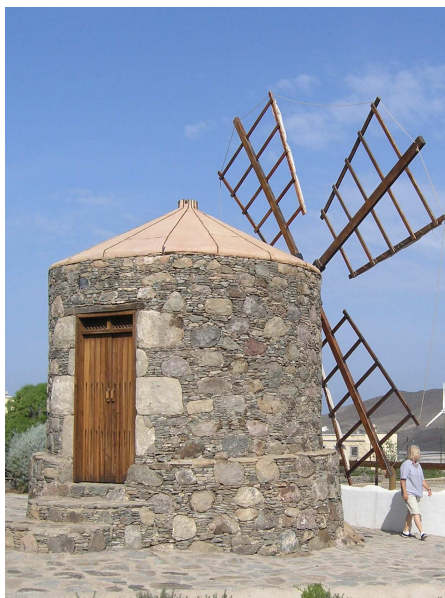
Detalle del acceso al edificio del molino de viento "Tipo Torre" de Los Majanos, TM La Aldea de San Nicolás, Gran Canaria.
