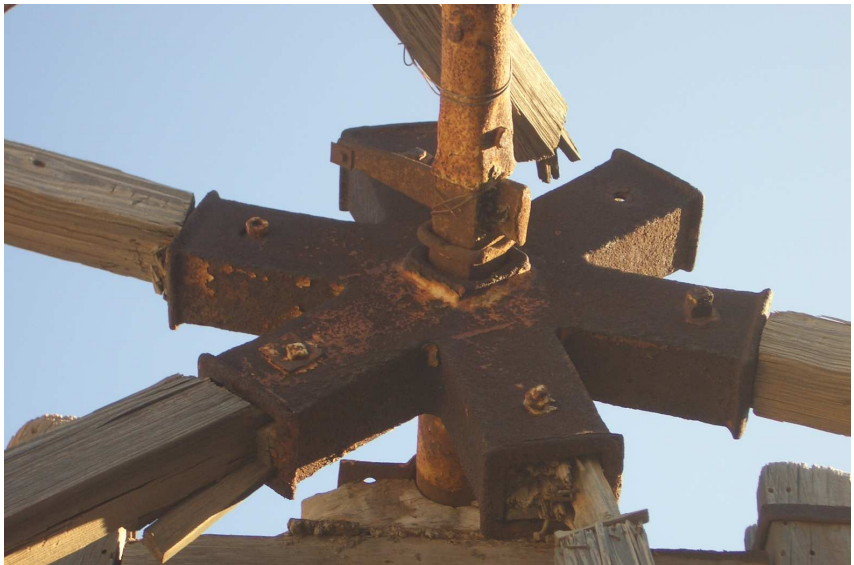
Detalle del buje hexagonal metálico. Molino en Carrizal, TM de Ingenio
