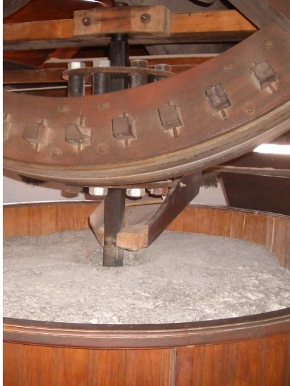
Detalle de enlace entre la canaleja y el eje metálico o aguja. Molino de viento en Tiscamanita. Fuerteventura.
