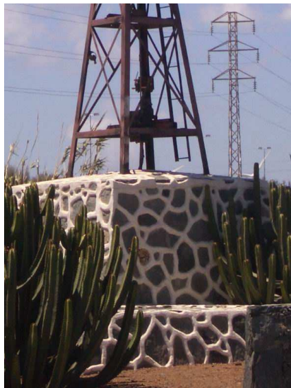
Detalle de cubierta plana construida con losa de hormigón armado y con ligeras pendientes para evacuar el agua de la lluvia. Molino de viento Aeromotor "Tipo Americano". TM de Ingenio. Gran Canaria.
