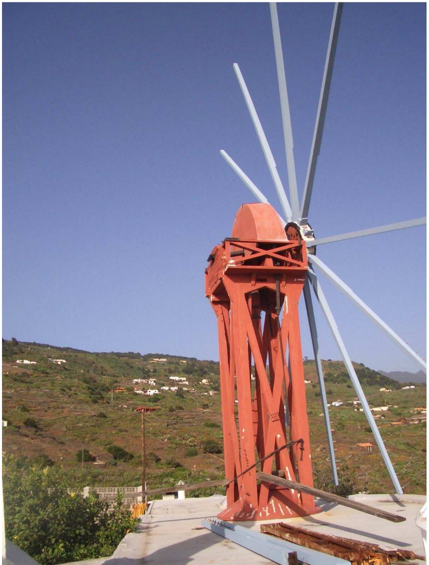
Detalle de palos de orientación situados en la base de la torre cuadrada de madera del molino de viento en El Loder. TM de la Villa de Mazo. La Palma.
