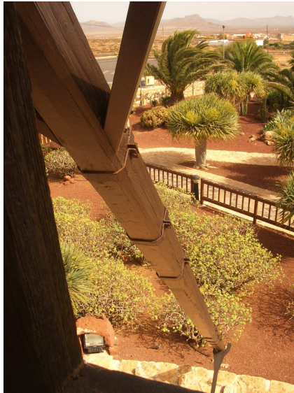
Detalle del palo de gobierno, timón o rabo del molino de viento en TM La Antigua. Fuerteventura.
