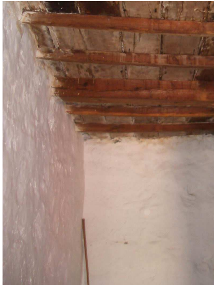
Detalle del acabado interior con mortero de cal del edificio del molino de viento "Sistema Romero" en Carrizal, TM Ingenio. Gran Canaria.
