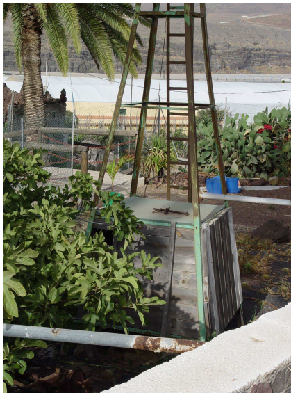
Detalle del edificio construido en madera del molino Aeromotor “Tipo Americano” en TM La Aldea de San Nicolás, Gran Canaria.
