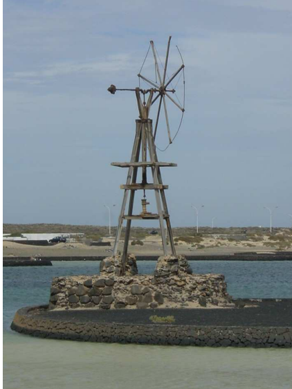
Detalle del estancadero de agua de mar y del molino de viento "Salinero Canario" de rotor de ocho aspas de velas de lonas y torre descuadrada de arriostre de madera. Lanzarote.
