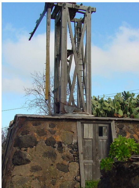
Edificio de planta rectangular y cubierta a cuarto aguas del molino de viento tipo "Sistema Ortega" en El Pueblo. TM de Puntagorda. La Palma.
