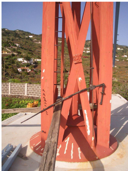
Detalle de la palanca que acciona el freno desde la cubierta del edificio del molino de viento en El Lodero, TM de La Villa de Mazo. La Palma.
