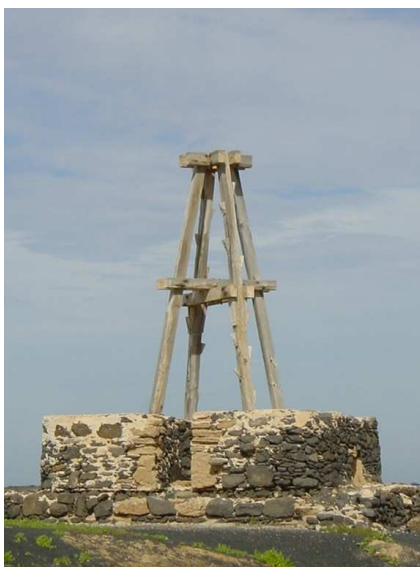
Detalle del edificio en Pozo y torre de madera del molino de viento aeromotor “Salinero Canario” en las salinas de La Santa, Lanzarote.
