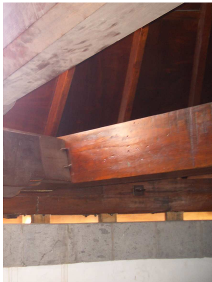
Detalle enlace de anillo inferior fijo compuesto por los canes y anillo superior móvil de la cubierta del molino de viento en TM Mogán. Gran Canaria.
