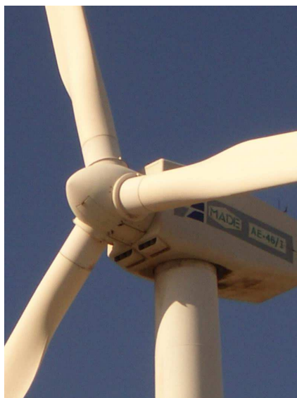
Detalle de nariz del aerogenerador de tres palas de la marca Made.
