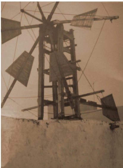
Detalle de gran cola de tablones de madera anclada a la torre del molino de viento "Sistema Romero" situado en Carrizal. TM de Ingenio. Gran Canaria.
