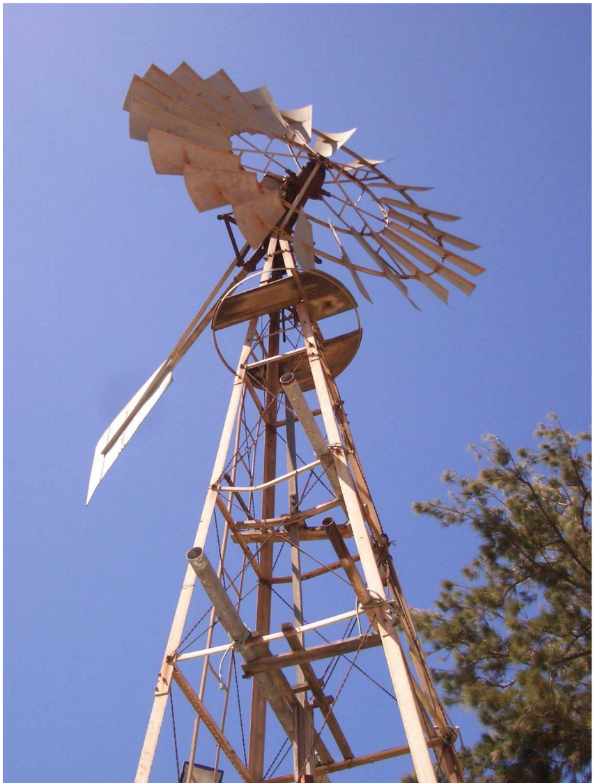
Detalle de la torre piramidal de estructura metálica triangulada y rigidizada con pletinas y cables rígidos de acero del molino de viento Aeromotor "Tipo Americano" en TM de La Aldea de San Nicolás. Gran Canaria.
