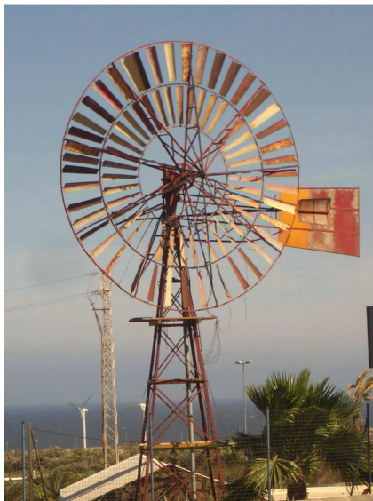
Detalle del rotor multipala de aspas de chapas metálicas sobre torre piramidal metálica del molino de viento del modelo “Manuel Santana” en TM de Ingenio. Gran Canaria.
