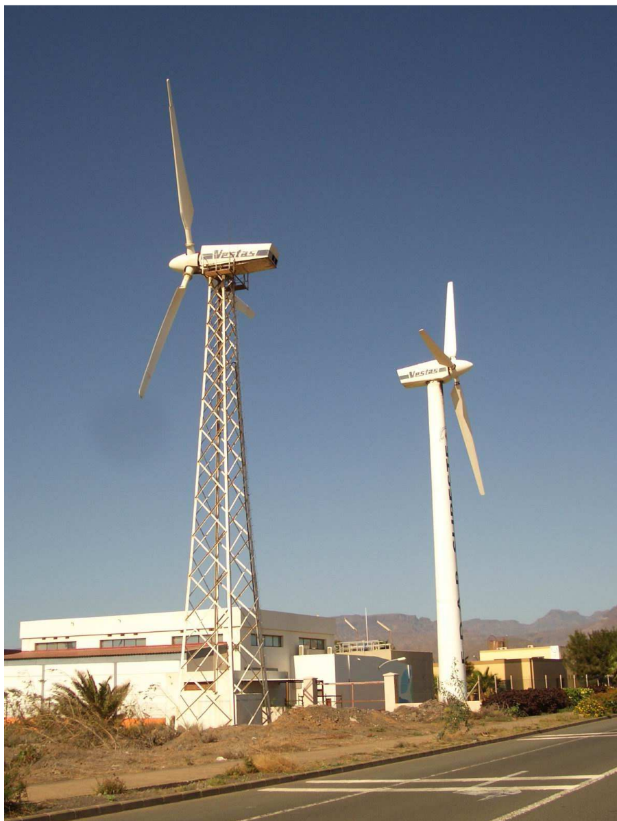
Aerogeneradores de rotor tripala y torre tubular de acero. TM de Mazo. La Palma.
