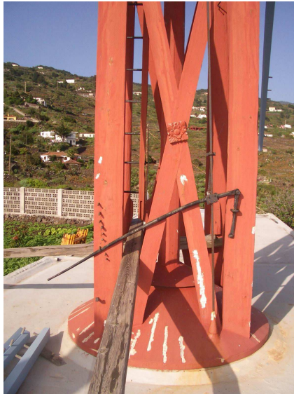
Detalle del cono metálico que protege el enlace de la torre cuadrada de madera con la cubierta del edificio del molino de viento en El Lodero. TM de la Villa de Mazo. La Palma.
