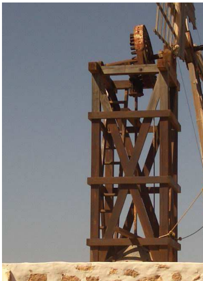
Detalle de la torre del molino de viento harinero “La Molina” en Tefía, Fuerteventura y torre de madera del molino “salinero canario” en Yaiza, Lanzarote.
