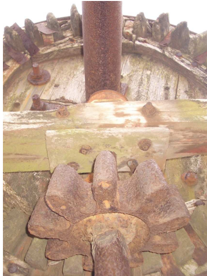
Detalle de enlace del piñón con la rueda catalina o capacete del molino de viento en Tirimaga, TM de La Villa de Mazo. La Palma. Esta solución de piñón o linterna es la más habitual.
