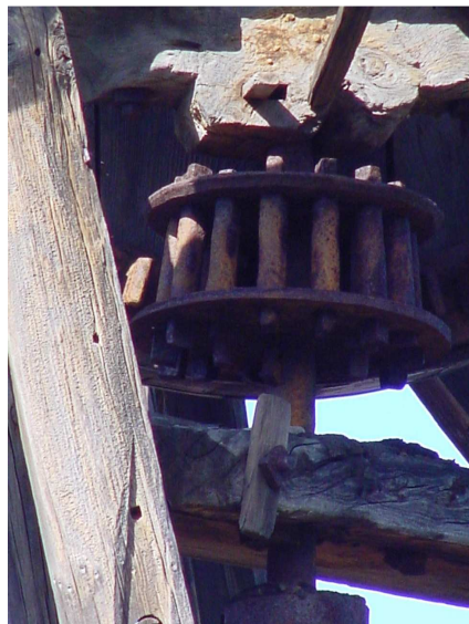
Detalle de enlace del piñón con la rueda catalina o capacete del molino de viento en Las Tricias, TM de Garafía. La Palma. Esta solución de piñón o linterna es la menos habitual.
