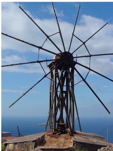
Detalle de la cubierta inclinada a cuatro aguas del edificio del molino de viento en Santo Domingo. TM de Garafía. La Palma.
