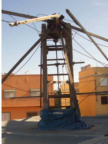
Detalle del exterior de la torre cuadrada de madera del molino de viento "Sistema Romero" en Carrizal. TM de Ingenio. Gran Canaria.
