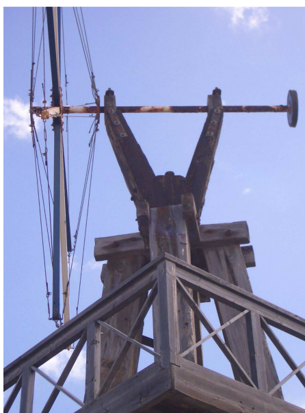
Detalle de los brazos de la estructura soporte del sistema de transmisión. Molino de viento "Salinero Canario" en Costa Tegui. Lanzarote.
