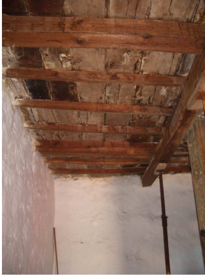
Detalle del acabado interior de la cubierta plana del edificio del molino "Sistema Romero" en Carrizal. TM de Ingenio. Gran Canaria.
