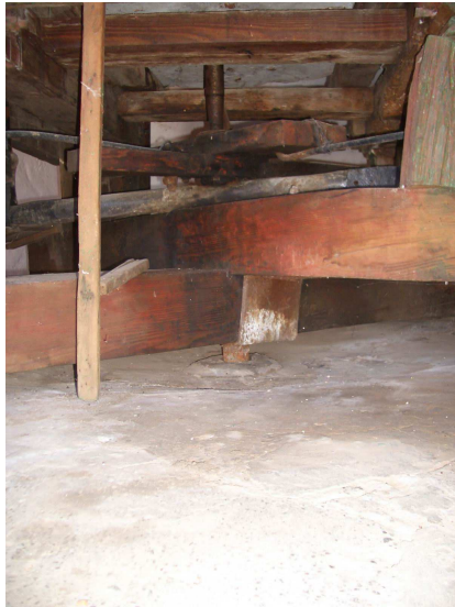
Detalle del pavimento interior del edificio del molino de viento "Sistema Romero". El acabado de dicho pavimento se realiza con una solera de hormigón.
