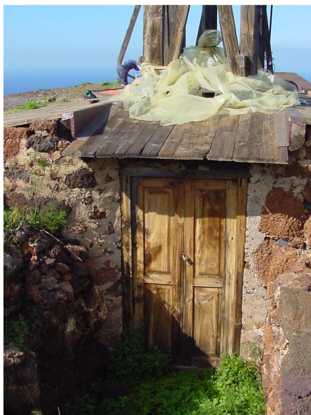
Detalle de acceso al edificio y acabado exterior de los muros de cerramiento del edificio del molino de viento en Las Tricias. TM de Garafía. La Palma.
