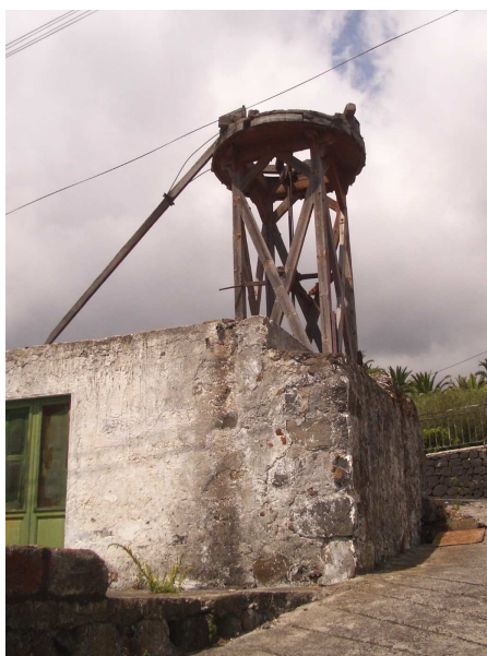
Edificio de planta rectangular y cubierta plana del molino de viento tipo "Sistema Ortega" en TM de Breña Alta. La Palma.
