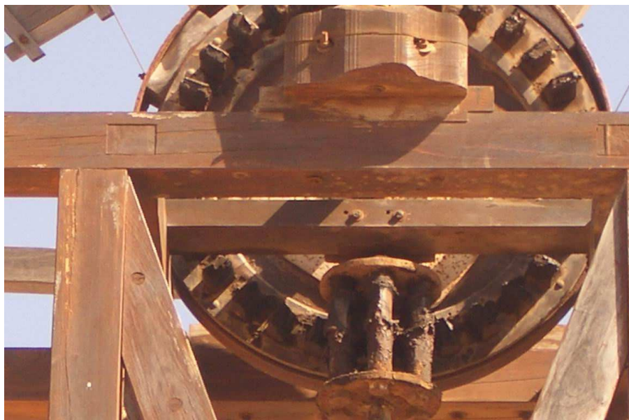
Enlace de la linterna y la rueda catalina de la molina. Tefía, Fuerteventura.
