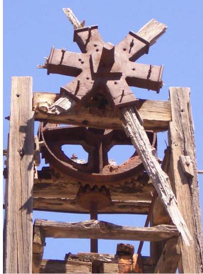
Detalle del buje hexagonal metálico donde se incrustan los largueros de las aspas del molino de viento "Sistema Romero" en Artejevez, TM de La Aldea, Gran Canaria.
