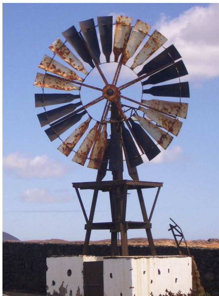
Detalle del rotor multipala de chapa metálica. Molino de viento "Salinero Canario". Costa Tegui. Lanzarote.
