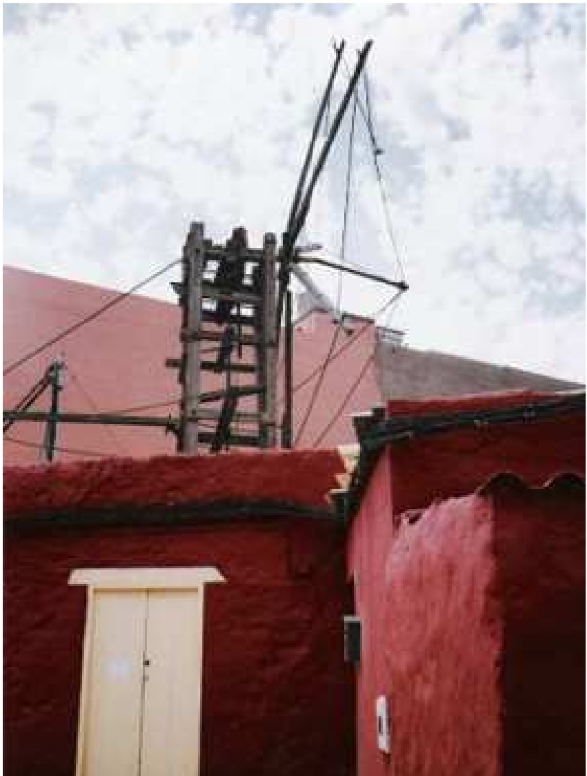
Molino de viento tipo "Sistema Romero" de rotor de seis aspas en Carrizal. TM Ingenio. Gran Canaria.
