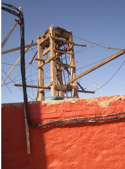
Detalle de enlace de los dos ejes o largueros arriostrados con cables en sus extremos y que configuran la cola de orientación de la torre cuadrada de madera del molino de viento "Sistema Romero" en Carrizal. TM de Ingenio. Gran Canaria.
