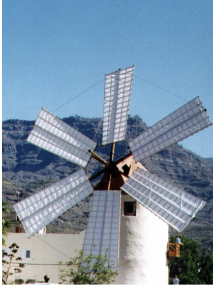
Molino de viento "Tipo Torre" con el rotor compuesto de seis aspas. TM de Mogán. Gran Canaria.
