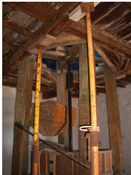
Detalle de enlace en el interior del edificio de la torre cuadrada de madera con la cubierta plana del molino de viento "Sistema Romero" en Carrizal. TM de Ingenio. Gran Canaria.
