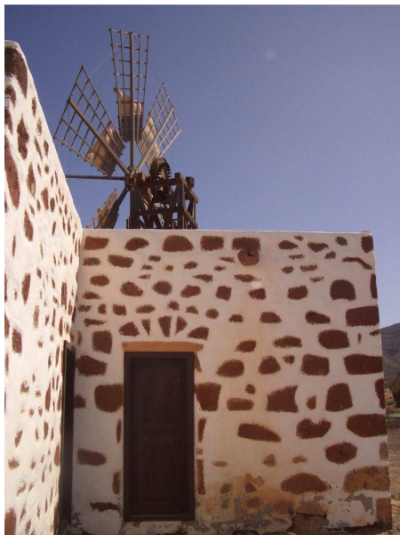
Detalle de acceso al edificio de planta rectangular y cubierta plana del molino de viento "La Molina" en Tefía, TM de Puerto del Rosario, Fuerteventura.
