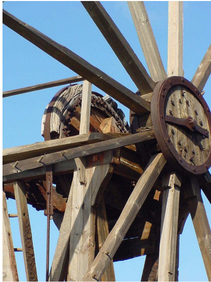
Detalle del freno sobre la rueda catalina o capacete del molino de viento en El Calvario, TM de Garafía. La Palma.
