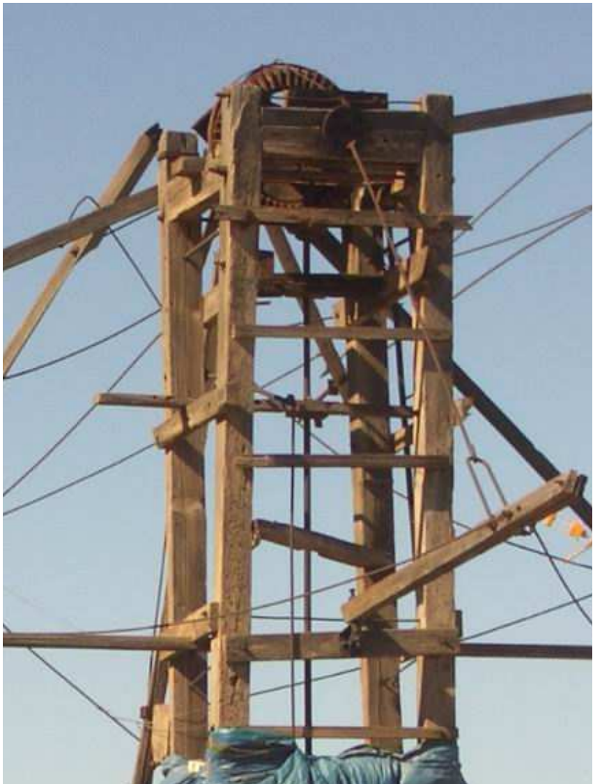
Detalle de la torre cuadrada de madera del molino de viento del "Sistema Romero" en el Lomo de Artejevez. TM de La Aldea de San Nicolás. Gran Canaria.
