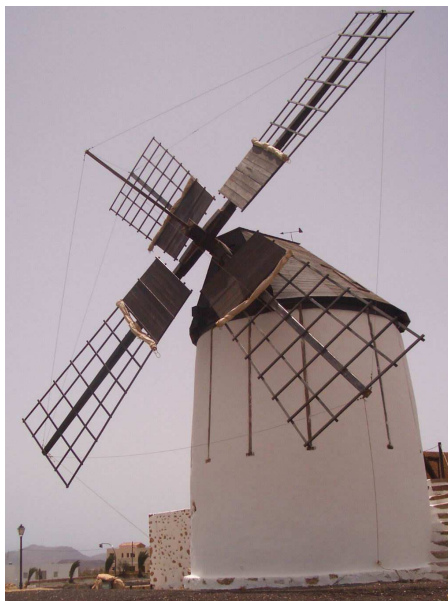
Detalle de acabado exterior de los muros de cerramiento del edificio. Molino de viento en Tiscamanita. TM de Tuineje. Fuerteventura.
