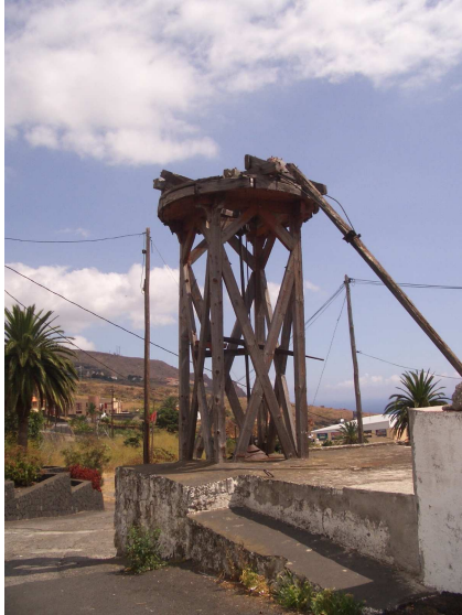
Detalle de la adaptación del palo de orientación, timón o rabo del molino de viento "Tipo Torre" en el molino de viento "Sistema Ortega". Dicho palo de orientación tiene una dirección oblicua y nace en la coronación de la torre cuadrada de madera y termina a un metro del suelo. Molino de viento situado en TM de Breña Alta. La Palma.
