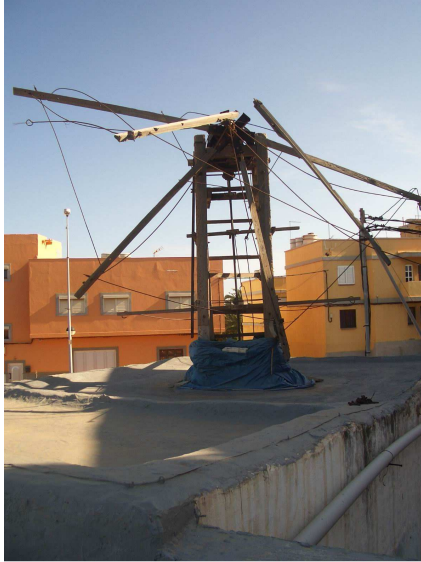
Detalle de la torre y el rotor de seis aspas del molino de viento "Sistema Romero" en Carrizal. TM de Ingenio. Gran Canaria.
