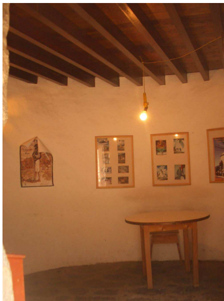
Detalle de acabado interior del los pavimento y los forjados del edificio. Molino de viento en Mogán, Gran Canaria.
