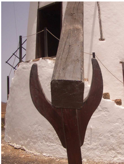
Detalle de la estaca para anclar el palo de gobierno, timón o rabo del molino de viento en Tiscamanita. TM de Tuineje. Fuerteventura.
