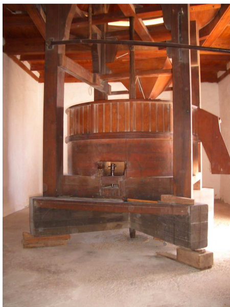
Detalle de la maquinaria incrustada en la torre cuadrada de madera de la molina de viento en Tefía, TM de Puerto del Rosario. Fuerteventura.
