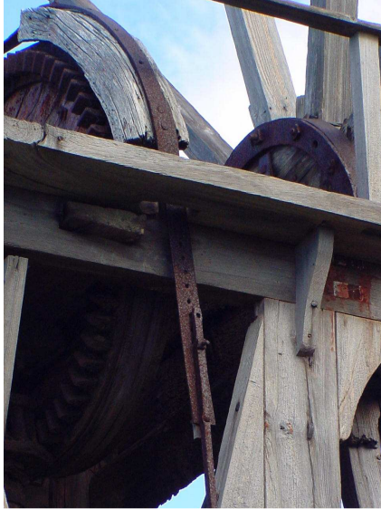
Detalle del freno del molino de viento en El Calvario. TM de Garafía. La Palma.
