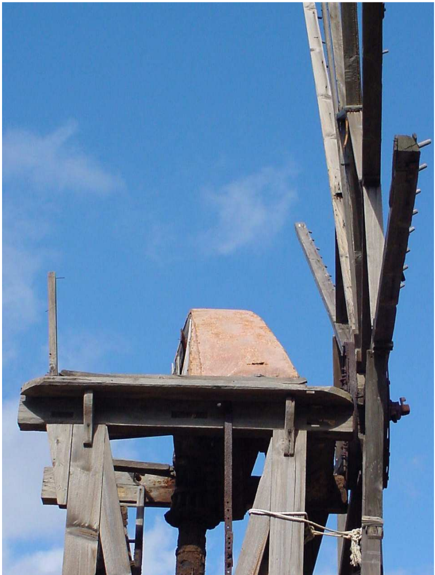
Detalle del freno del molino de viento en El Calvario. TM de Garafía. La Palma.
