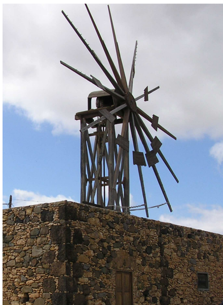
Detalle del rotor compuesto por doce aspas. Molina de viento en el Valle de Los Ortega. Fuerteventura.
