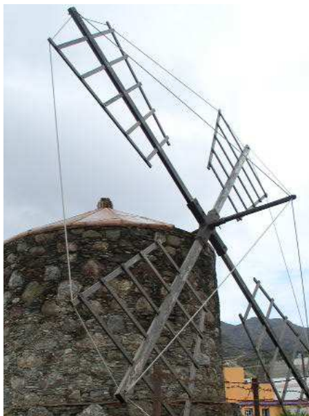
Detalle del rotor de cuatro aspas del molino de viento "Tipo Torre" de Los Majanos, TM La Aldea de San Nicolás. Gran Canaria.
