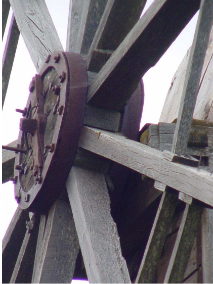
Detalle del sistema de tuerca y contratuerca en los largueros de las aspas del molino de viento en Llano Negro. TM de Garafía. La Palma.
