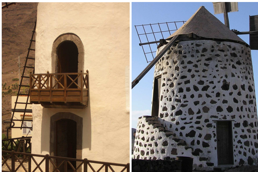
Detalle de diferentes tipos de acabados de los muros de cerramiento del edificio del molino y el encuentro con las carpinterías de las puertas de acceso. Molino de viento en Mogán, Gran Canaria y molino de viento en Lajares, TM de La Oliva. Fuerteventura.
