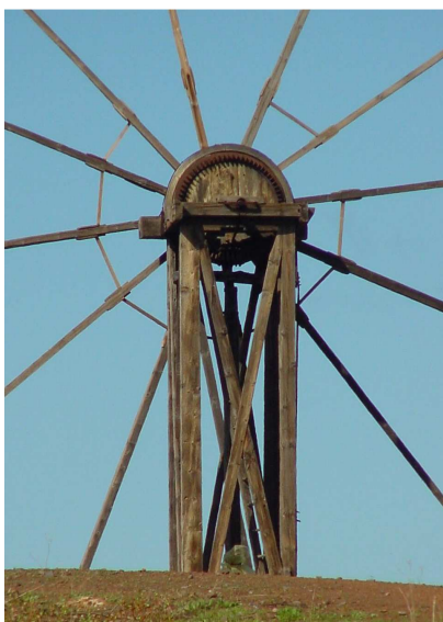
Detalle de rigidización del rotor de aspas. TM de Garafía. La Palma.
