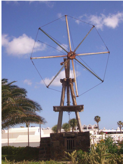
Detalle de molino de viento "Salinero Canario" de rotor de ocho velas y torre descuadrada de crucetas de madera en Costa Teguise. Lanzarote.
