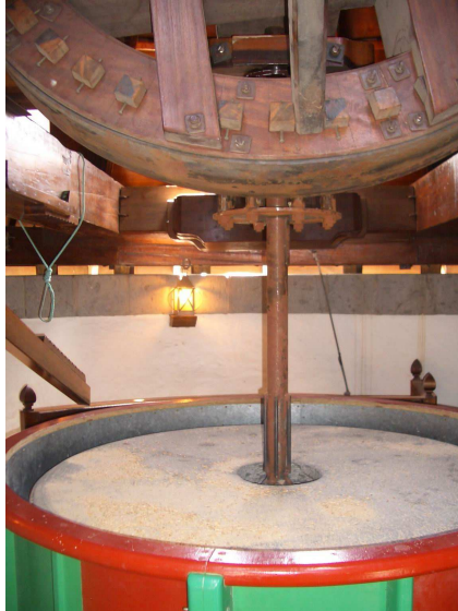
Detalle de enlace del eje vertical que se corona con el husillo y traslada el movimiento de rotación de la rueda catalina a las piedras molederas del molino de viento en TM Mogán. Gran Canaria.
