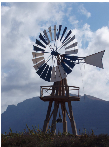
Detalle de la torre de madera y del rotor multipala de chapa metálica del molino de viento aeromotor del País de fabricación artesanal en Lanzarote.
