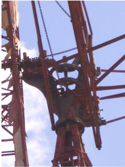
Detalle del sistema de transmisión biela-cigüeñal situado en la parte superior de la torre metálica del molino de viento aeromotor tipo "Manuel Santana" en TM de Ingenio, Gran Canaria.
