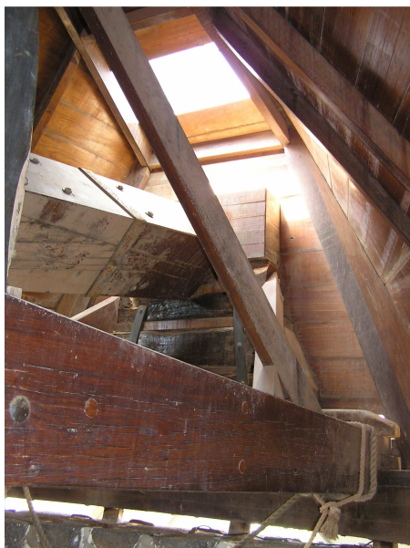
Detalle de cubierta y salida del eje que sostiene el rotor. Molino de viento en TM de La Antigua, Fuerteventura.
