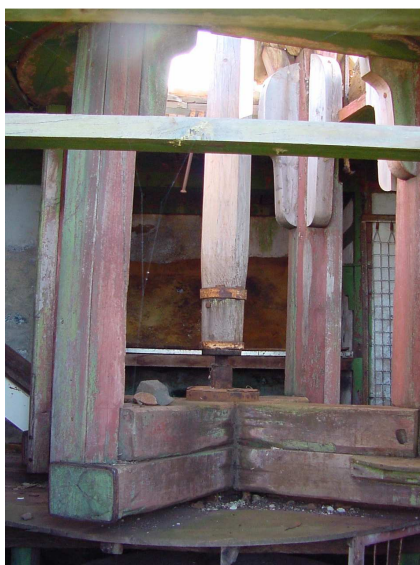
Detalle del enlace en el interior del edificio de la torre cuadrada de madera con cubierta inclinada y con altillo de madera del molino de viento en El Calvario. TM de Garafía. La Palma.
