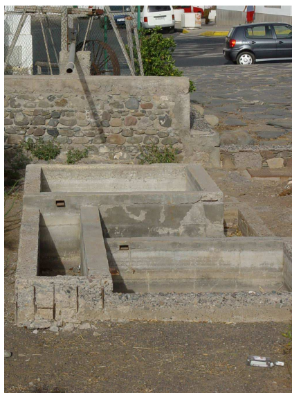
Detalle tanqueta de derivación del agua hacia las acequias que la trasladan hacia el tanque o depósito de almacenamiento de molino de viento aeromotor "Tipo Americano" en TM La Aldea de San Nicolás, Gran Canaria.
