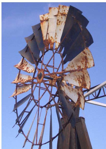
Detalle del rotor multipala de chapa metálica de veinticuatro aspas y ocho brazos rígidos del molino de viento "Salinero Canario" en Costa Tegui. Lanzarote.
