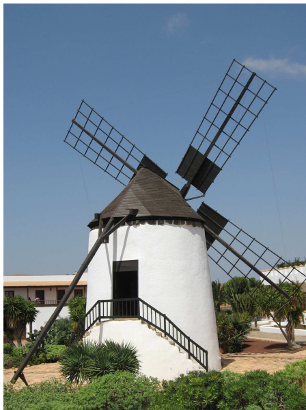
Detalle del rotor de cuatro aspas trapezoidales del molino de viento "Tipo Torre" en TM de La Antigua, Fuerteventura.
