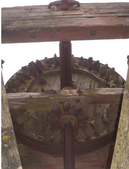
Detalle de la rueda catalina ó capacete cuyos dientes están configurados por cuñas de madera que se incrustan sobre el círculo de madera del molino de viento en TM de La Villa de Mazo, La Palma.
