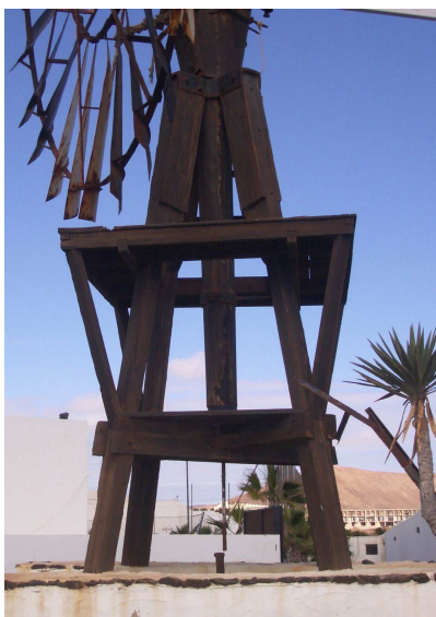
Detalle de distintos tipos de torres piramidales de crucetas horizontales de madera con distintos tipos de plataformas horizontales donde se posibilita el mantenimiento del rotor y del sistema de transmisión del molino de viento "Salinero Canario". Costa Teguise. Lanzarote.
