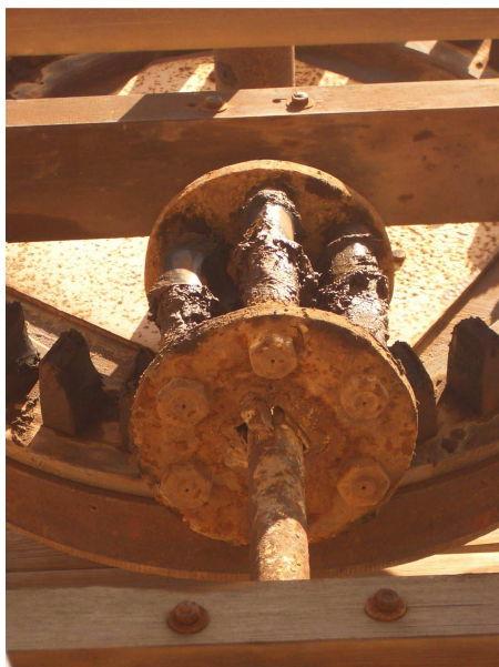
Detalle de la linterna compuesta por pivotes cilíndricos de hierro de la molina de viento en Tefía, TM de Puerto del Rosario. Fuerteventura.
