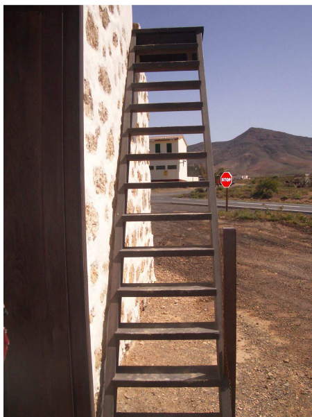
Detalle de la escalera exterior de madera de la molina en Tefía, TM de Puerto del Rosario. Fuerteventura.
