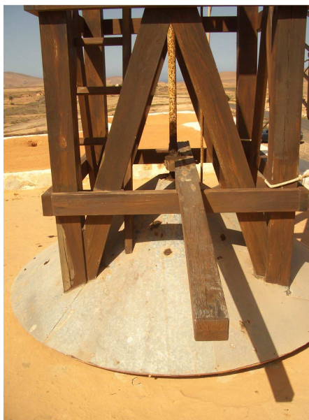
Detalle del palo de orientación, timón o rabo de la molina de viento en Tefía, TM de Puerto del Rosario. Fuerteventura.
