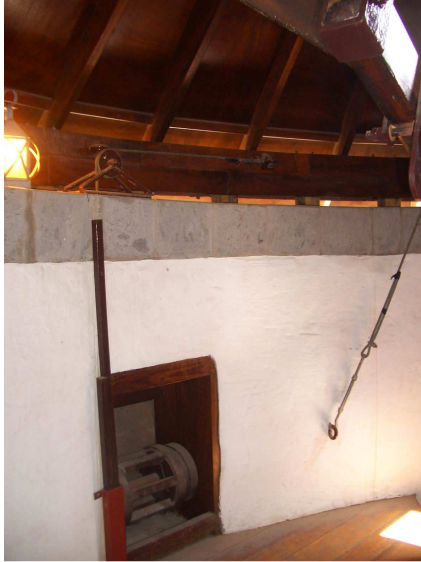
Detalle del engranaje que permite la rotación de la cubierta del molino de viento en TM Mogán. Gran Canaria.
