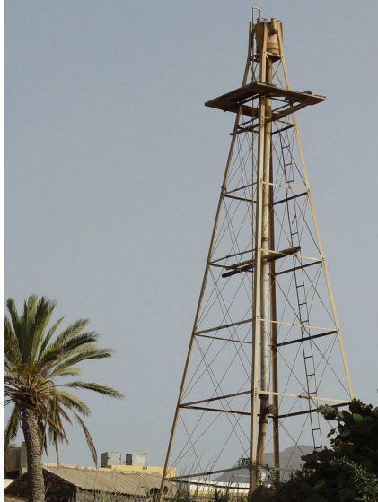
Detalle de la torre piramidal de estructura metálica triangulada y rigidizada con pletinas y cables rígidos de acero del molino de viento Aeromotor "Tipo Americano" en TM de La Aldea de San Nicolás. Gran Canaria.
