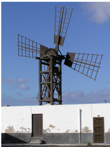
Detalle del edificio, la torre y el rotor de cuatro aspas de la molina de viento en Lajares. Fuerteventura.
