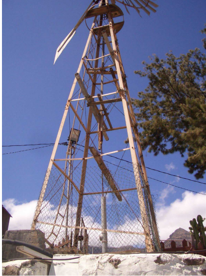
Detalle del vergajón metálico del molino de viento aeromotor "Tipo Americano" en TM La Aldea de San Nicolás. Gran Canaria.
