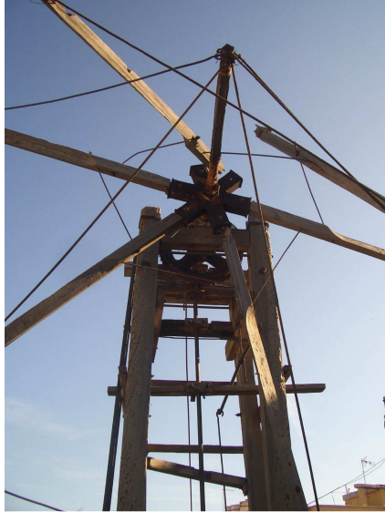
Detalle de la torre y el rotor del molino de viento en Carrizal. TM de Ingenio. Gran Canaria.
