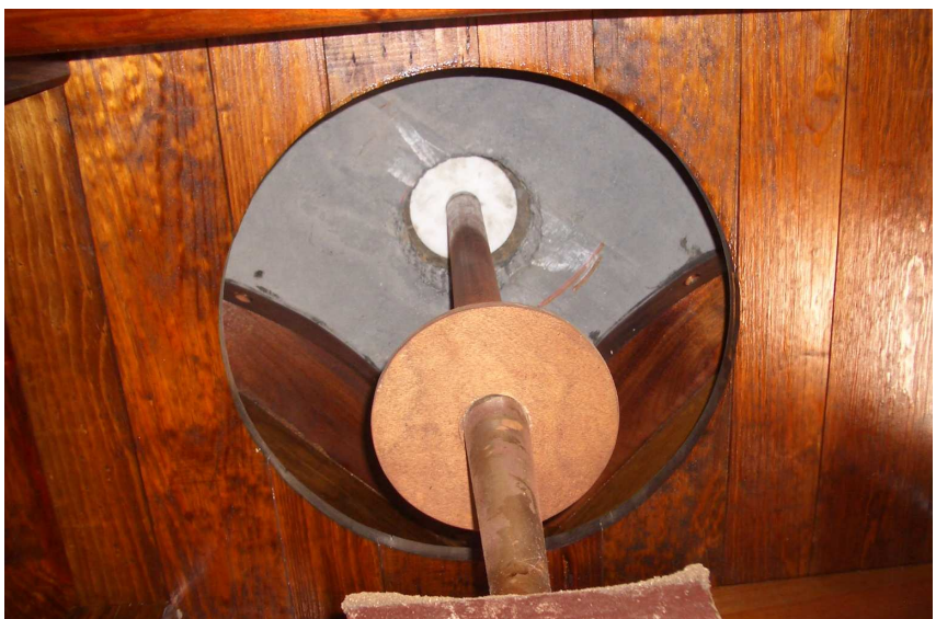
Detalle de aliviador y trampilla de forma octogonal bajo la piedra fija e inferior del molino de viento en TM de La Antigua. Fuerteventura.
