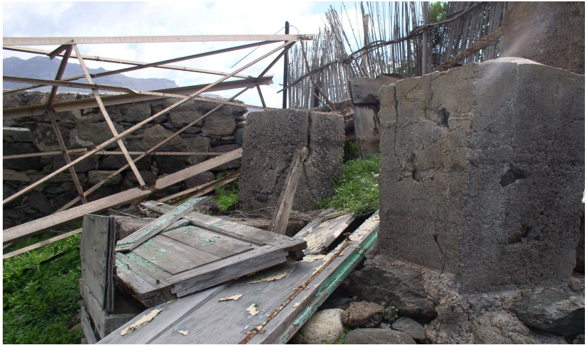
Detalle de dados de hormigón de apoyo de la torre del aeromotor
