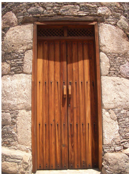
Detalle de la puerta de acceso al edificio y acabado exterior de los muros de cerramiento del molino de viento "Tipo Torre" de Los Majanos, TM La Aldea de San Nicolás, Gran Canaria.
