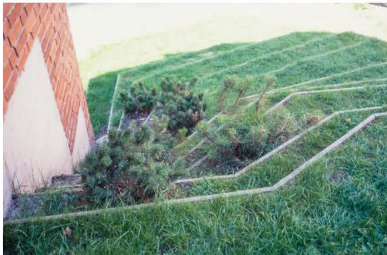
338. Escalera de tierra contenida por una estructura de estacas y tableros. La escalera actual es una reconstrucción modificada de la realizada inicialmente. Fotografía del doctorando.
