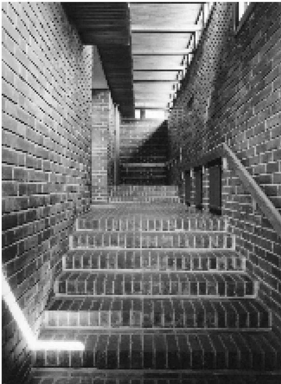
166. AAA 100883 El segundo tramo de la escalera de acceso a la Sala del Concejo.
