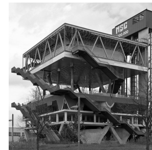
MVDRV. Pabellón de Holanda. Expo de Hannover, 2000.
