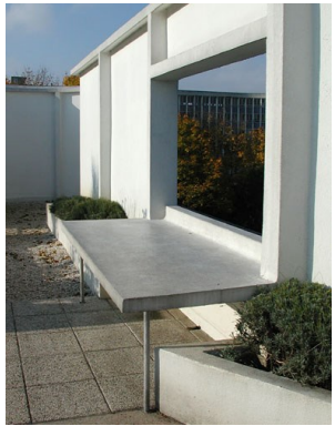
Le Corbusier. Ventana en el solárium de la Villa Savoye, 1929.
