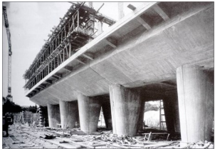
Unité en construcción.
