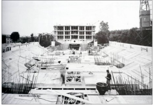
Unité en construcción.
