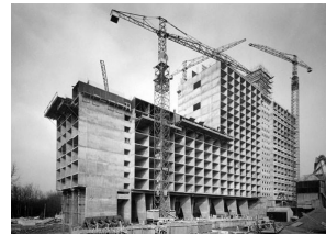
Unité en construcción.
