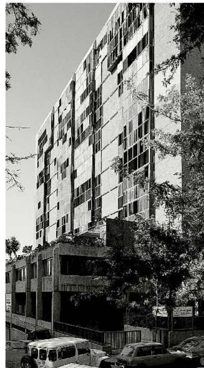
figura 4.1.31 Edificio Isla de Tenerife (1974- 1977), F_JRO
