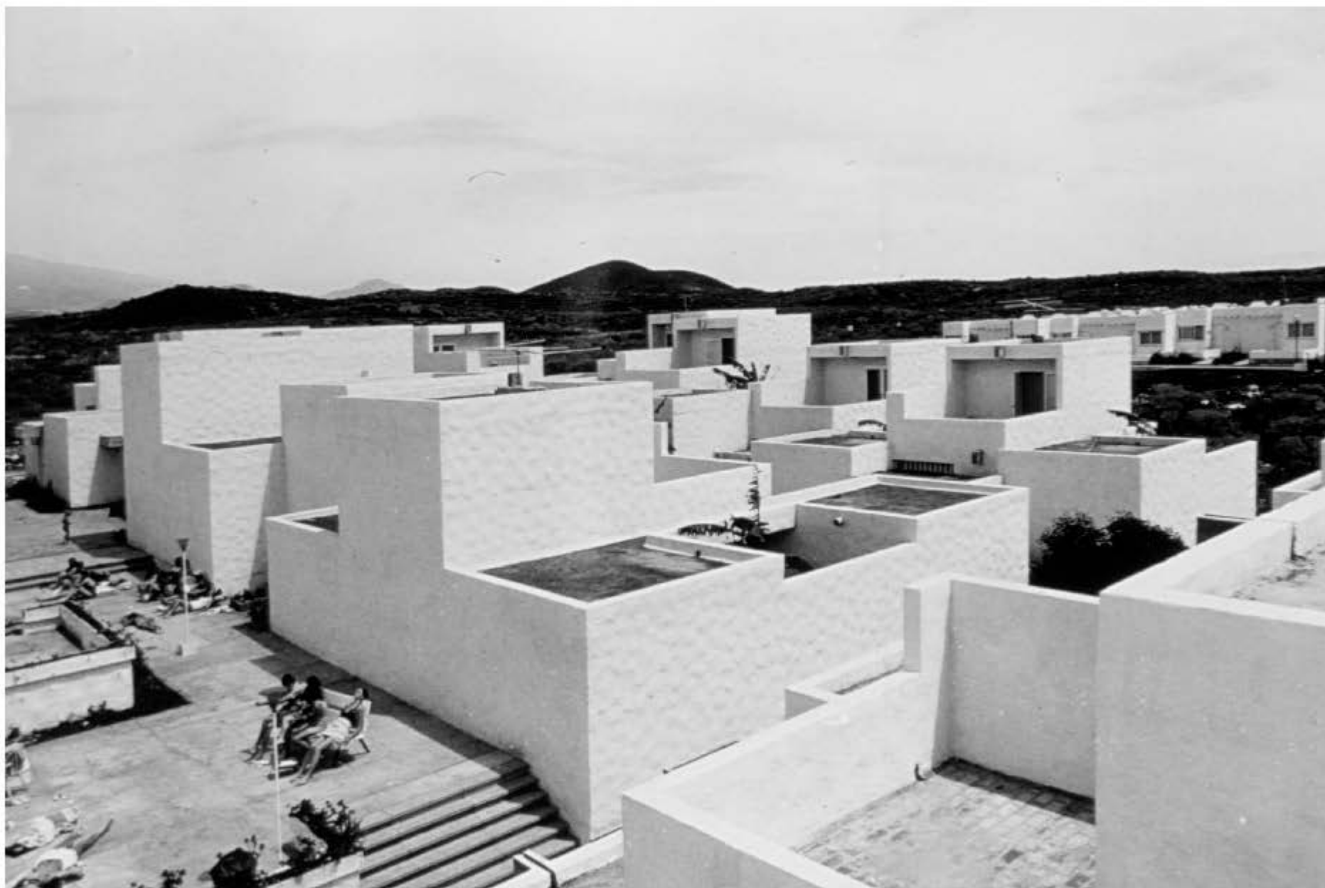
figura 6.2.40 Agrupación Santa Ana (1967-1973), la plaza central y las terrazas en cubierta, F_LC
