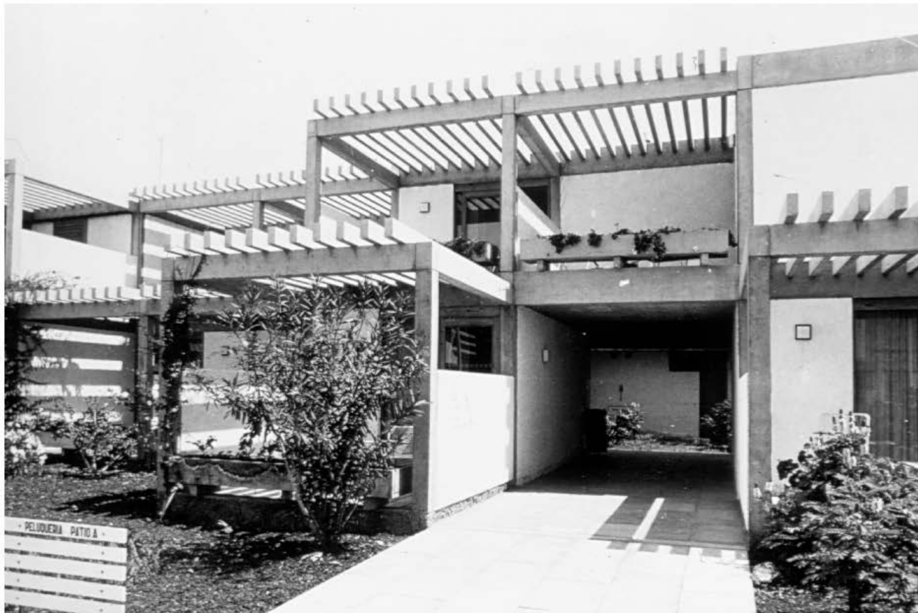
figura 4.2.37 Agrupación Drago (1967- 1970), entrada al patio interior, F_EP
