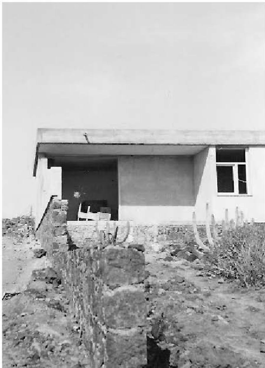
figura 6.3.11 Agrupación Bellavista (1963-1965), murete escalonado lateral
