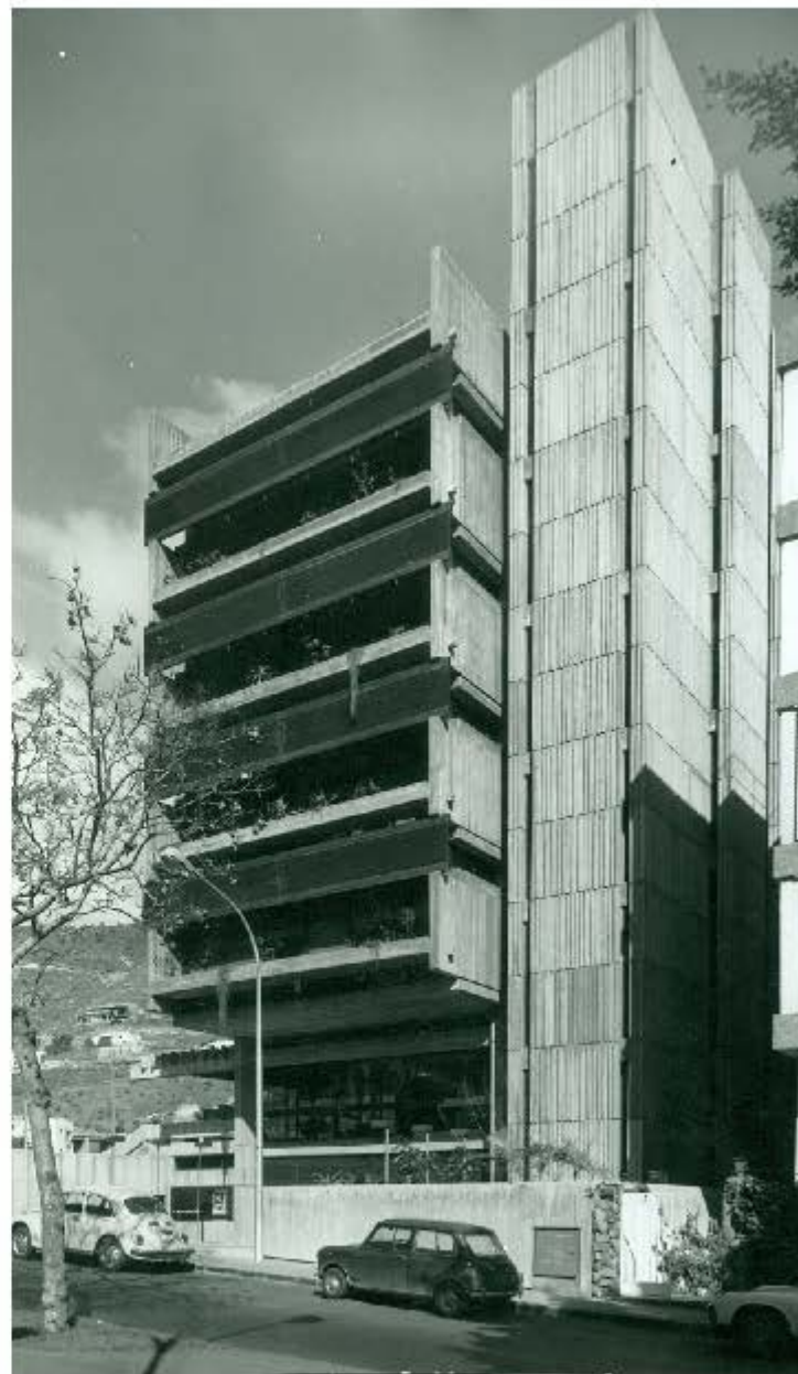
figura 4.1.13 Colegio Oficial de Arquitectos (1966- 1971), F_EP
