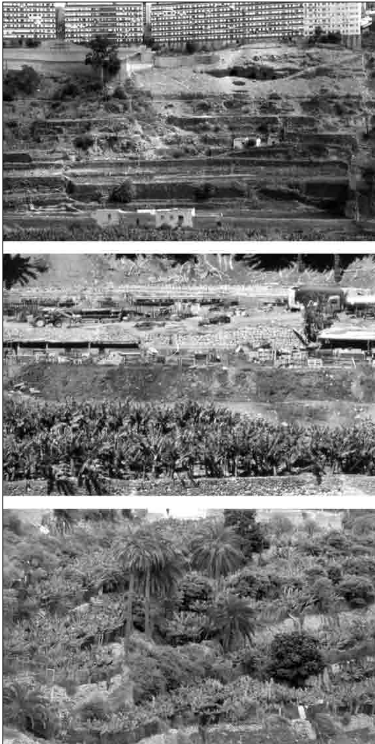
Fotografía 3. Impactos ocasionados en los bancales del Guiniguada.
