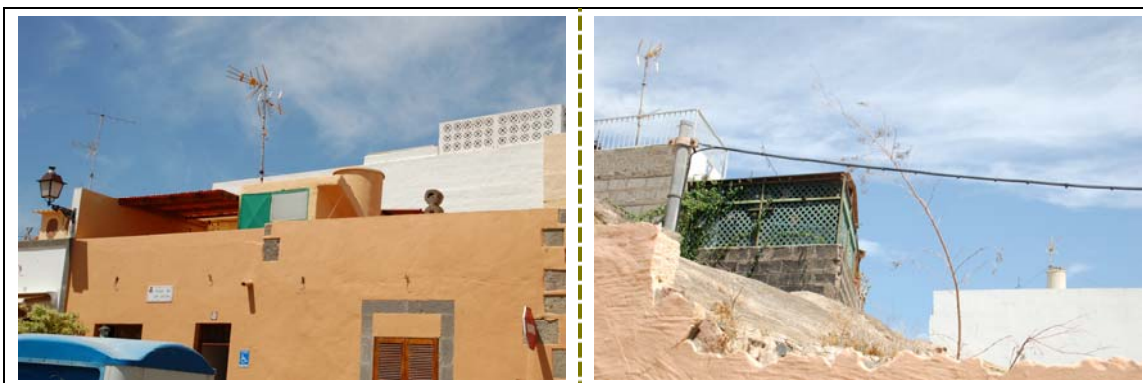
Figura 43. INTEGRACIÓN DE ACTUACIONES EN CUBIERTAS CON IMPRONTA PAISAJÍSTICA PESE A LA NORMATIVA DEL PEPRI DE AGUIMES
