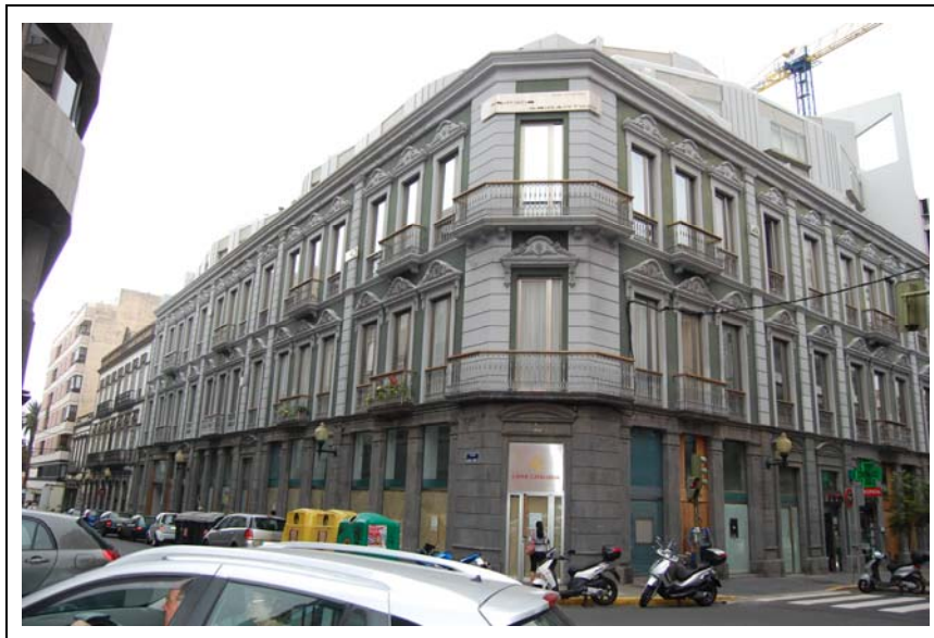
Figura 70. EJEMPLO DE RENOVACIÓN EDIFICATORIA ACORDE A LA REGULACIÓN DE LA NORMATIVA DEL PEPRI DE VEGUETA-TRIANA EN LA CALLE VIERA Y CLAVIJO, ESQ. BUENOS AIRES
