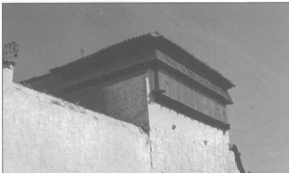
Lámina 9: Mirador-ajimez de Santa Catalina, hacia la Calle de la Carrera, La Laguna (Tenerife).
