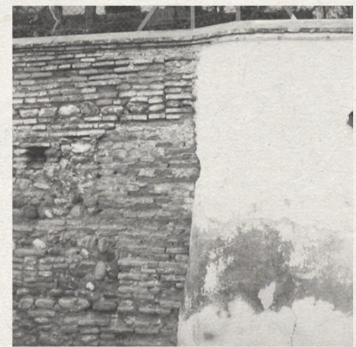
ESTADO ACTUAL · MURO C
