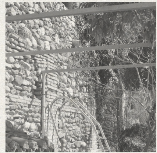
ESTADO ACTUAL · MURO A
