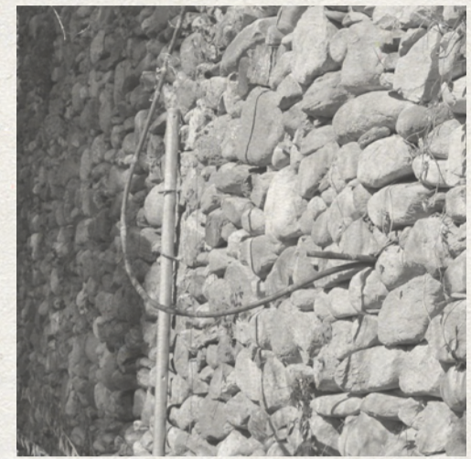
ESTADO ACTUAL · MURO A
