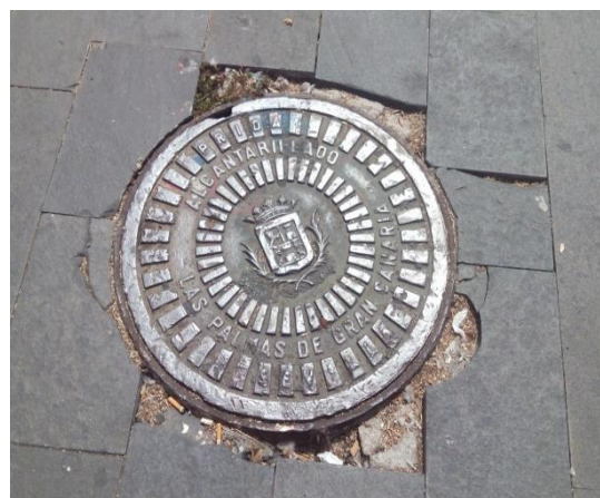
Imagen 9: Ejemplo de problemas de destrucción de pavimento perimetral de registros
