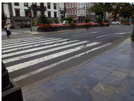
Imagen 32 y 33: Ejemplo de vados peatonales de un mismo del paso de peatón que atraviesa la Carretera del Norte. Carece de pavimento indicador táctil y contrastado color.
