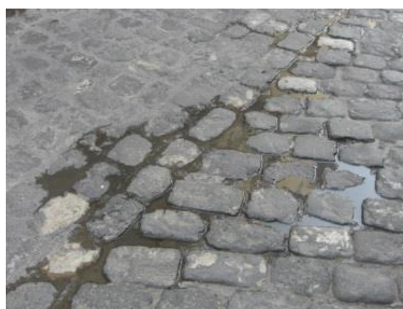
Imagen 5: Estancamiento de agua en juntas entre adoquines
