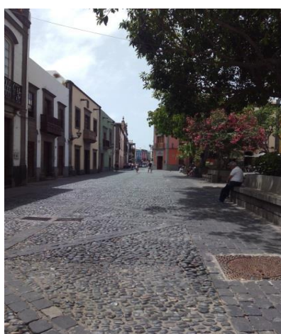
Imagen 6 y 7: Ejemplo de pavimento de canto rodado con desnivel de superficie de 2,5 cm en Calle Felipe Massieu
