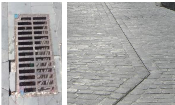
Imagen 10 y 11: Los dos tipos de rejillas que nos encontramos dentro de la ruta.
