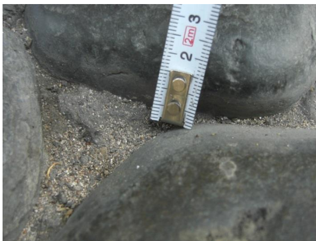
Imagen 6 y 7: Ejemplo de pavimento de canto rodado con desnivel de superficie de 2,5 cm en Calle Felipe Massieu
