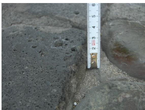
Imagen 4: Adoquín con rebaje de casi 3 cm respecto a cota de superficie peatonal
