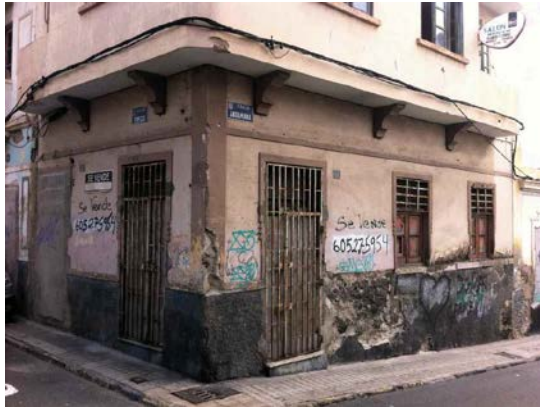
Casas tradicional con local comercial abandonada en la calle Andamana. [13]
