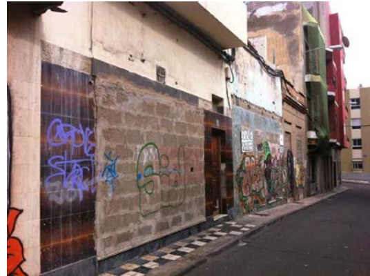
Viviendas y locales tapiados en la calle Temisas.
