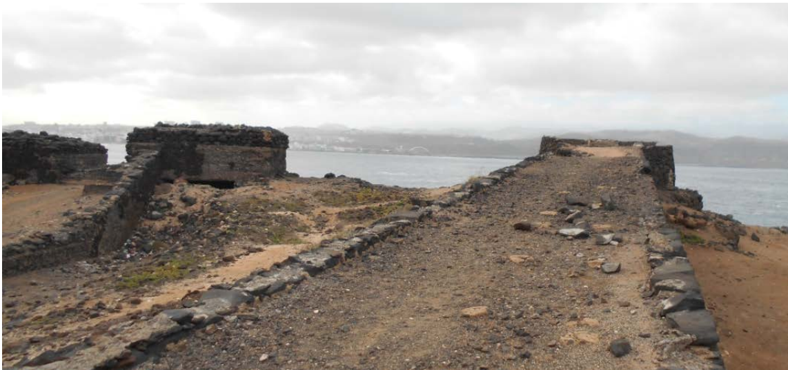
Búnker en el Confital [5]
