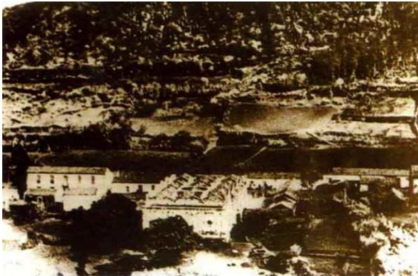
Construcción de la Iglesia San Vicente Ferrer. Al fondo el edificio del antiguo ayuntamiento. Año 1887.
