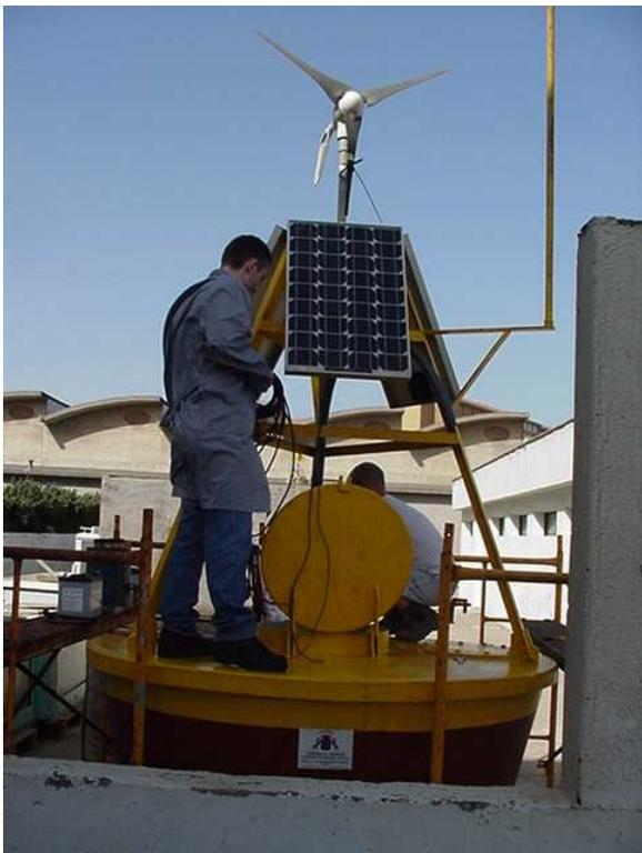
Figura 2. Instalación de los sistemas de evaluación en boya para posterior lanzamiento al mar.
