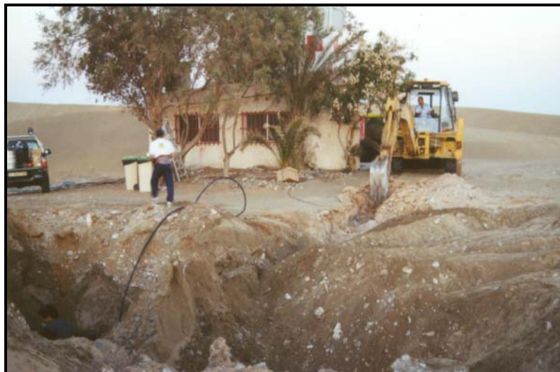
Figura VI.20. Excavación realizada para "extraer" un kiosco
