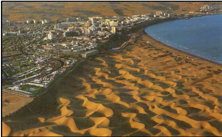
Figura V.11. Tránsito sedimentario en el sector norte de la franja del Inglés
