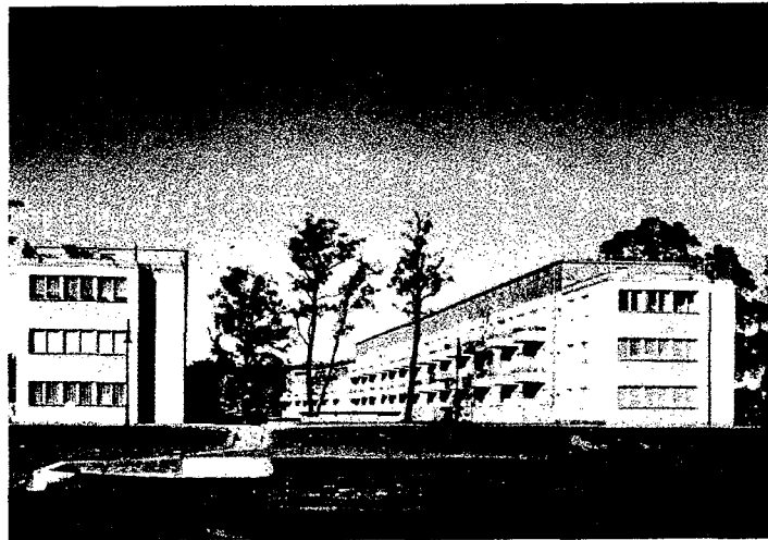
181. Edificaciones de Henning
