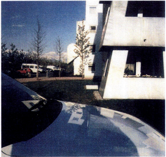
Fachada exterior del bloque Norte a la calle ancha
