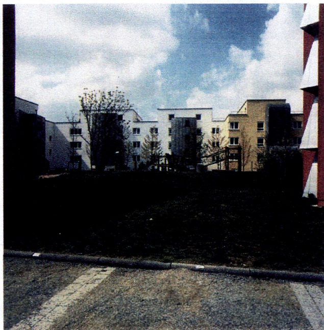
En primer plano la edificación aislada; en segundo plano el bloque Oeste
