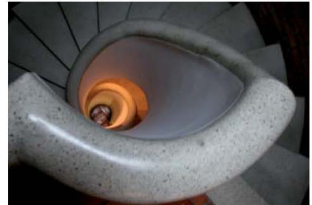
zaguanes y escaleras comunitarias. EMP
