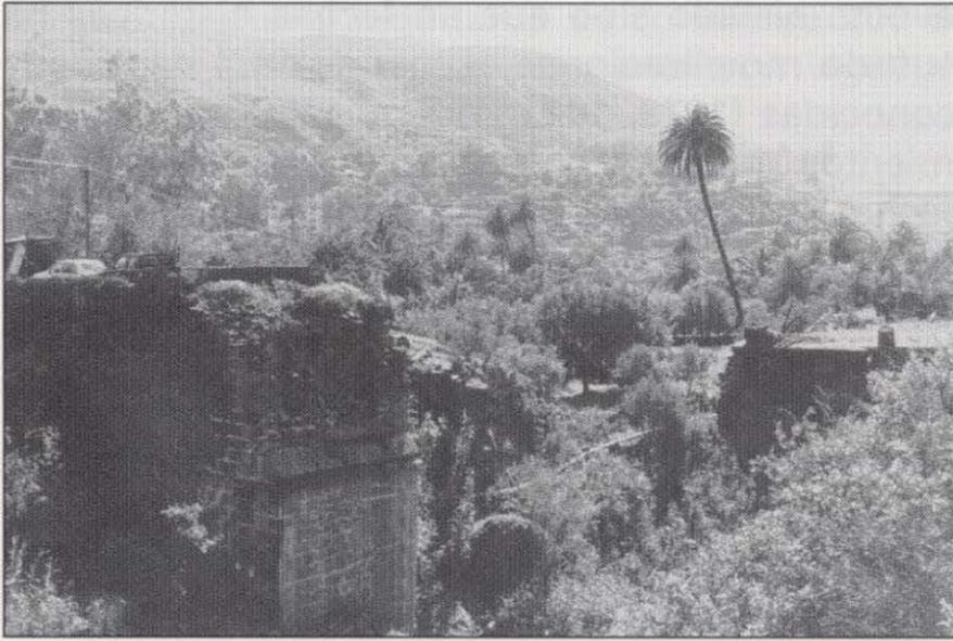
Foto 1. Efectos del deslizamiento de Rosiana de 1956; el puente definitivamente roto y palmeras inclinadas por el movimiento.
