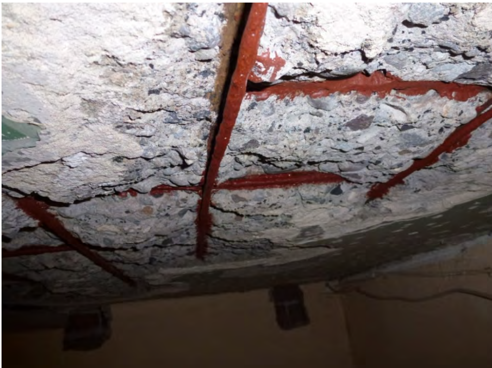
Rehabilitación por corrosión de la armadura de forjado.
