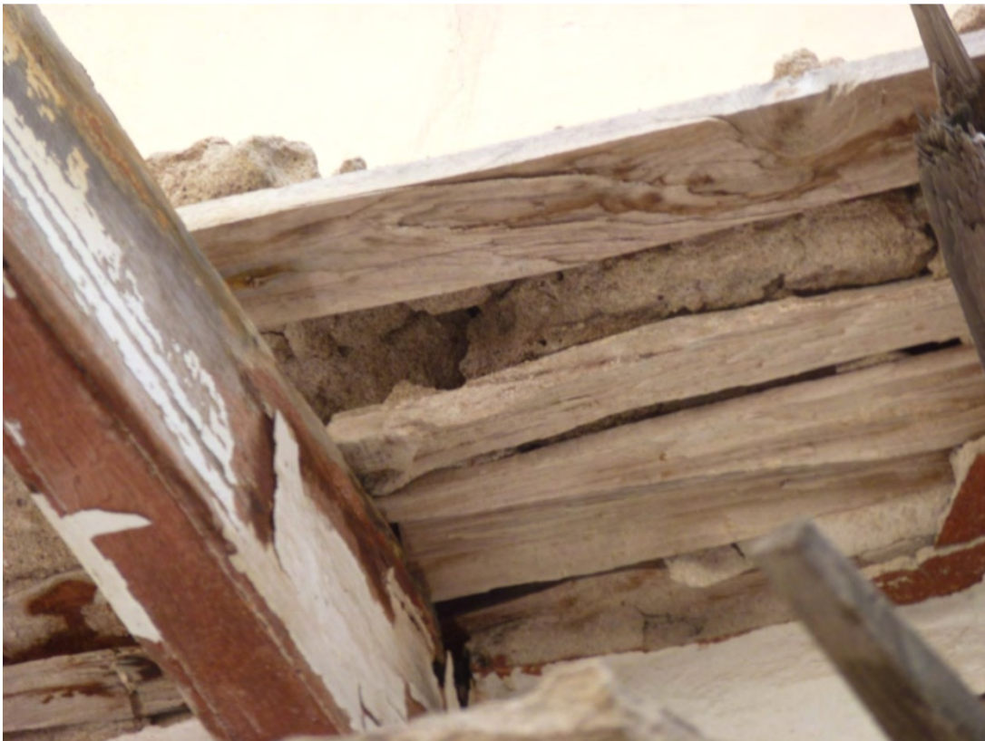
Detalle de forjado de madera.
