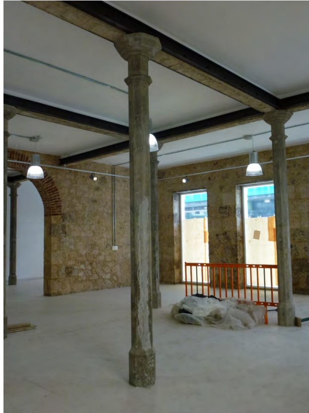
Estructura mixta de pórticos, muros y arcos.
