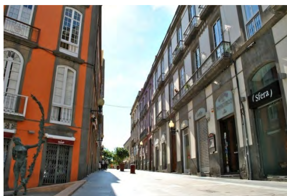
Edificio múltiple de viviendas. Calle San Pedro.
