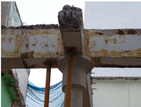
Demolición estructura porticada ortogonal. Hormigón armado.
