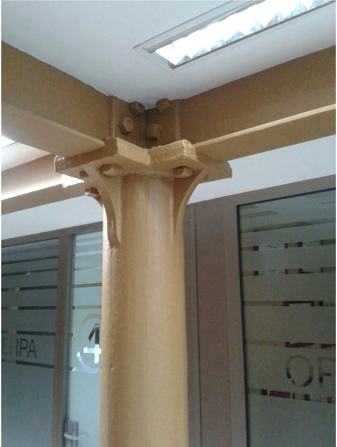
Pilar metálico empotrado.
