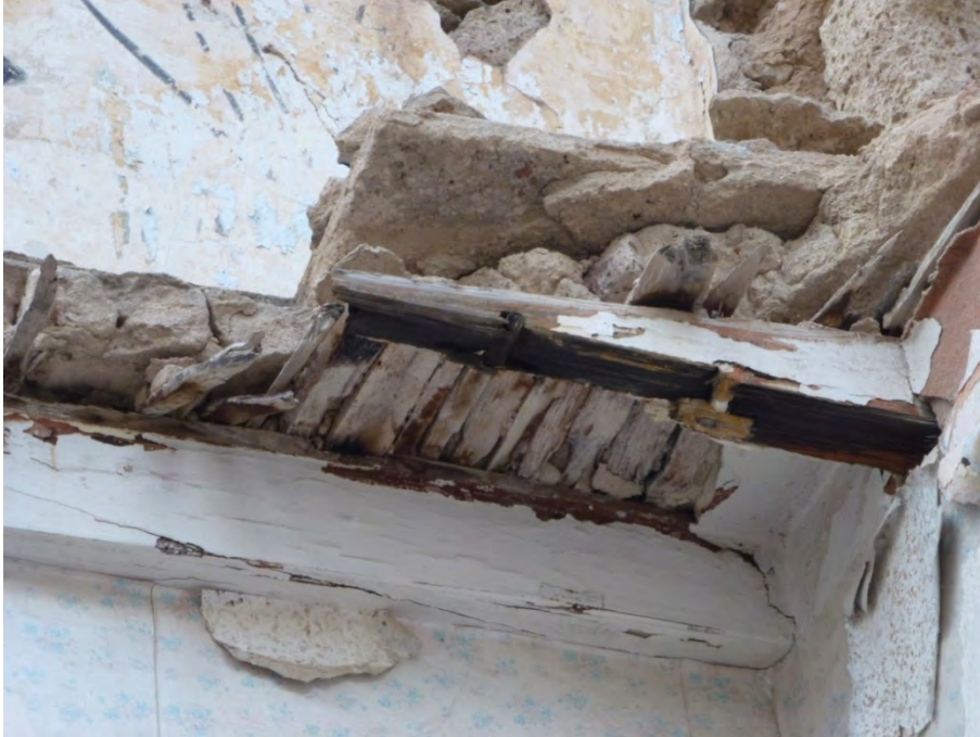
Composición de techo en cubierta. Viga, astillas, torta y cerámica.
