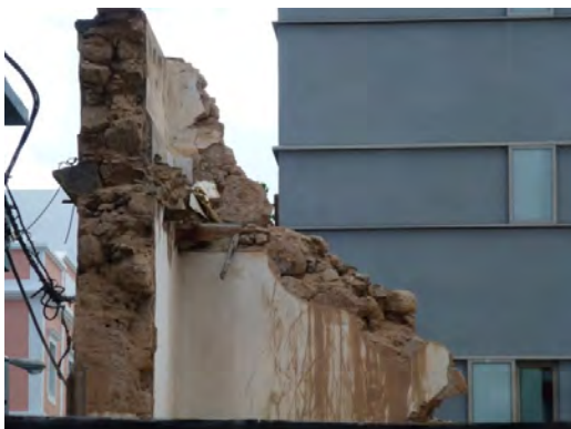
Muros de carga y cerramiento unidos con arcilla.
