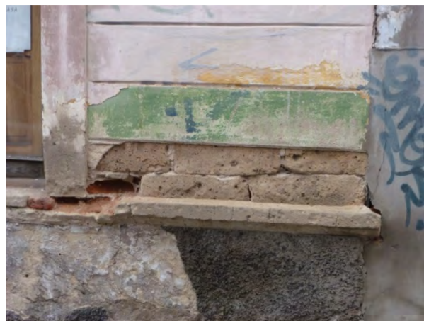
Pérdida por desprendimiento de moldura de llagueado.
