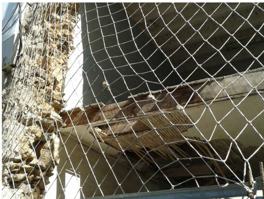
Techo compuesto de vigas de madera, tablazón y tablilla inferior.
