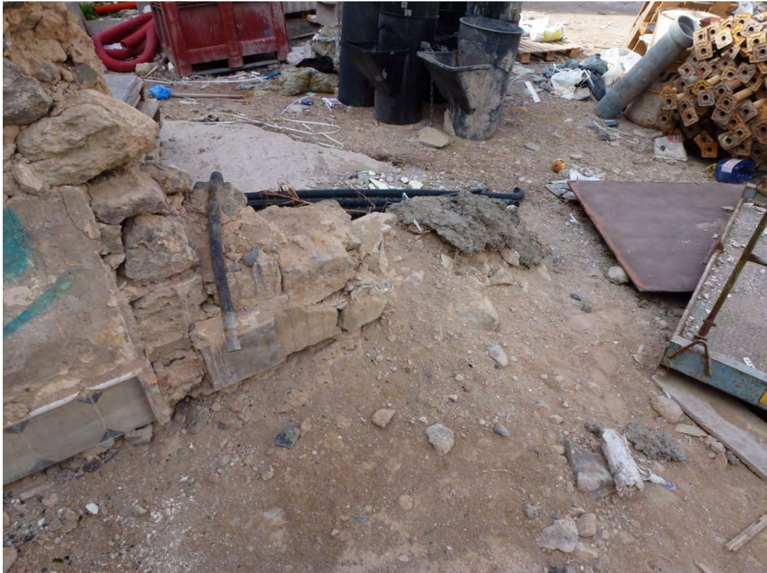
Demolición de cimentación edificio. Muros de carga.
