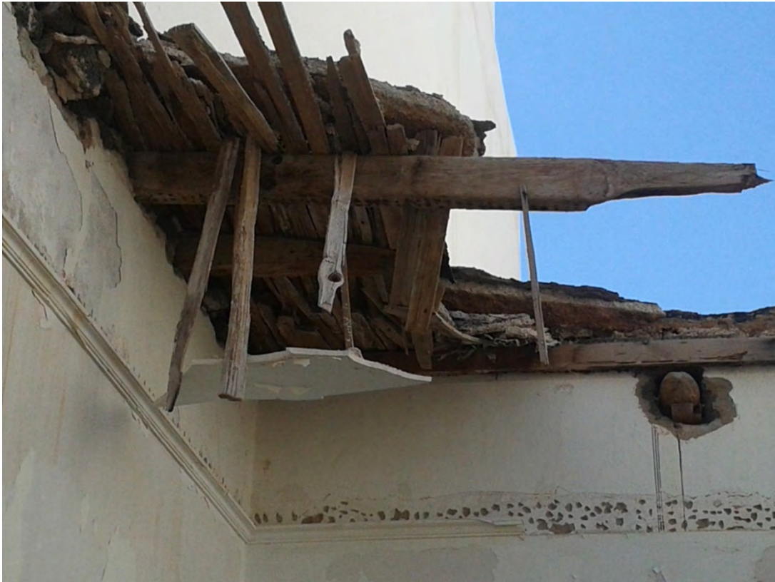
Vigas de madera, tarima cubierta y falso techo colgando (escayola).
