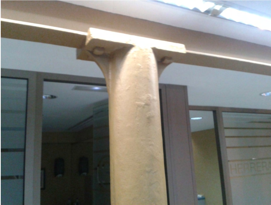
Estructura metálica de pilares y vigas.
