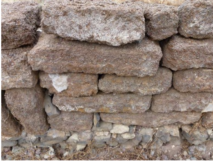
Bloques de cantería labrada para muros (tipo sedimentario).
