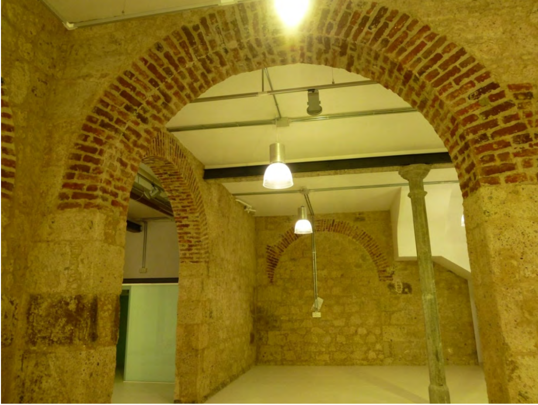
Arcos apoyados en pilares pétreos de gran formato.
