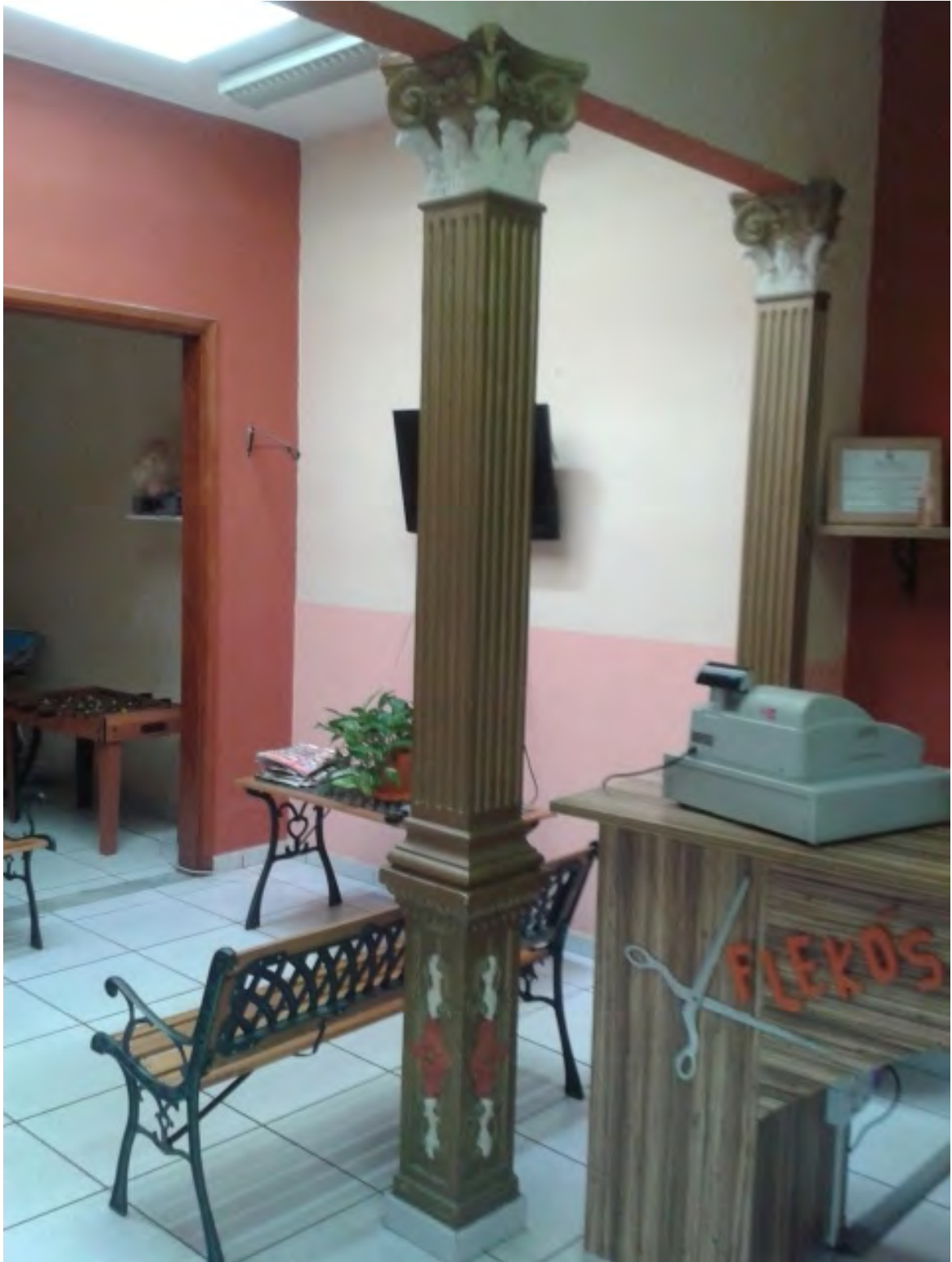
Pilar hueco de hormigón centrifugado en molde. Prefabricado. Sólo apoyo, sin empotramiento.
