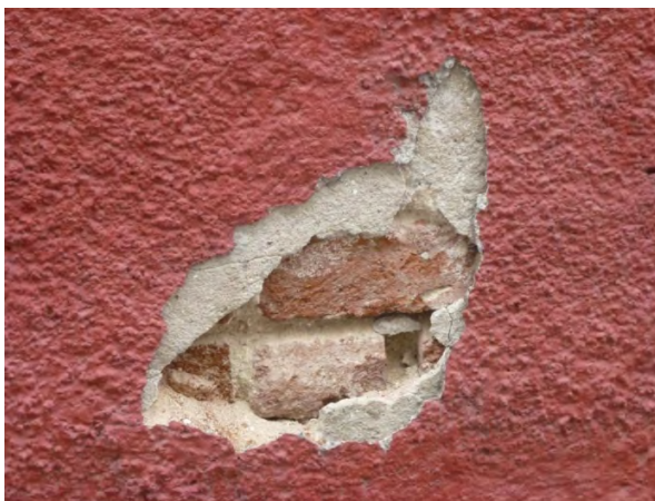
Desprendimiento de mortero por impacto.
