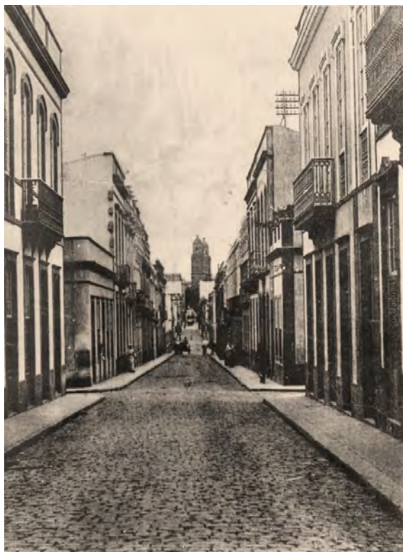
Viviendas en dos plantas. Calle Buenos Aires.
