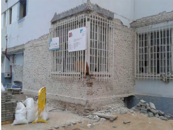
Muro de ladrillo silicocalcáreo.
