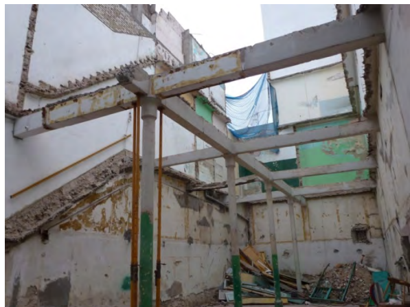
Demolición estructura porticada ortogonal. Hormigón armado.
