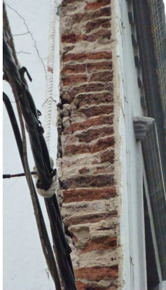
Muro de carga ejecutado con ladrillos cerámicos.
