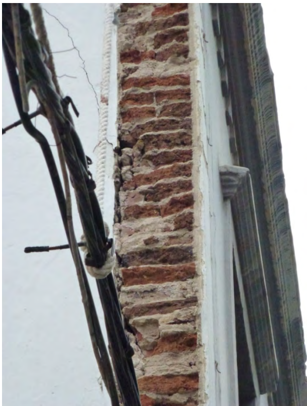
Muros de carga a base de piezas cerámicas y mortero de cal.
