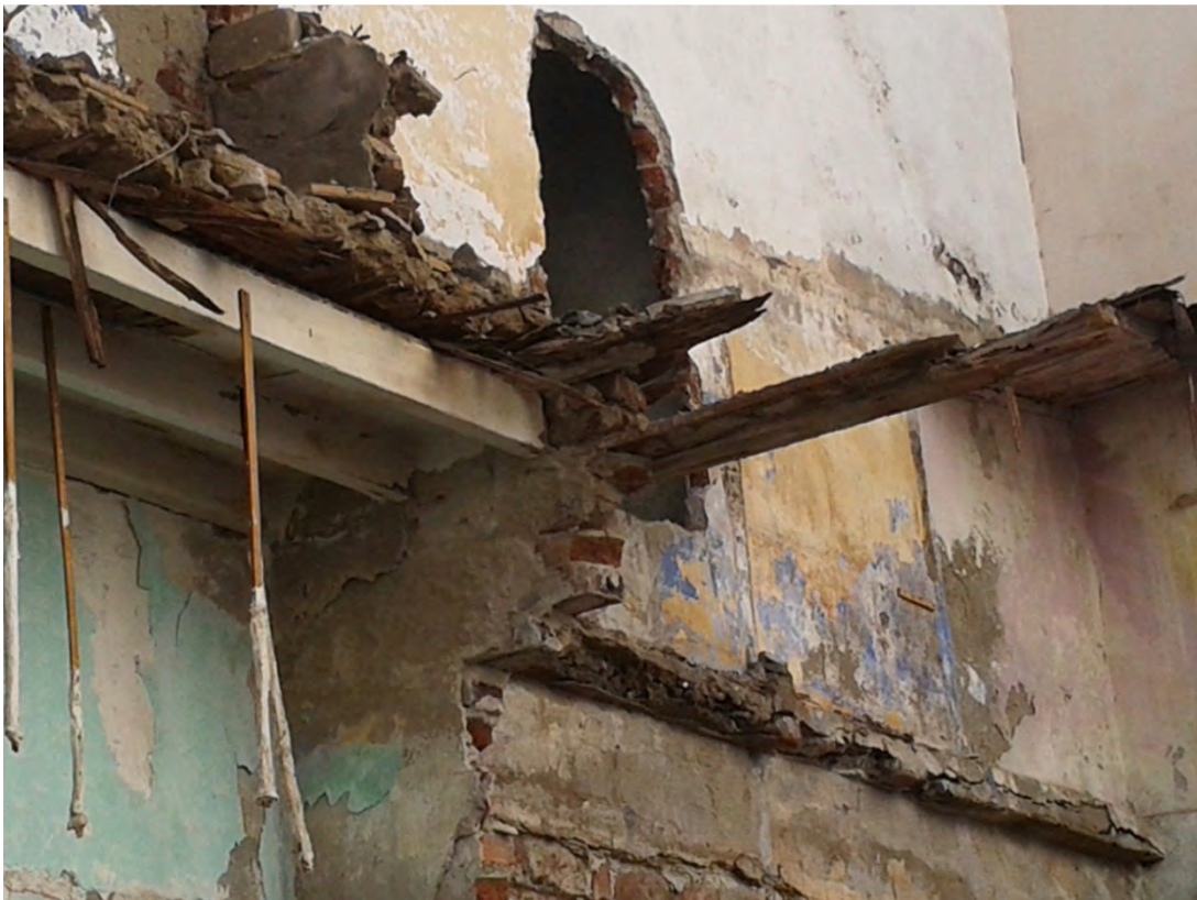
Empotramiento de vigas de madera para cubiertas.
