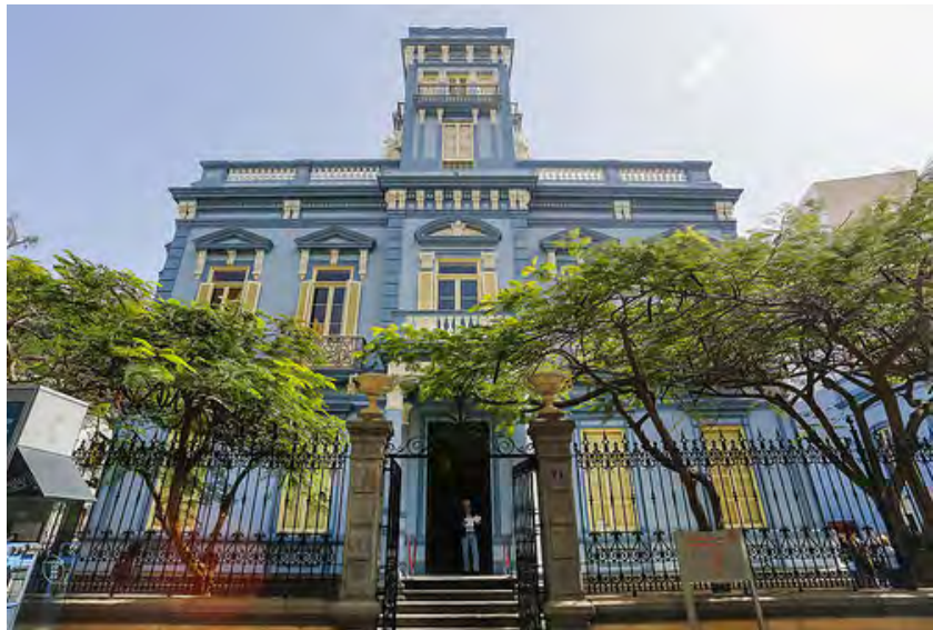
Casa Quetgles. Estado actual.
