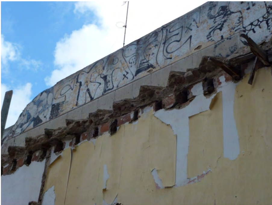
Empotramiento de forjados de madera en muros.
