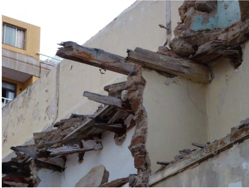
Empotramiento de forjado de madera en muro.
