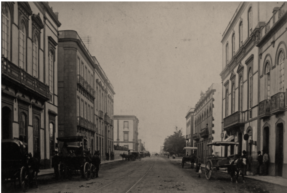
Viviendas y comercial. Calle Triana.
