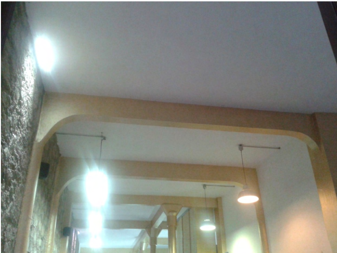
Sistemas porticados independientes. Cartela en vigas. Hormigón armado.
