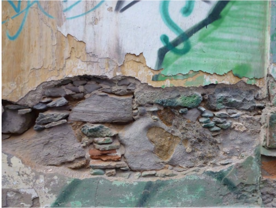
Desprendimiento de enfoscado de mortero de cal.
