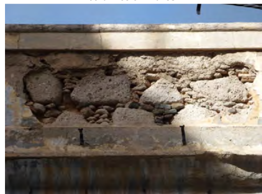
Muro de mampostería recalzada y argamasa de arcilla
