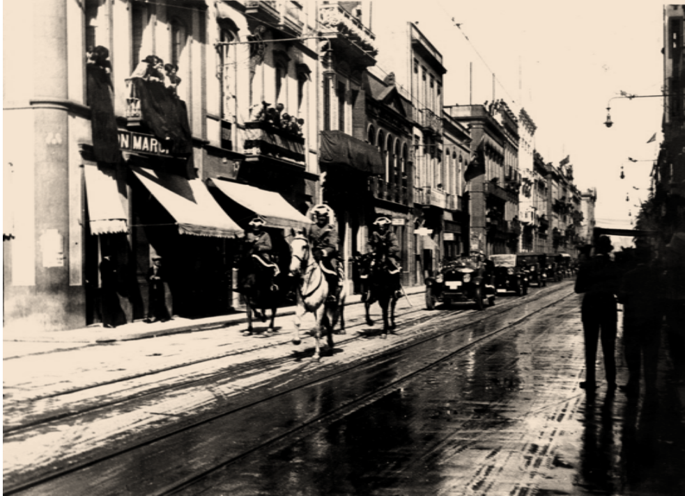
Viviendas y comercial. Calle Triana.
