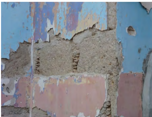
Pérdida superficial de mortero de cal.
