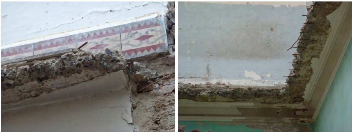
Encuentro de losa bidireccional. Espesor 0,14 m. con muro de carga.
