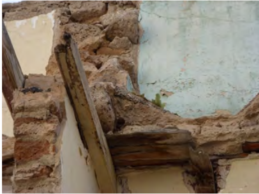
Muro de carga de cantería con argamasa de cal.
