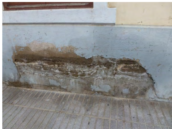
Desprendimiento de mortero por humedades de capilaridad.
