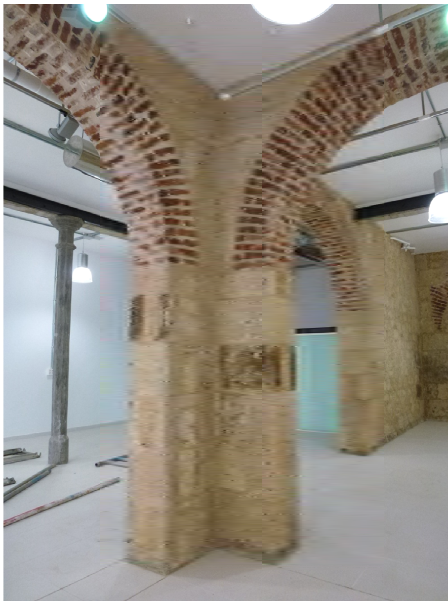
Arcos apoyados en pilares pétreos de gran formato.
