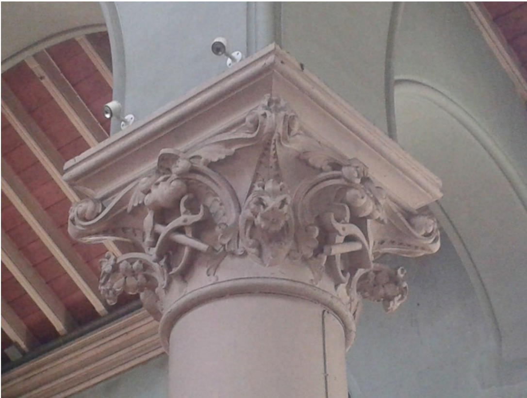
Arco apoyado en pilares prefabricados.
