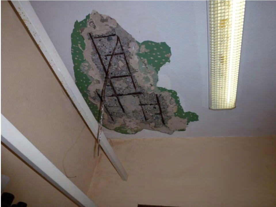
Deterioro en losas de forjado de hormigón armado.
