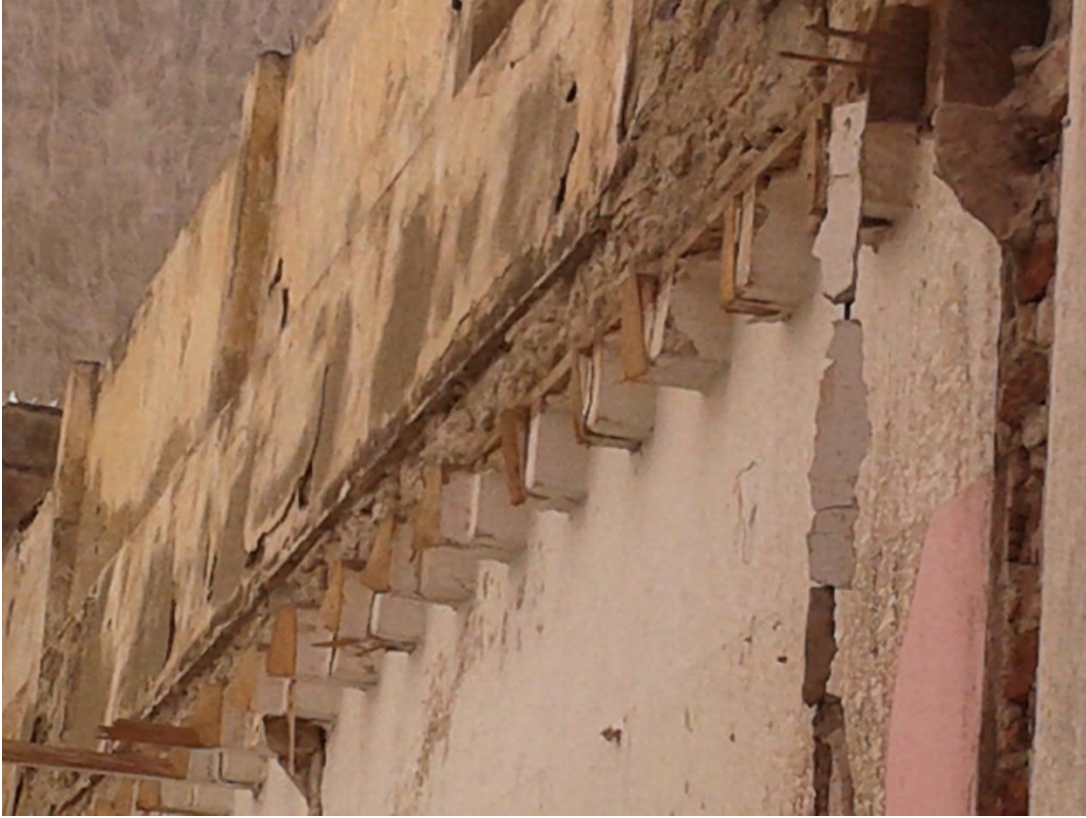
Empotramiento de vigas de madera en muro portante.
