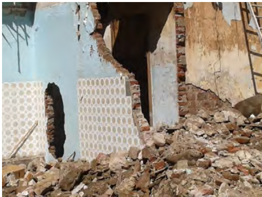
Muros divisorios de carga ejecutados con piezas cerámicas.
