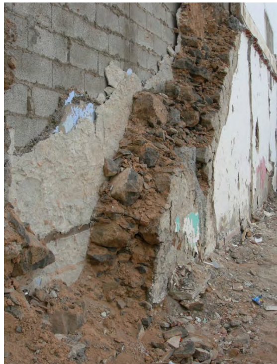
Visualización muro portante en terreno.
