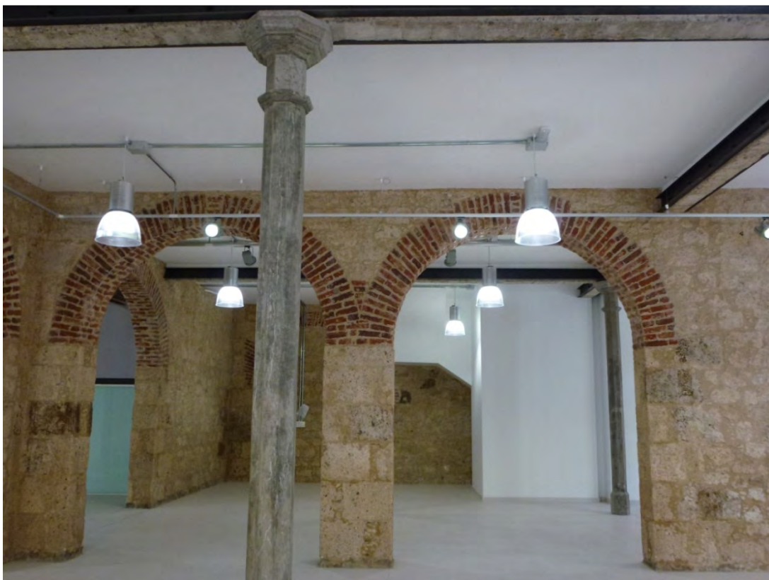
Estructura mixta de pórticos, muros y arcos. Detalle de pilar centrifugado prefabricado.
