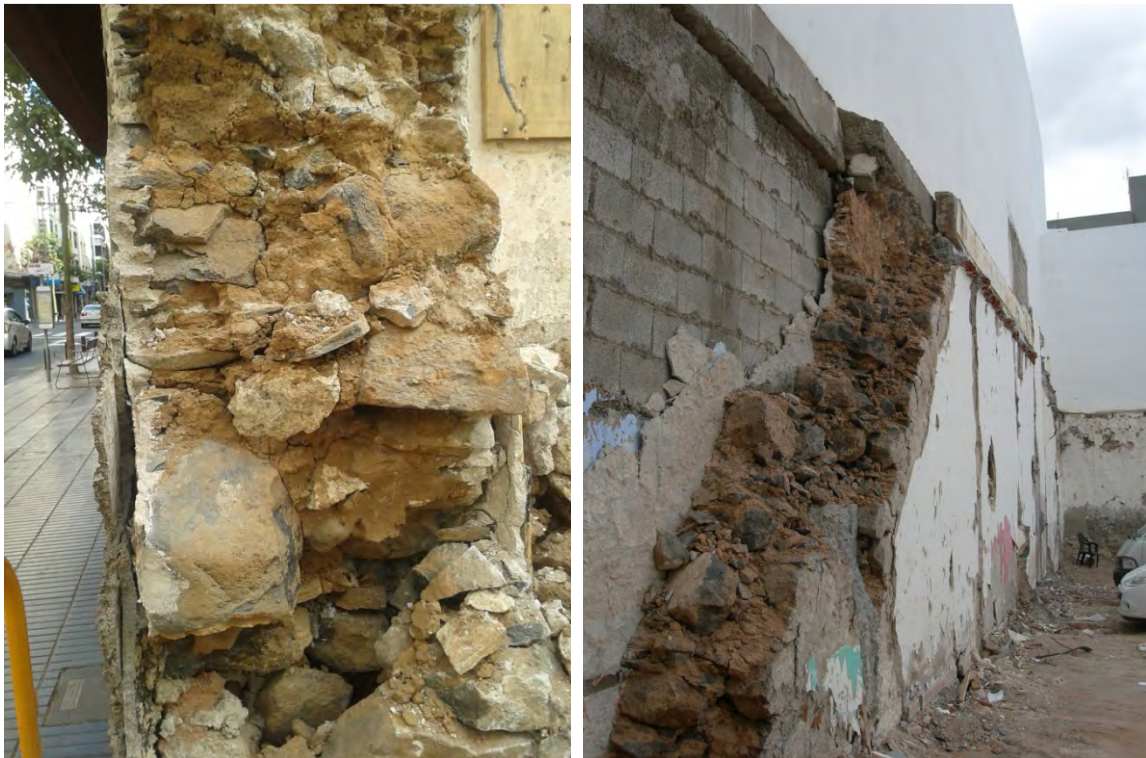
Muros de carga y cerramiento unidos con arcilla.
