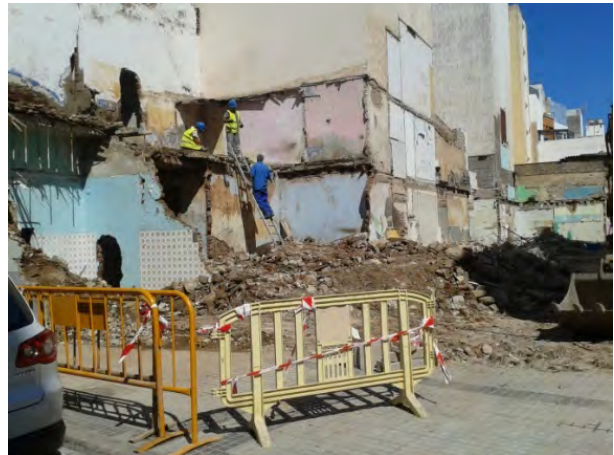
Demolición de vivienda en dos plantas.
