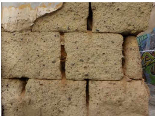
Muros ejecutados con sillares sedimentarios labrados unidos con arcilla
