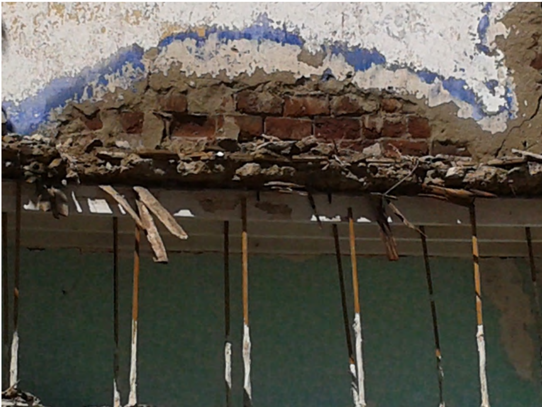
Empotramiento de vigas de madera.
