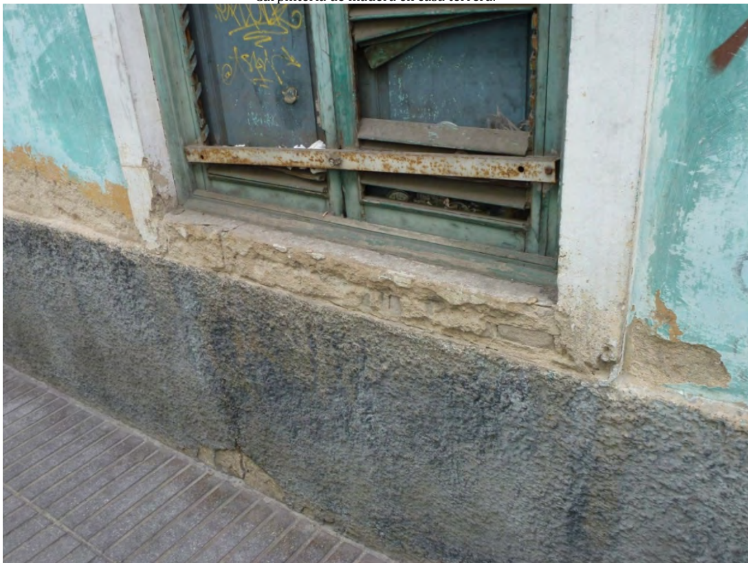
Deterioro en carpintería de madera y enfoscados. Vivienda terrera en el Puerto.
