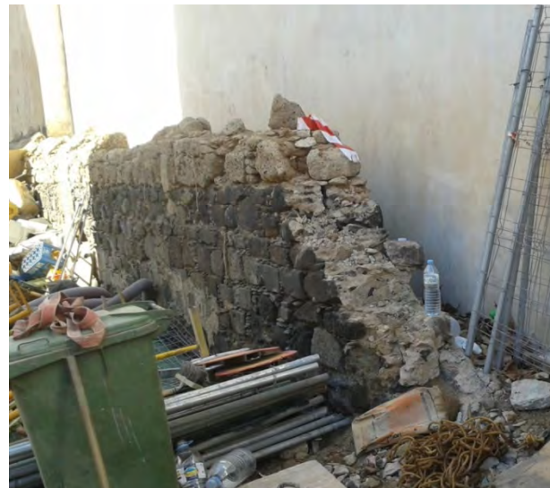
Muro de carga ejecutado con mampuestos y mortero de cal y arena.
