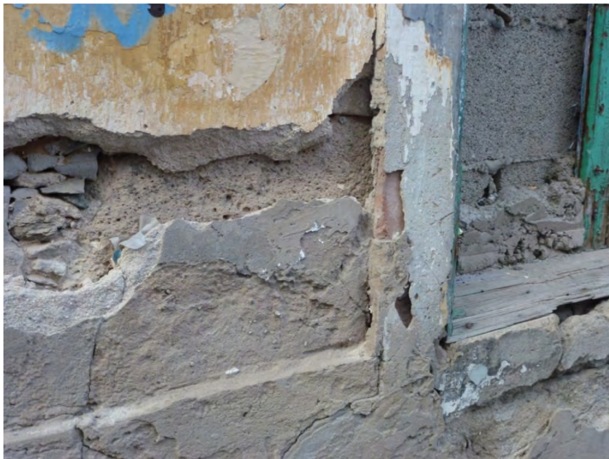
Desprendimiento de enfoscado de mortero de cal.
