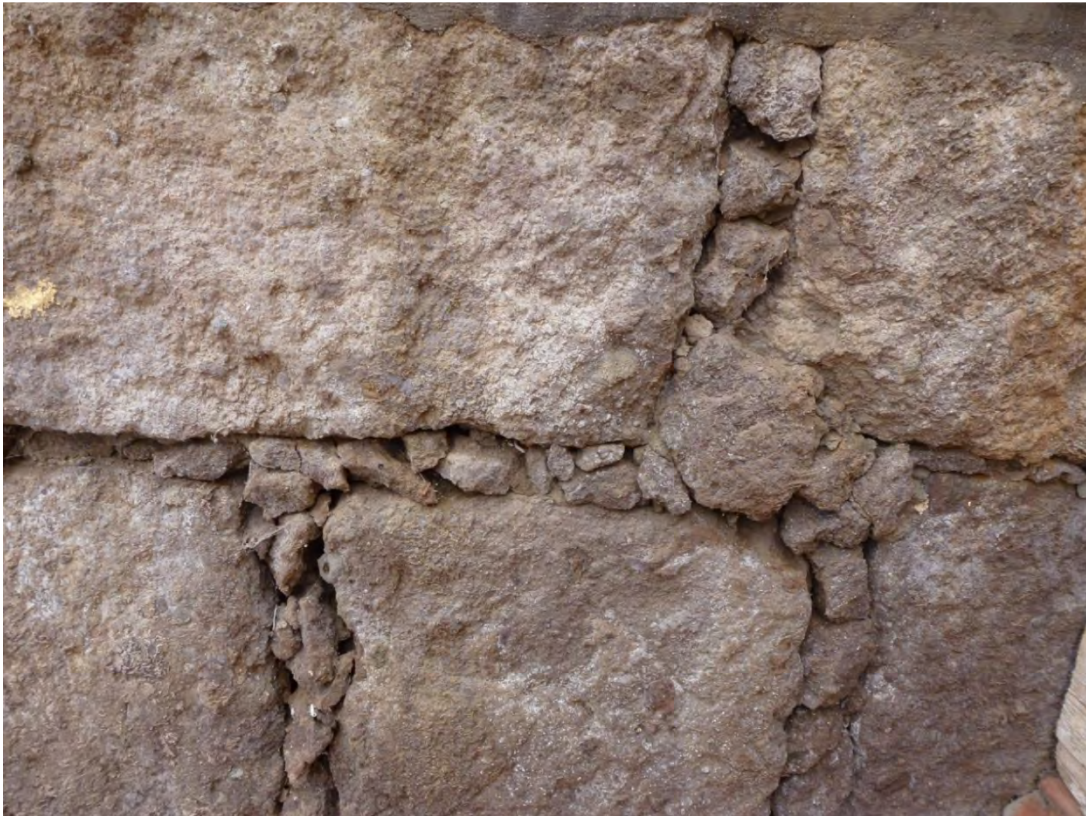
Degradación de la piedra por disolución de sales.
