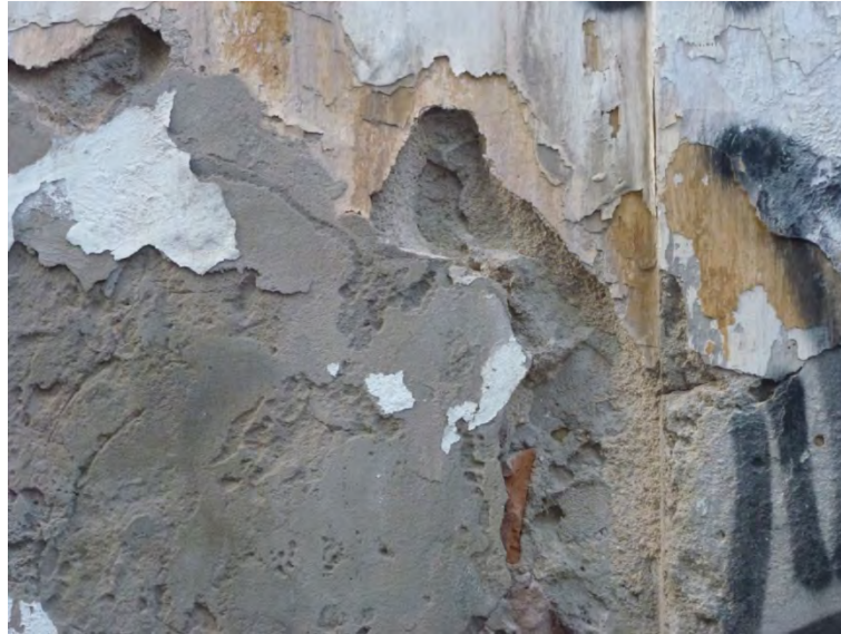
Desprendimiento de mortero por humedades.
