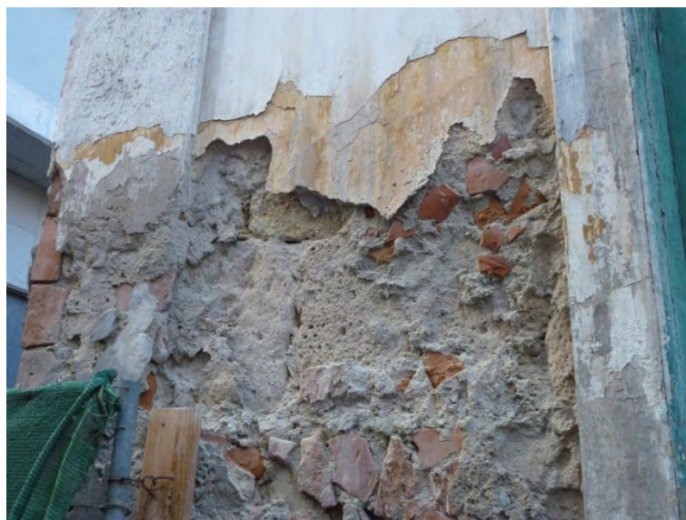
Desprendimiento de mortero por humedades de capilaridad.
