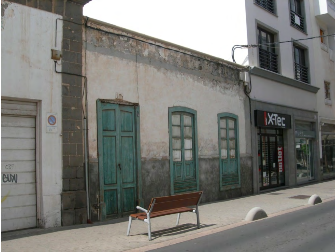
Carpintería de madera en casa terrera.
