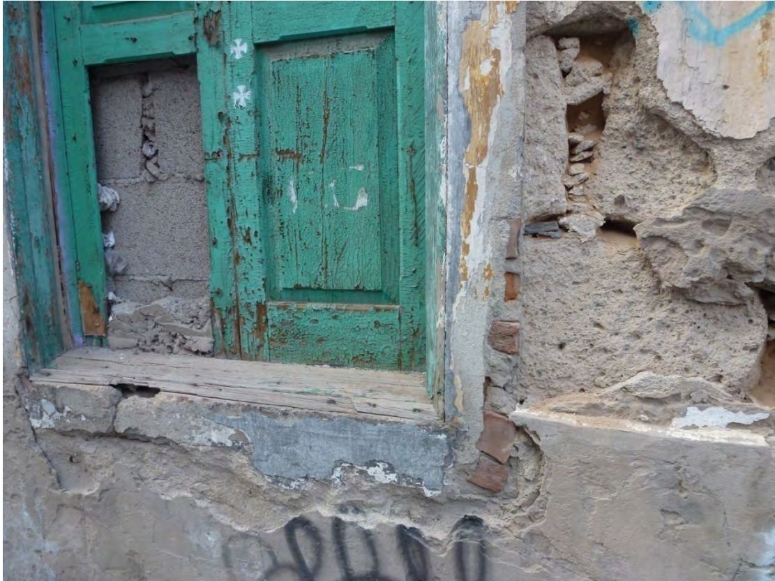
Deterioro en carpintería de madera y enfoscados. Vivienda terrera en Santa Catalina.
