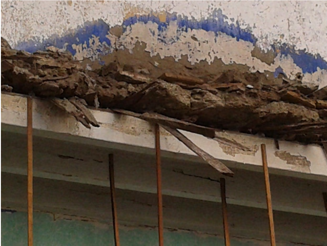
Empotramiento de vigas de madera para cubiertas.
