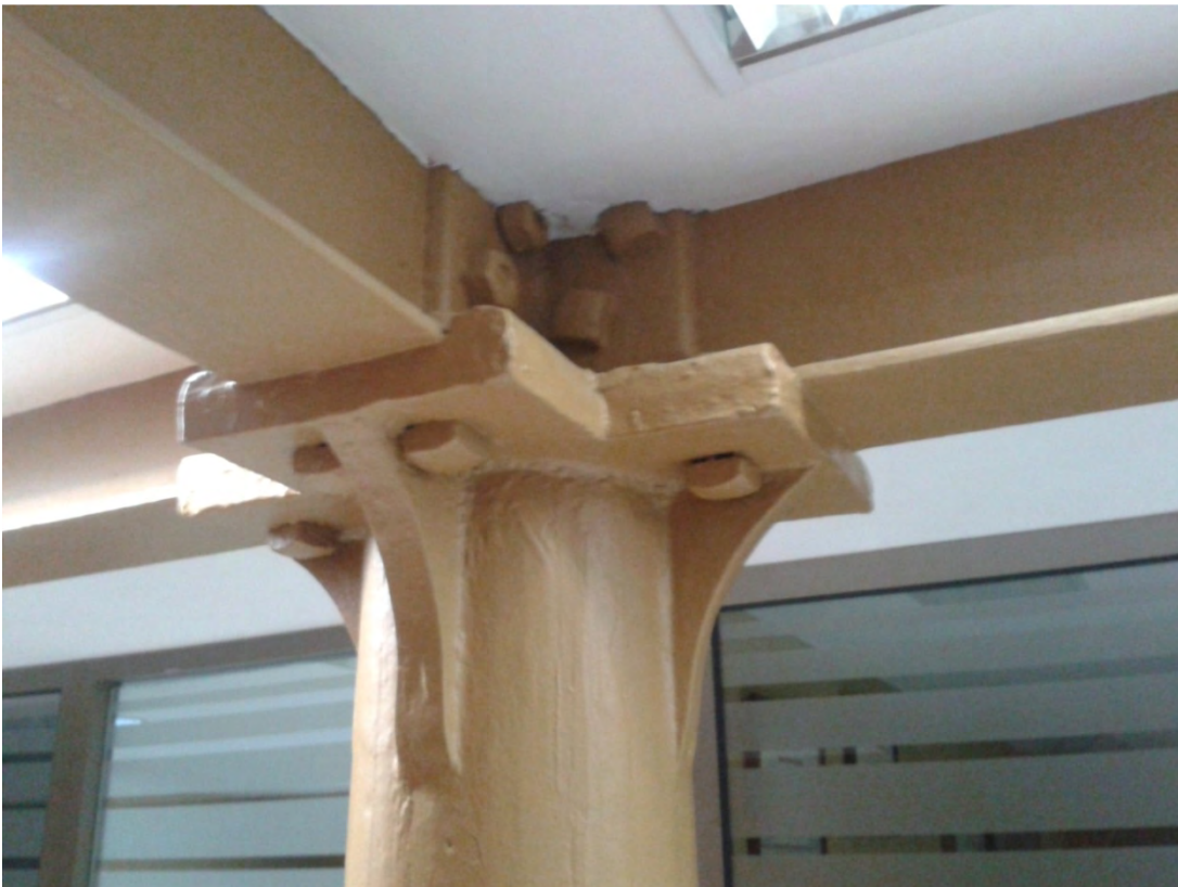
Estructura metálica de pilares y vigas. Nudo.
