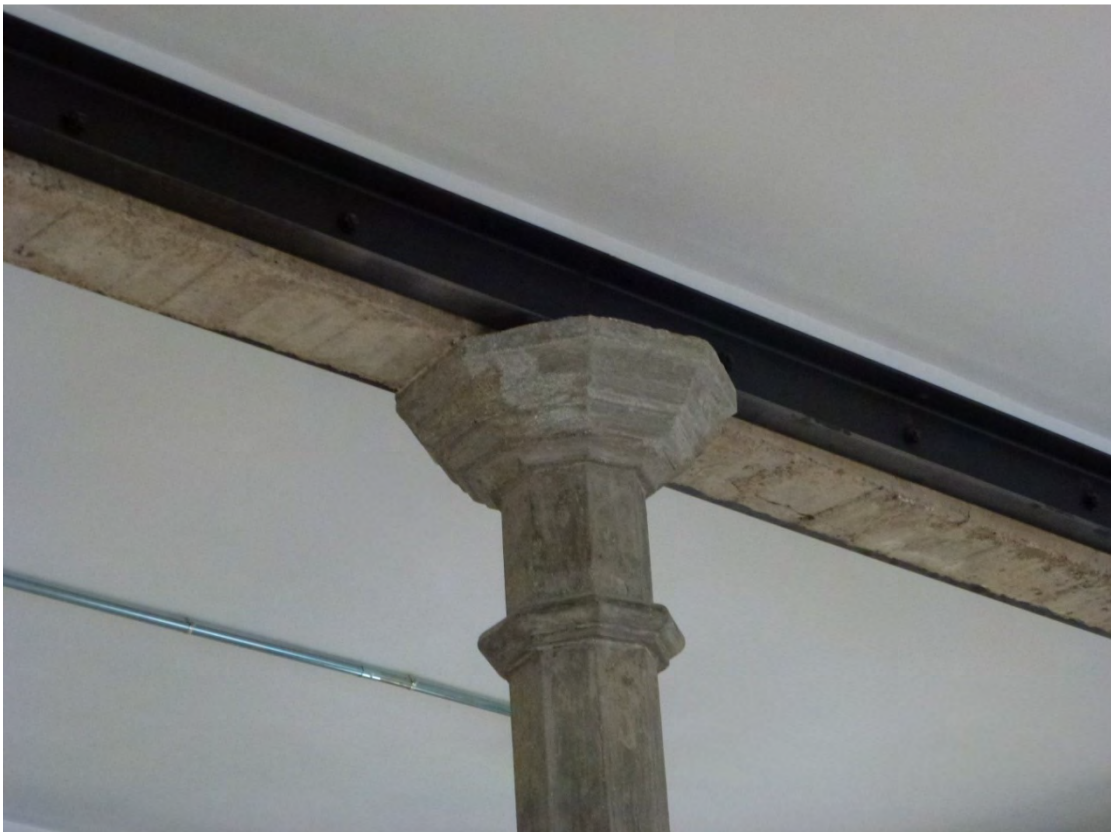
Pilar hueco de hormigón centrifugado en molde. Prefabricado. Sólo apoyo, sin empotramiento.
