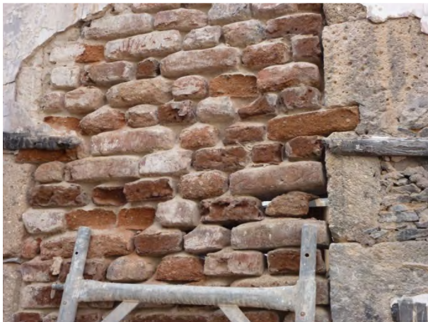
Muro de ladrillo cerámico con pérdida de capacidad portante por deterioro de pieza.
