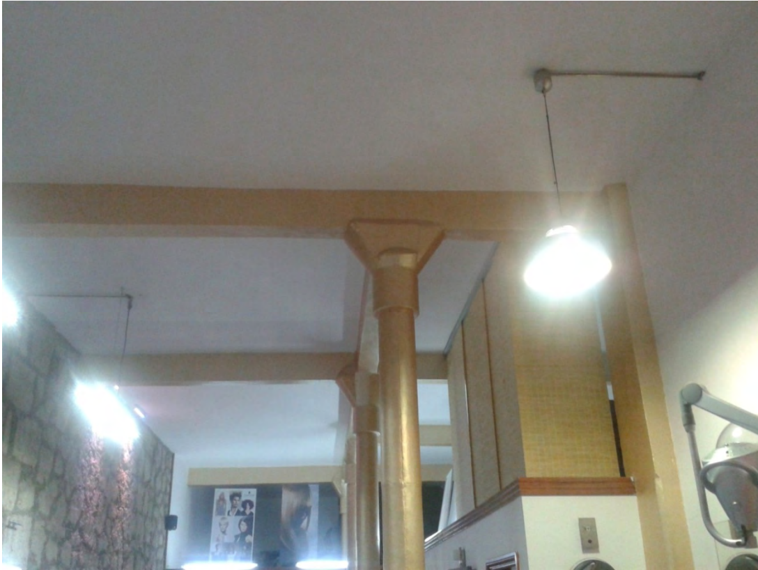
Sistemas porticados independientes. Capitel en pilares. Hormigón armado.
