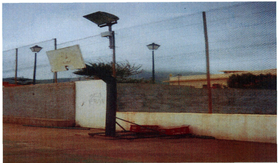
F. 4: Equipamientos y medidas de seguridad deterioradas en una Cancha de barrio.
