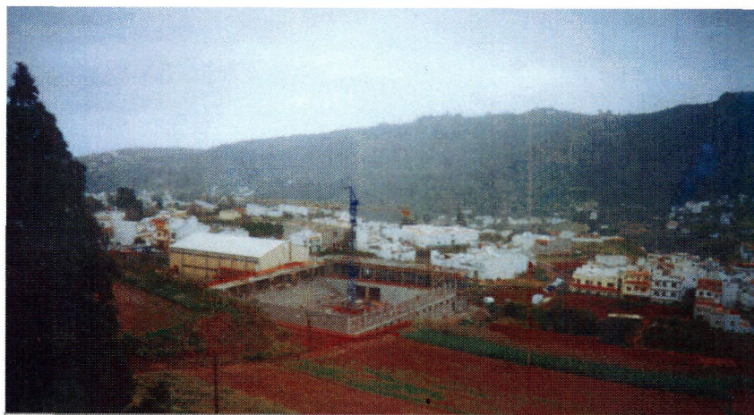
F: 5 Complejo Polideportivo "Los Llanos" (Teror), donde se aprecian las obras del nuevo Pabellón Polideportivo municipal. Marzo 2001.
