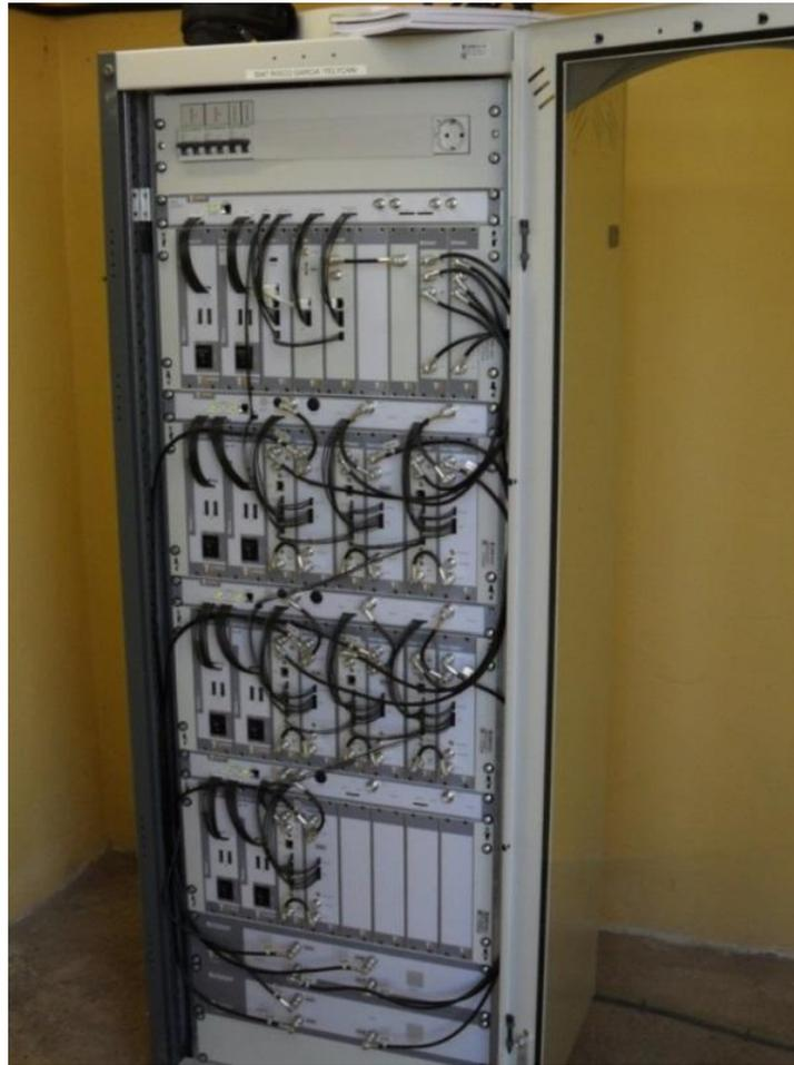
Ilustración 35: Estación microemisora de 7 canales Gap-Filler
