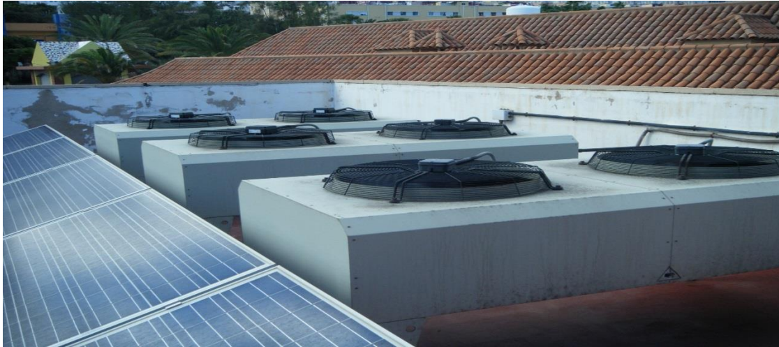
Figura 2.17 Unidades condensadoras de exterior, pertenecientes al CPD-I
