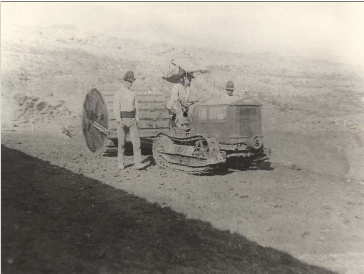
Figura V.45 Trabajando en la construcción de una carretera, Gran Canaria, 1927
