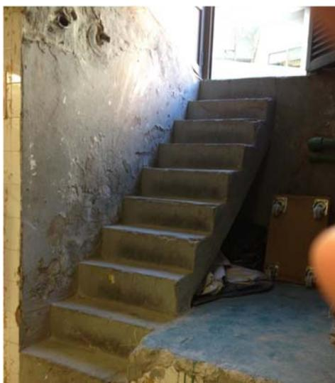
**Figura.** Escalera del sótano en mal estado y sin barandilla – Zona instalación de agua fría de consumo.
