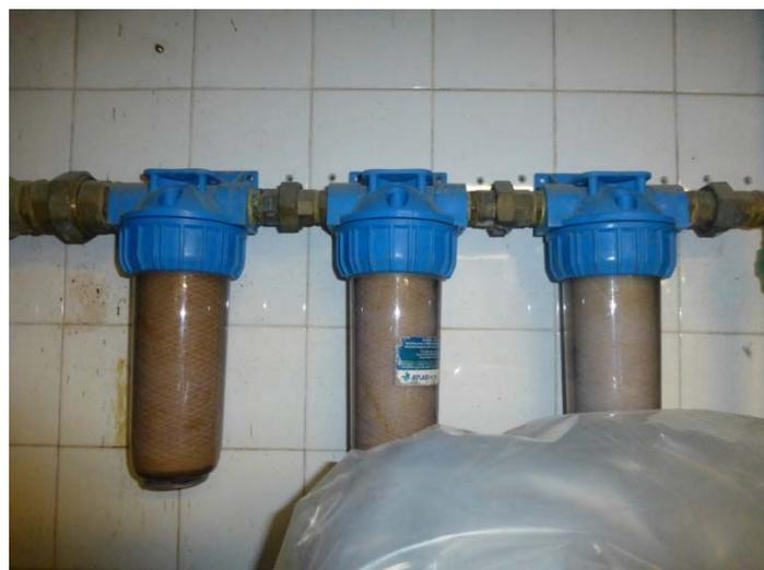
Figura. Filtros de hilo dispuestos en serie para el tratamiento del agua.
