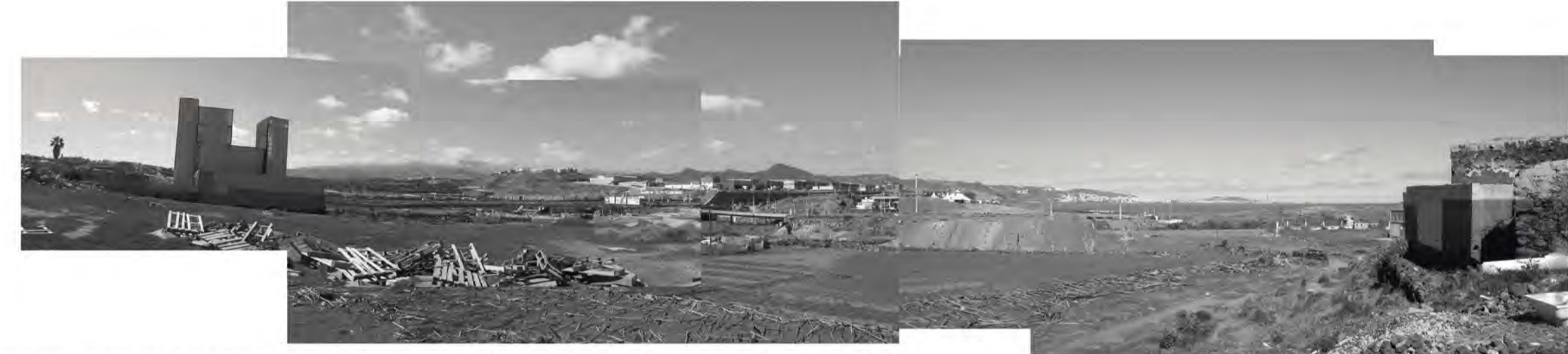
Panorámica del área de proyecto. Desembocadura del barranco Real de Telde
