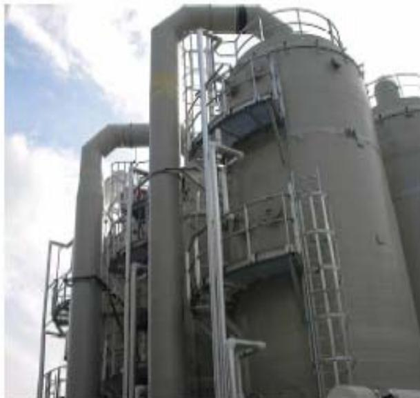
**Figura 7.3.** Reactores de biofiltro para el tratamiento de emisiones de CS<sub>2</sub> en una planta de semillas [11].
