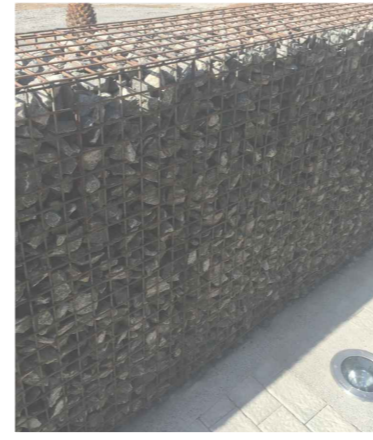
MURO DE GAVIONES
