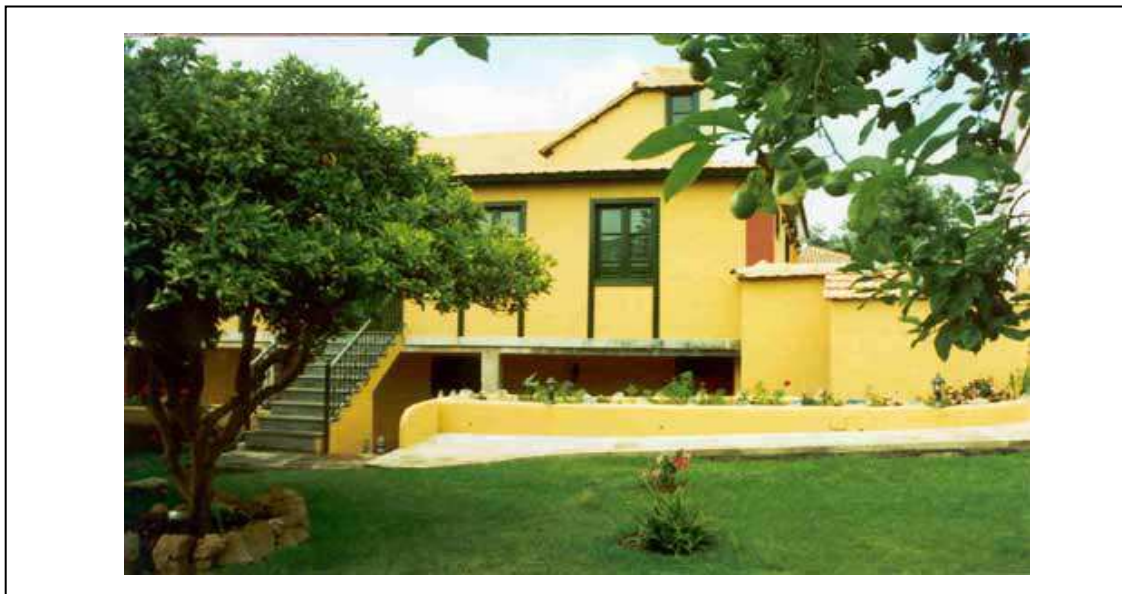
Figura 5.1. Villa Caya. La Orotava. Tenerife. Rehabilitación.
