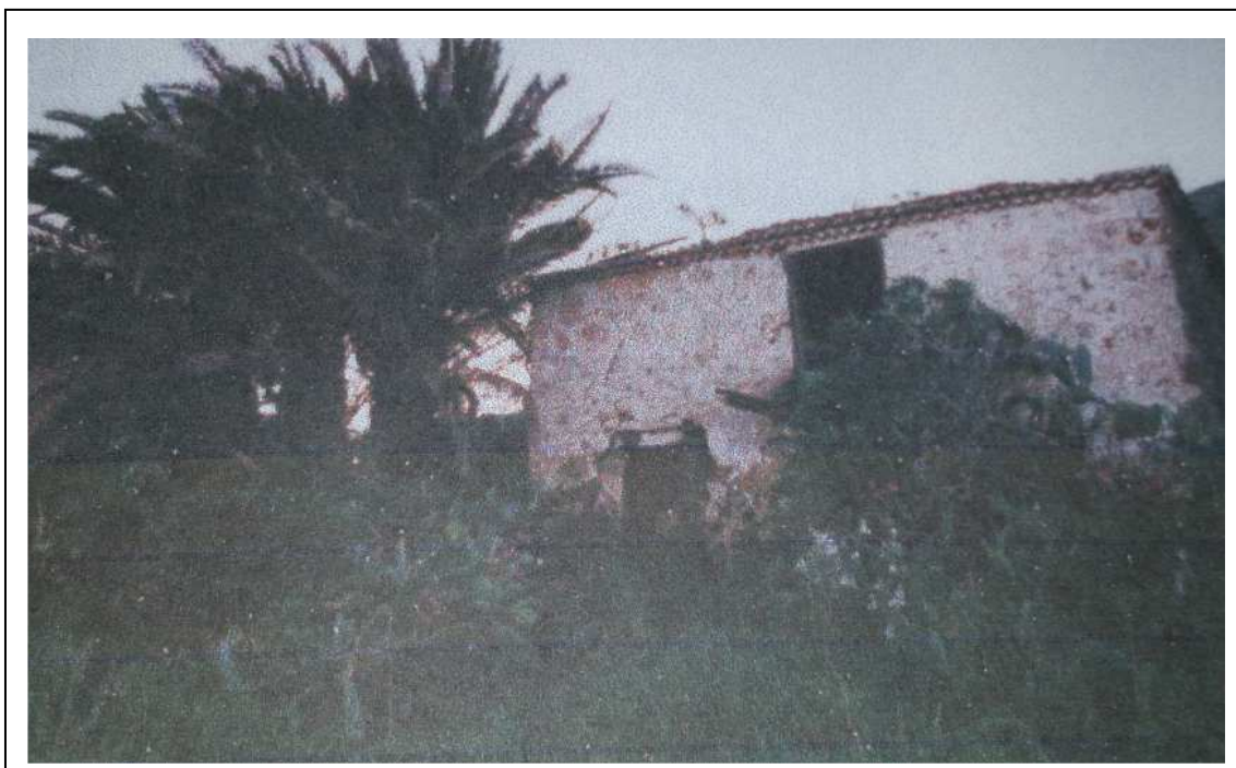
Figura 4.86. Elaboración propia. Estado antes de la reforma. Casa las Embelgas.
