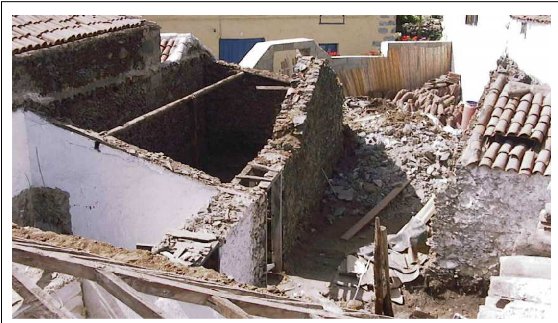
Figura 4.26. Elaboración propia. Estado antes de la reforma. Casa las Visitas.
