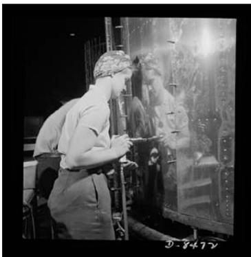
Una mujer remachadora adjunta una hoja de la cubierta exterior a un nuevo B-17F, bombardero pesado
