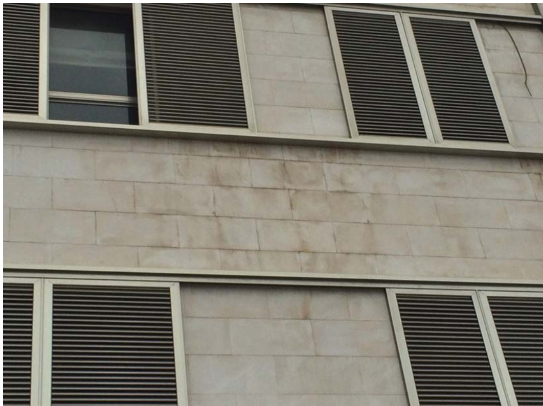
FOT. 4: FACHADA PRINCIPAL NOROESTE (BLOQUE 1)
