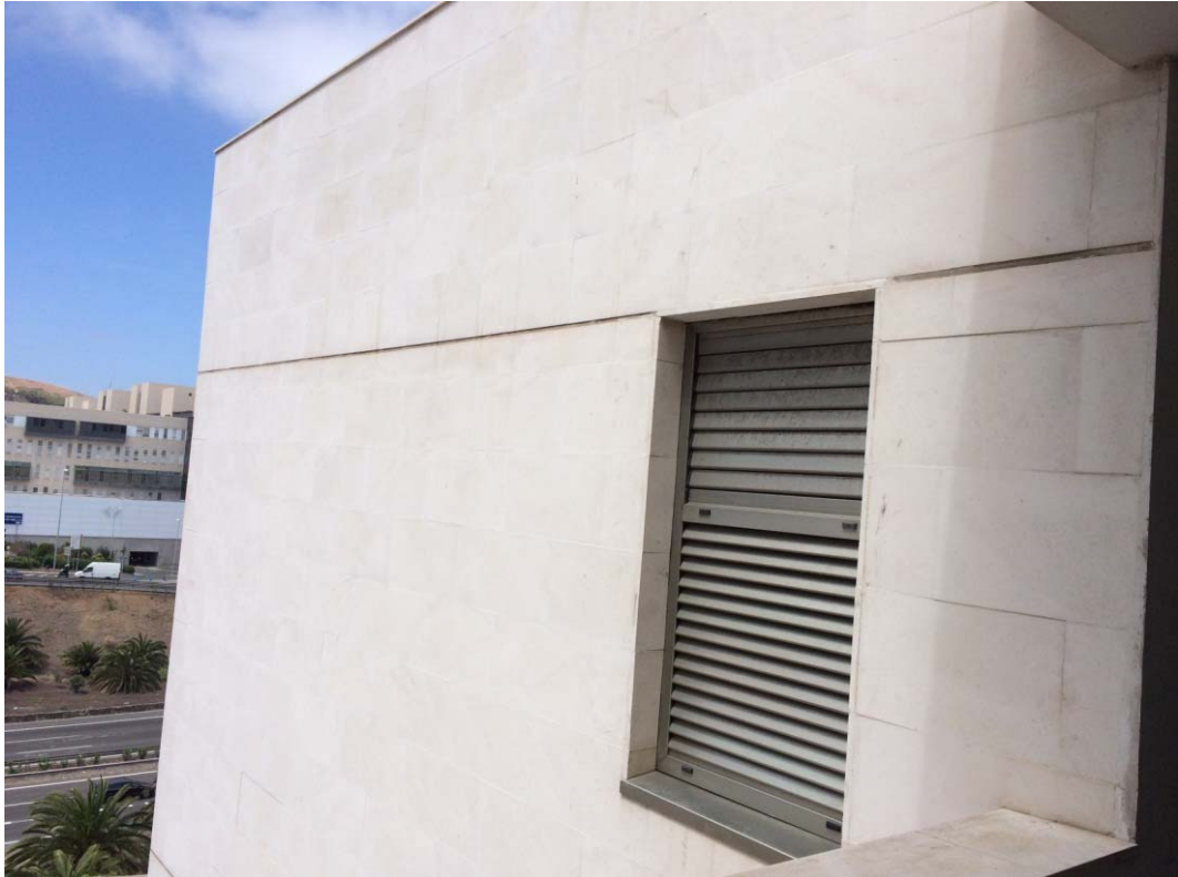
FOT. 3: FACHADA SUR DE TRAMO EXTREMO (BLOQUE 2)
