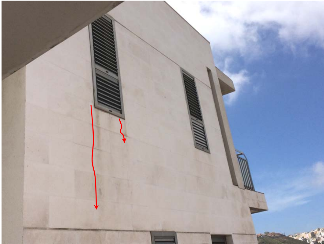
FOT. 1: FACHADA NORTE DE TRAMO EXTREMO (BLOQUE 2)
