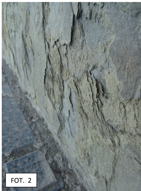
En la hilada inferior del aplacado se aprecia el estado de disyunción relativo a hojas de exfoliación.
