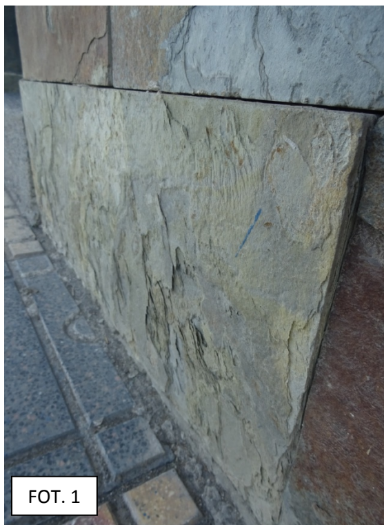
En la hilada inferior del aplacado se aprecia el estado de disyunción relativo a hojas de exfoliación.
