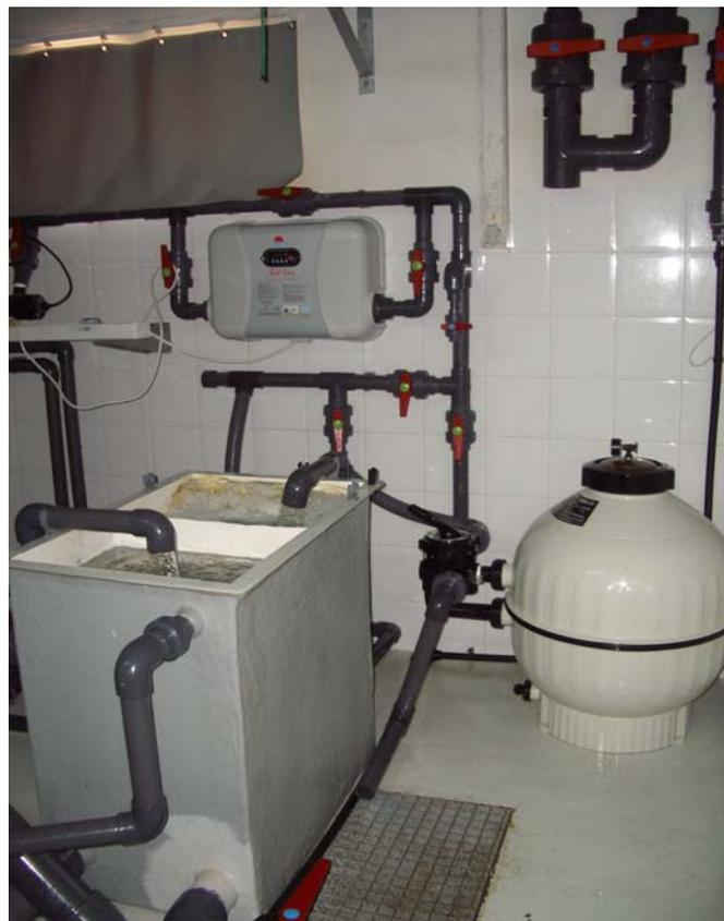
**Figura 7. Imagen del tanque de expansión, filtro de arena y bomba de calor del circuito B.**
