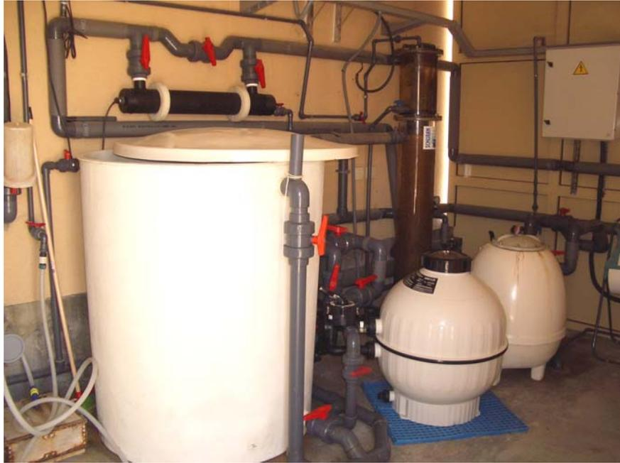
**Figura 6. Imagen del tanque de expansión, filtro de arena y skimmer del circuito A.**
