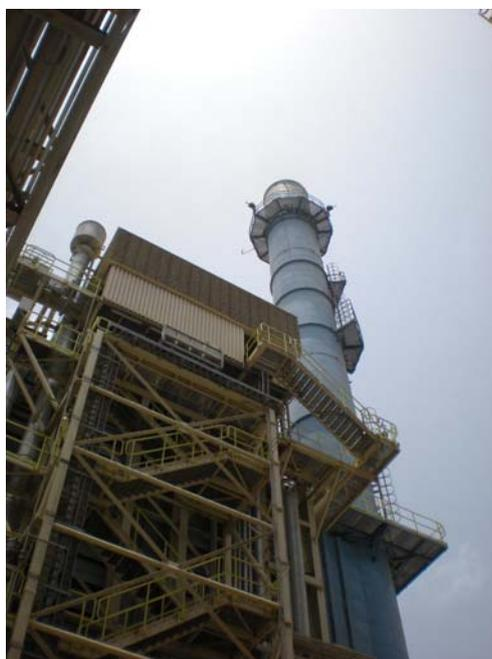
*Fotografía: Chimenea Caldera de recuperación del ciclo combinado*
