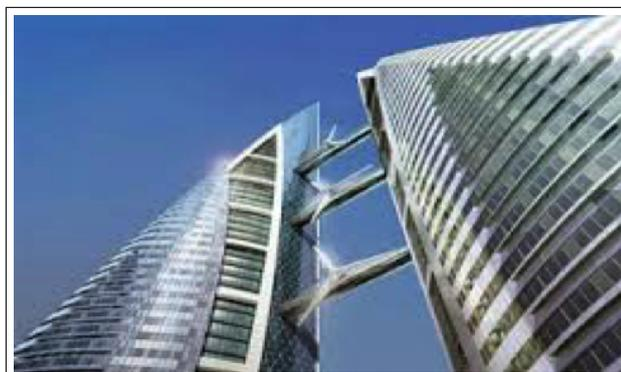
Figura 1.3: Aerogeneradores integrados en la edificación. Fuente:energy-building
