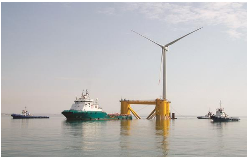
Figura 5.4.3: Buques auxiliares durante la instalación del Windfloat.
