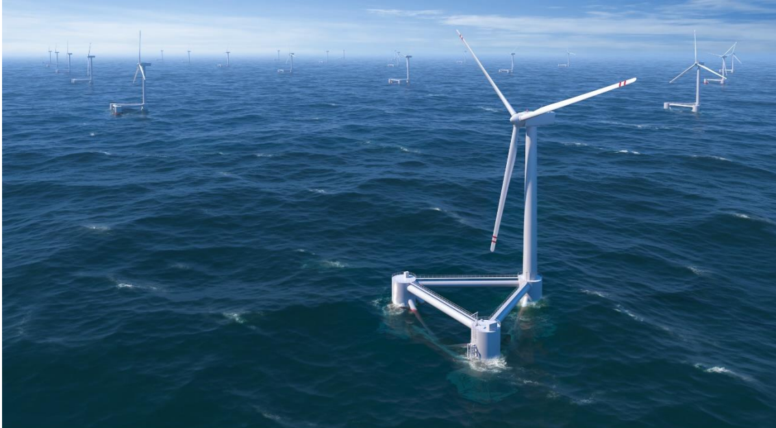
Figura 1.8.1: Plataforma off-shore para aerogenerador en aguas profundas, fuente Principle Power.
