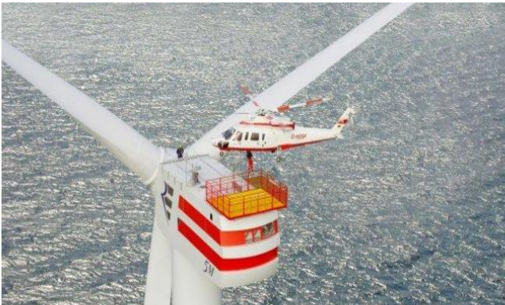
Figura 2.2.2: Acceso al aerogenerador con medios aéreos
