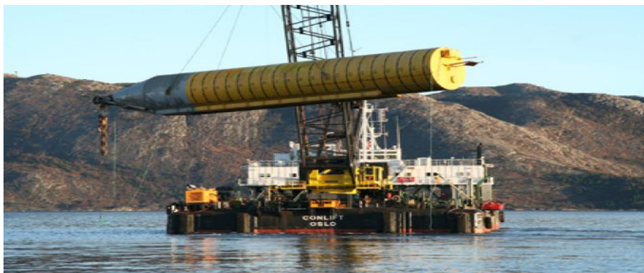
Figura 2.8.3: Pilotes de perforación durante su instalación.
