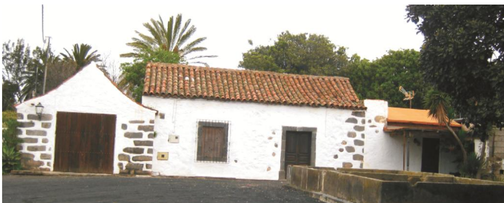
Foto del alzado de la casa del medianero. Elaboración propia
