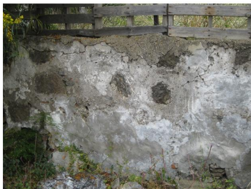
Muro que separaba el Patio de labores de las tierras de trabajo. Sin intervención
