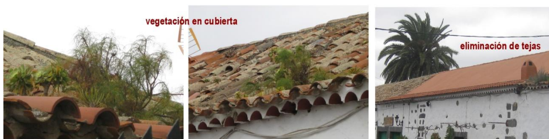
Figura 7) Las cubiertas de la bodega principal. Elaboración propia
