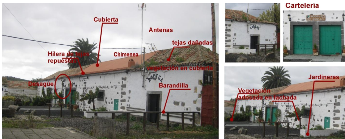
Figura 5) Bodega principal. Elaboración propia
