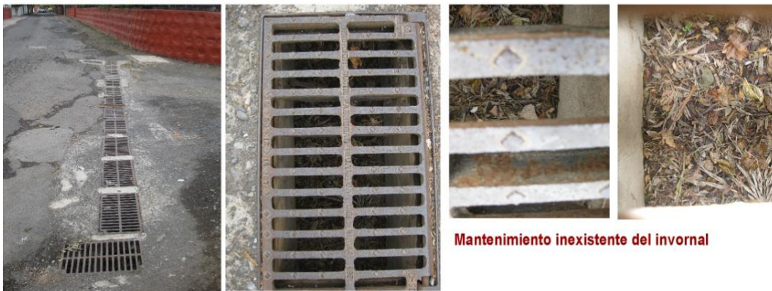
Figura 19) Imágenes del estado de mantenimiento del imbornal. Elaboración propi
