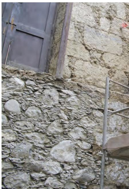
*Muro de sótano en contacto con el terreno. Se observa la transición con el muro de fachada ejecutado con canto blanco. La trabazón en las esquinas se resuelve igualmente con sillares de canto blanco.*
