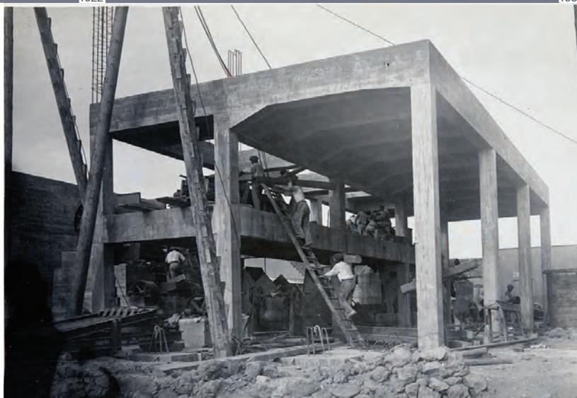
*En las dos páginas, planta de machaqueo para la elaboración de piedra y áridos para hormigones, construida entre 1927 y 1928 en La Isleta. Fuente: A.A.P.*
