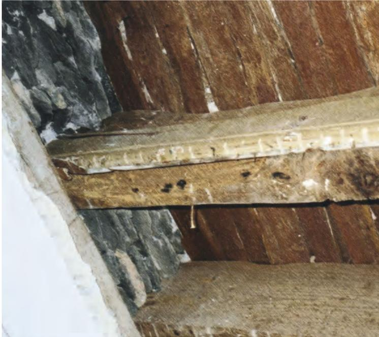
Las vigas apoyan en el muro a veces directamente, y en los casos más cuidados mediante una solera de madera. Entre las vigas se disponen piedras o lascas de menor tamaño, sin armagasa, con el fin de mantener una cierta aireación y evitar la pudrición de la cabeza de las mismas.
