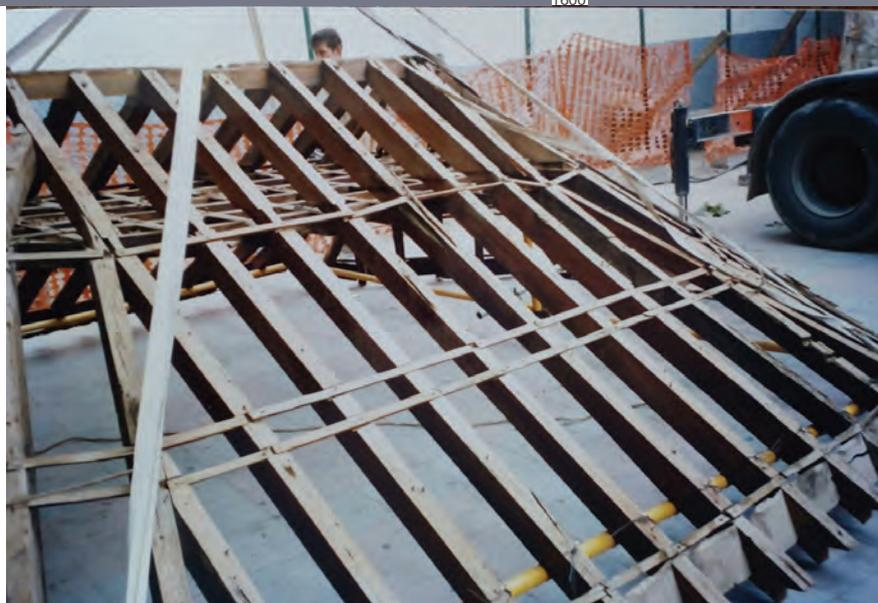
*Dicha estabilidad permitió desmontar la estructura de una pieza para proceder a la restauración a nivel de suelo con mejores condiciones de seguridad. Fuente: archivo del arquitecto.*
