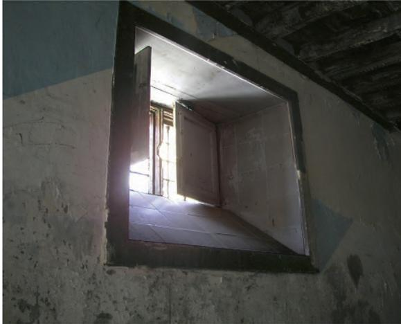
*En ventanas de bodegas situadas en semisótanos y plantas bajas en ocasiones se utilizaban ventanas con pequeña superficie en fachada y en la que el abocinado del capialzado es mucho más pronunciado para iluminar el interior.*
