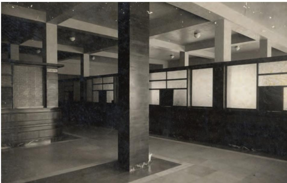
Vestíbulo de acceso al público y oficinas al fondo. Se observa el sistema de pilares, que permiten una disposición abierta de la distribución del espacio. El techo se resuelve mediante un entramado de vigas de canto que enlazan los pilares en ambas direcciones, con losa maciza de canto reducido.
