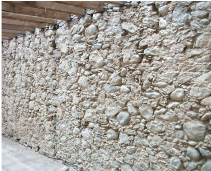
*Dos muestras de los muros de mampostería propios de esta etapa, con gran proporción de argamasa en la configuración del paramento.*
