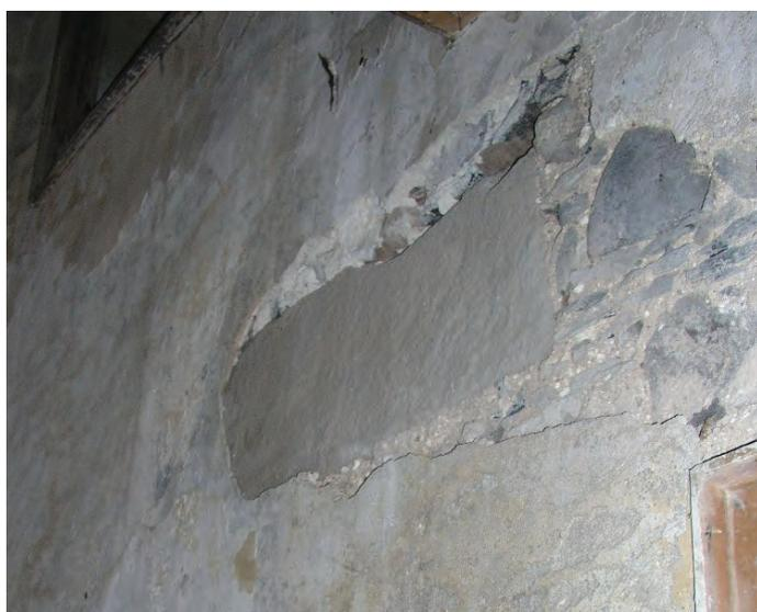
*rencia del núcleo. La disposición de sillares en las esquinas así como formando los huecos, incluso piezas dispuestas puntualmente, actúan como encadenados y ayudan a estructurar la capacidad portante del muro. Tal como especifica I. Paricio, “como sistema son muros armados por esos elementos lineales diferenciados.”*
