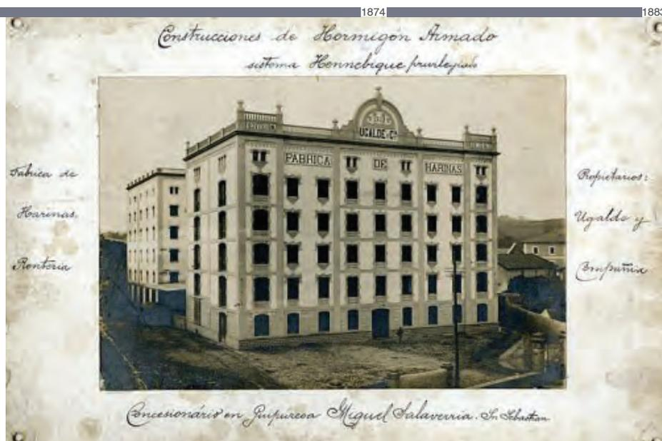
Según Antonio Burgos, las fábricas harineras fueron los primeros edificios construidos con estructura porticada de hormigón armado.
