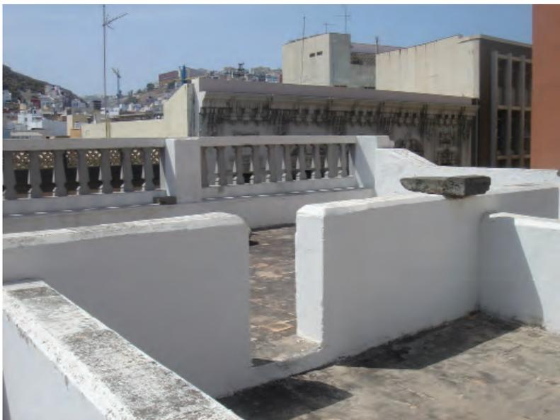
*Fernando Navarro mantiene en cubierta el empleo de los petos de grandes dimensiones, muestra de que no son una simple continuación de muros de mampostería, sino elementos de estabilización de los apoyos de los techos, especialmente en el caso de vigas de madera.*
