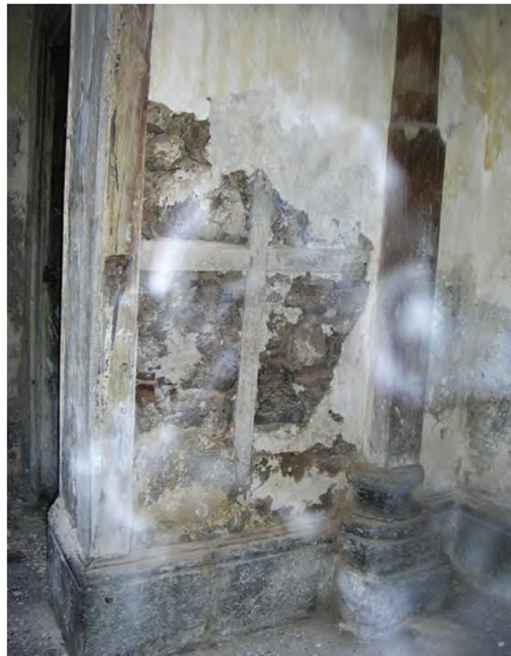
*Cerramiento bajo la escalera principal en planta baja, resuelto con entramado de madera con relleno de piedra.*
