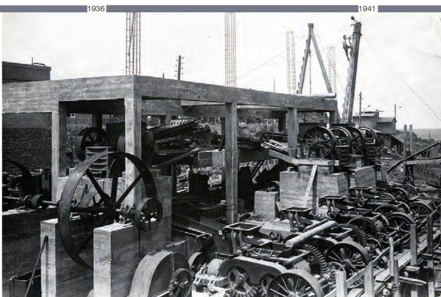
*Gracias a esta planta se abarata y mejora el procedimiento para la obtención de áridos y gravas de distinto tamaño, repercutiendo en la calidad de los hormigones que se ejecutan.*
