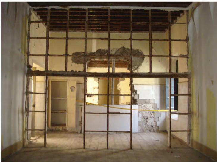
*Ejemplo de partición interior de entramado de madera, “descubierto” durante la rehabilitación del antiguo Hospital San Martín. En la fotografía aparece después de haber eliminado los revestimientos y el material de plementería. Al igual que los entramados de particiones interiores de la casa Báez, se resuelve sin tornapuntas. En el nivel del dintel se dispone un tablón de mayor dimensión.*
