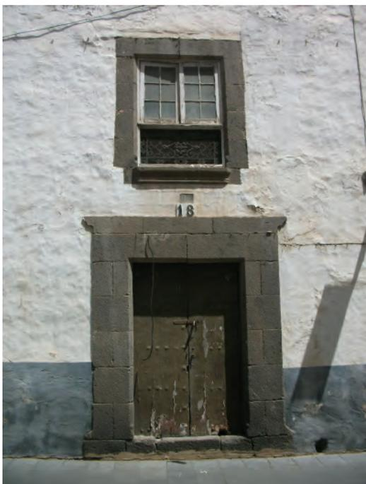
El encalado de las fachadas se realizaba según la técnica de piedra descubierta. La misma ejecución del muro y el sistema de encalado, que aportaba una capa de poco espesor, confería a la fachada un aspecto, un paramento un poco irregular, que no es perfectamente liso.
