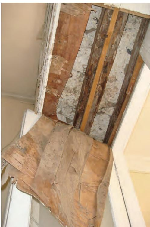
*Izquierda: el forro de madera que oculta el dintel, decorado como las hojas de las puertas, se ha desprendido. Abajo: las ventanas, que al exterior tienen el cuerpo entero acristalado, mantienen en el interior se un peto fijo de madera, que se extiende a las jambas para seguir el diseño cuando las hojas están abiertas y plegadas.*
