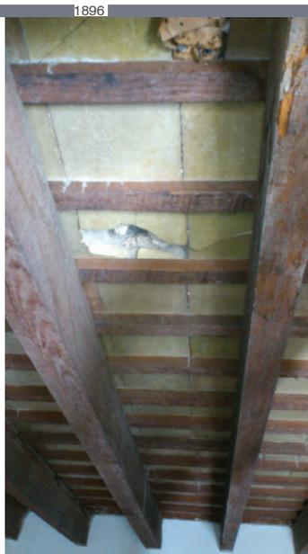
*En la torre de la Iglesia del Corazón de María el techo se forma con ladrillos silicocalcáreos apoyados sobre rastreles de madera, que a su vez apoyan en las vigas de madera.*
