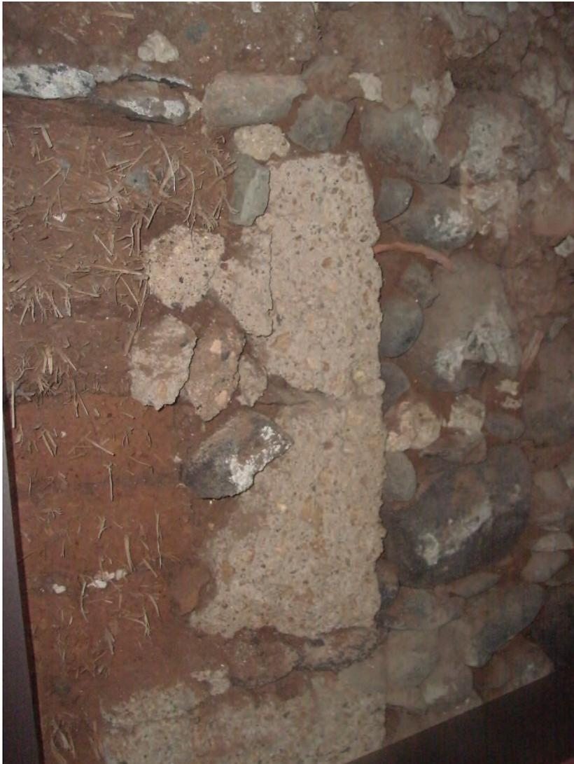
*Parte de muro de adobe que ha quedado al descubierto, protegido tras un cristal, después de la rehabilitación del inmueble. Se observan restos de las fibras vegetales utilizadas para dotar de mayor estabilidad al material.*
