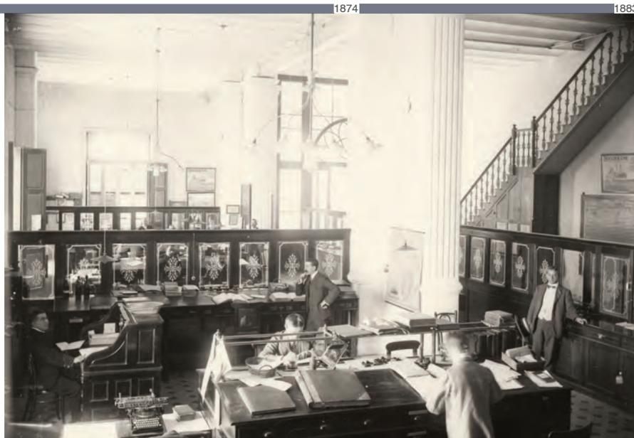
*Oficinas de la empresa Elder en 1907. Se aprecia la estructura de techos de vigas metálicas y columnas de fundición. Fotografía de Luis Pérez Ojeda. Fuente: FEDAC*
