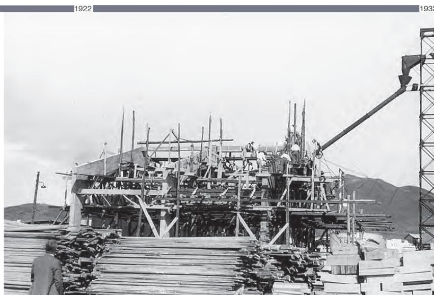
*En primer plano: acopio de madera para la elaboración de encofrados. Al fondo: obras de ejecución de tinglados de hormigón armado en el Puerto de La Luz. Fuente: Archivo de la Autoridad Portuaria de Las Palmas.*
