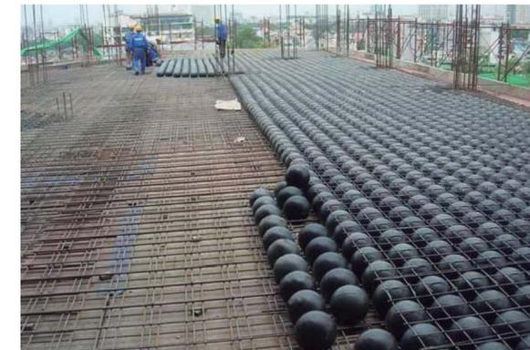
Sistema de Forjado Bidireccional con Esferas Plásticas
