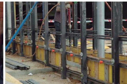
Ejecución del Muro de Tapial mediante compactación mecánica
