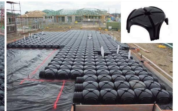
Sistema de Encofrado perdido de Cúpulas de PVC
